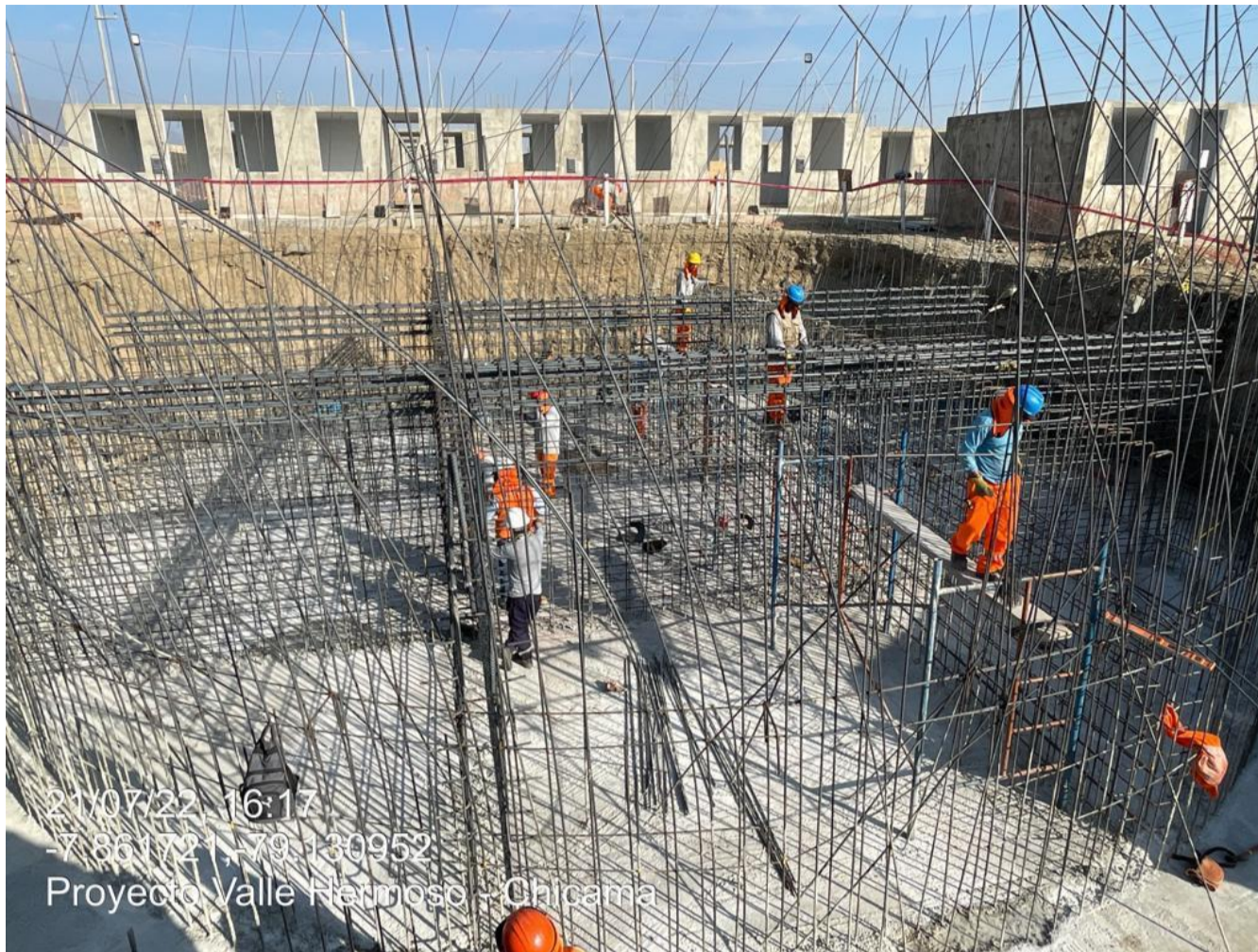
Fig.31. Armado de acero de viga circular 1 de cimentación.
