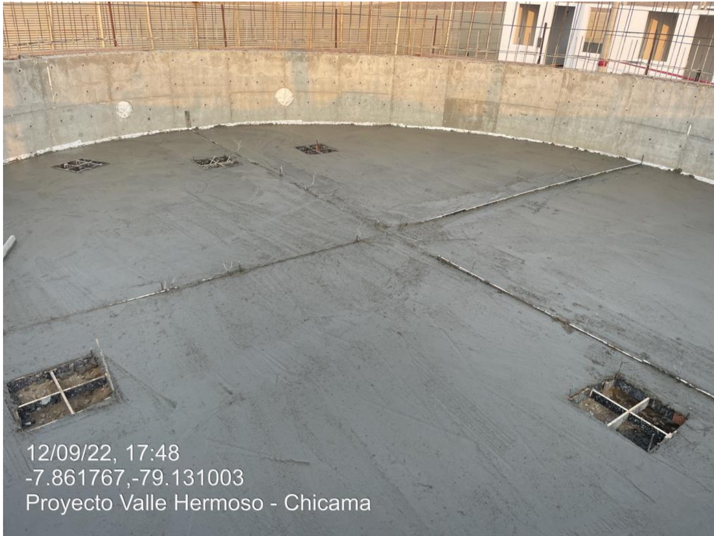
Fig.35. Vaciado de falso piso nivel +0.00.
