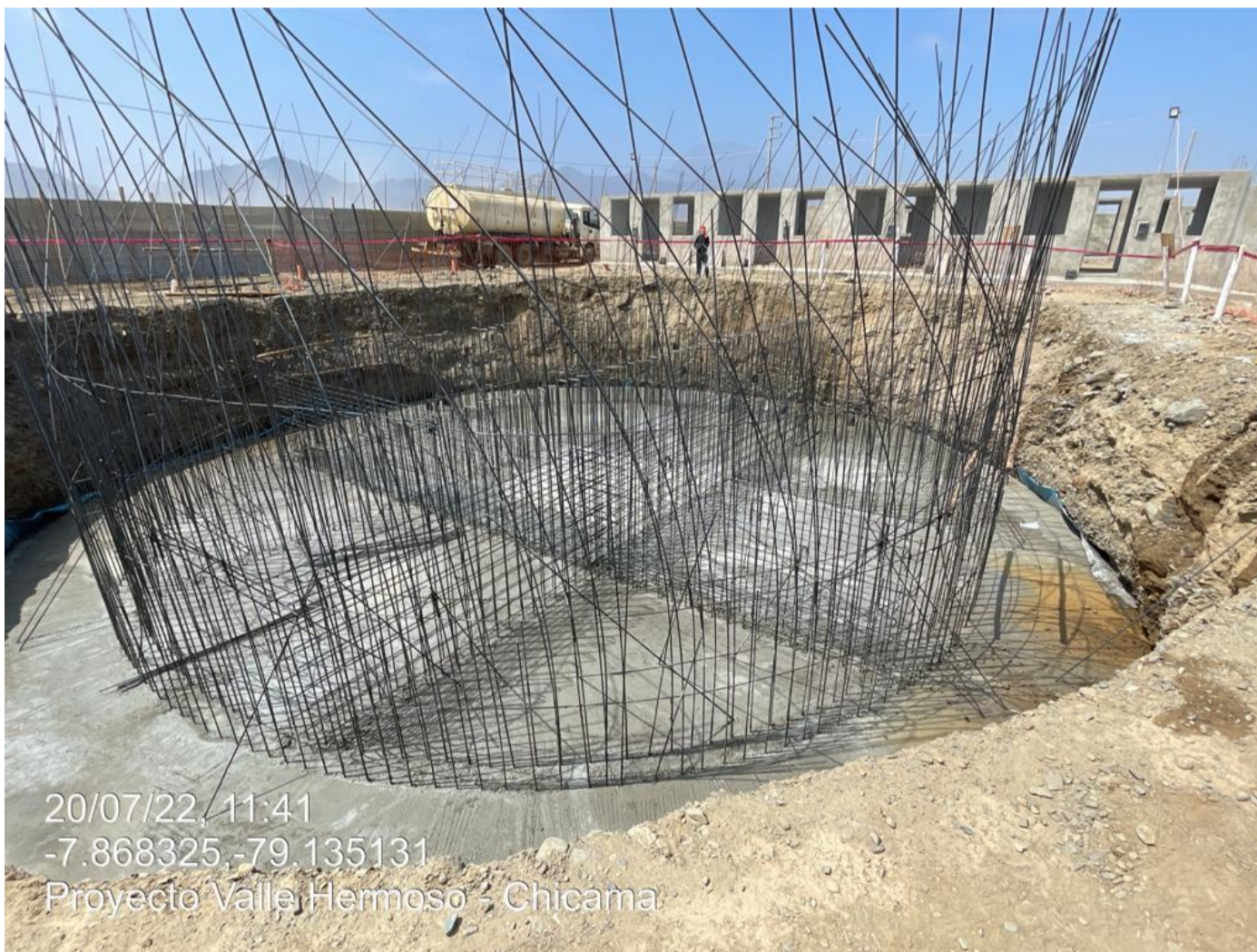
Fig.29. Armado de acero inferior y superior de platea de cimentación.
