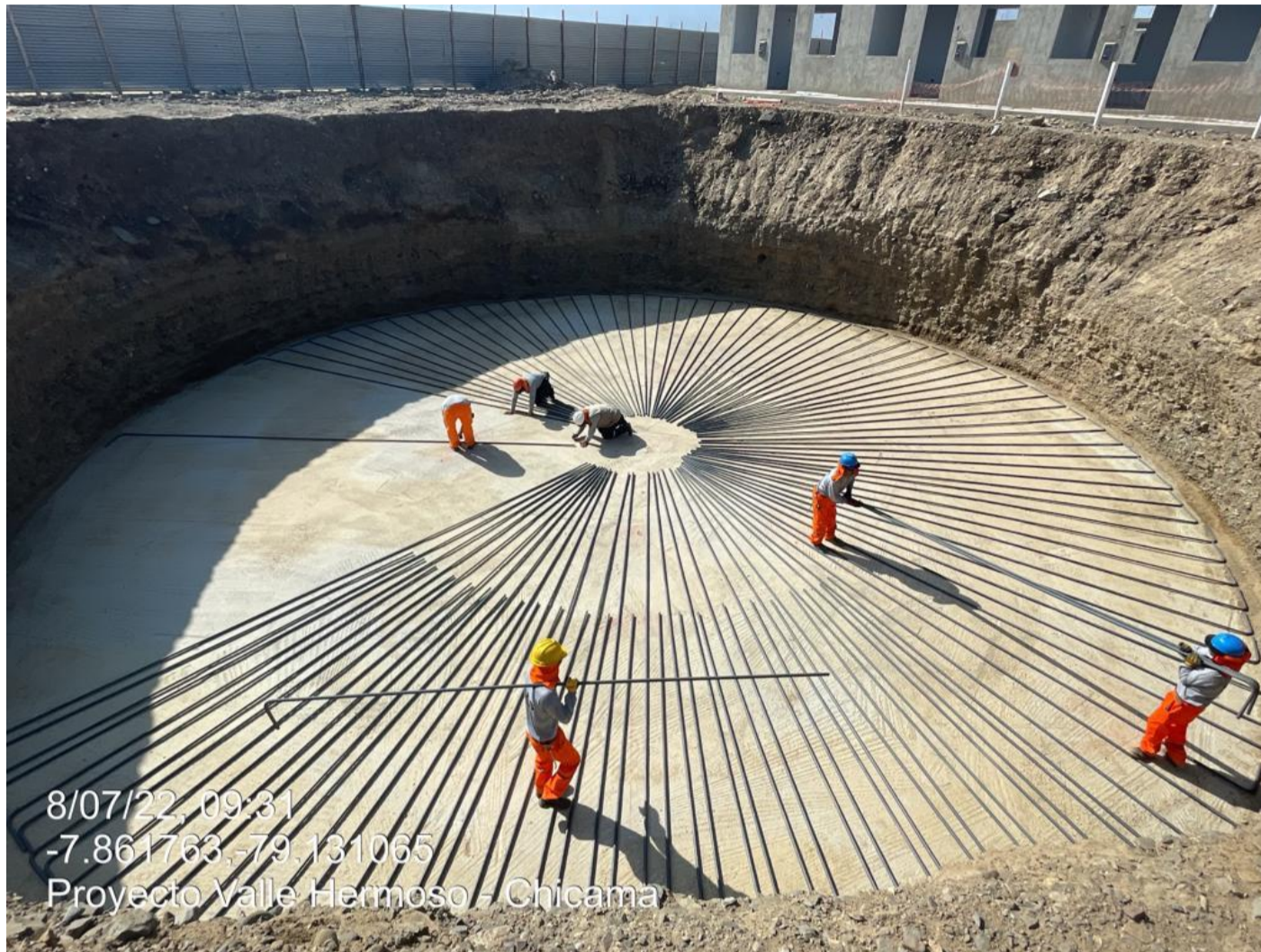
Fig.27. Solado y armado de acero inferior de platea.
