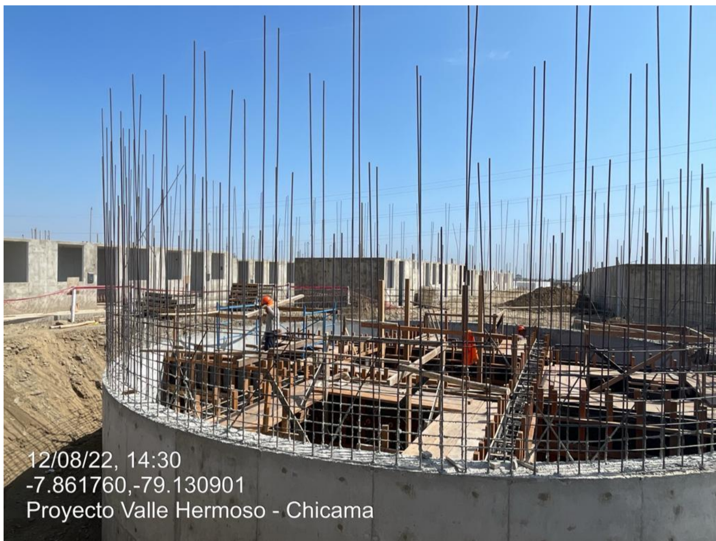
Fig.33. Vaciado de concreto f'c=280 de viga circular 2 de cimentación.
