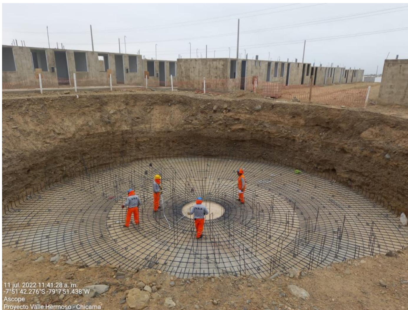
Fig.27. Solado y armado de acero inferior de platea.
