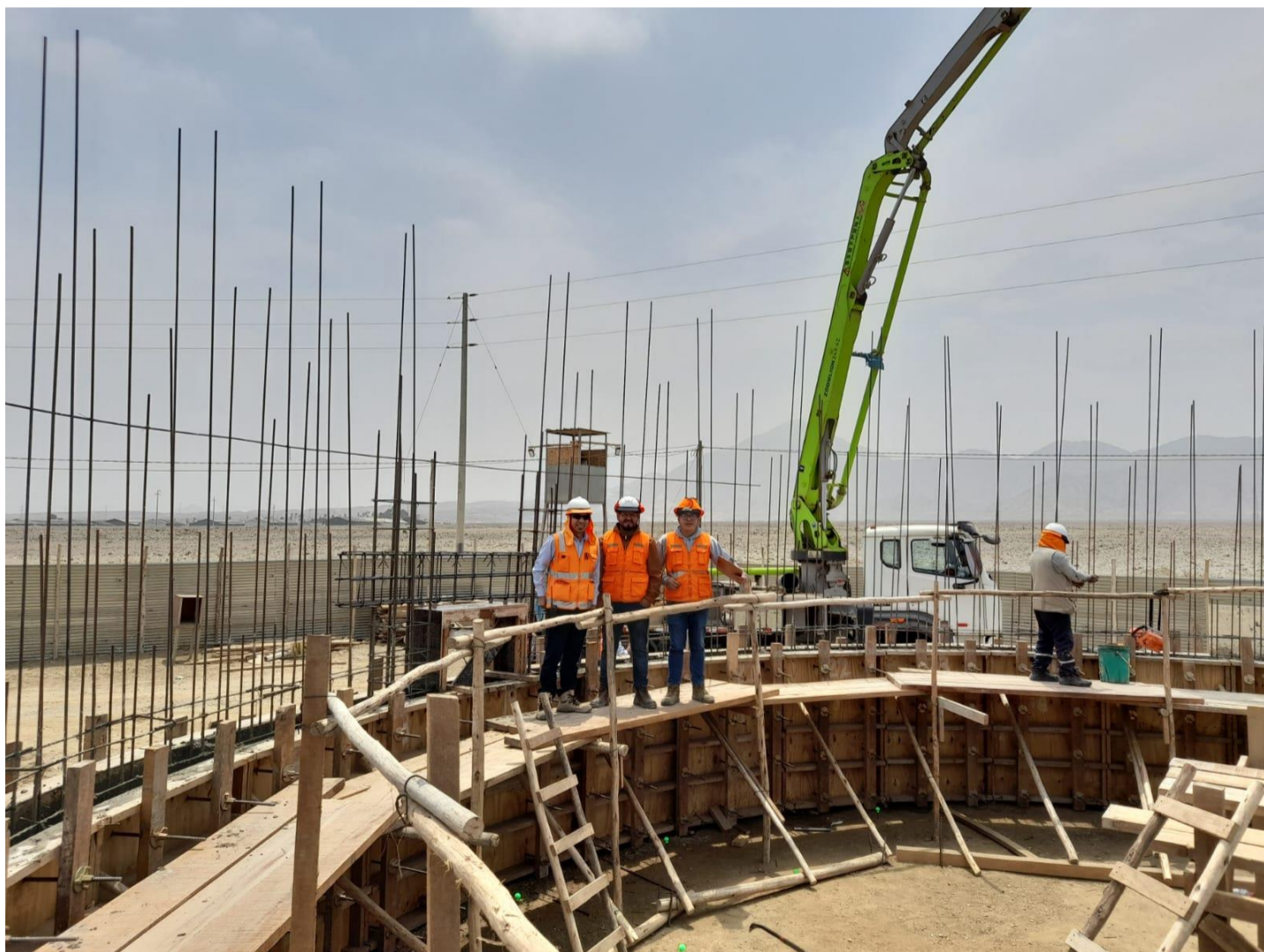
Fig.35. Vaciado de falso piso nivel +0.00.
