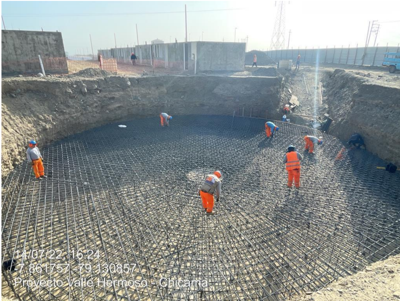
Fig.29. Armado de acero inferior y superior de platea de cimentación.
