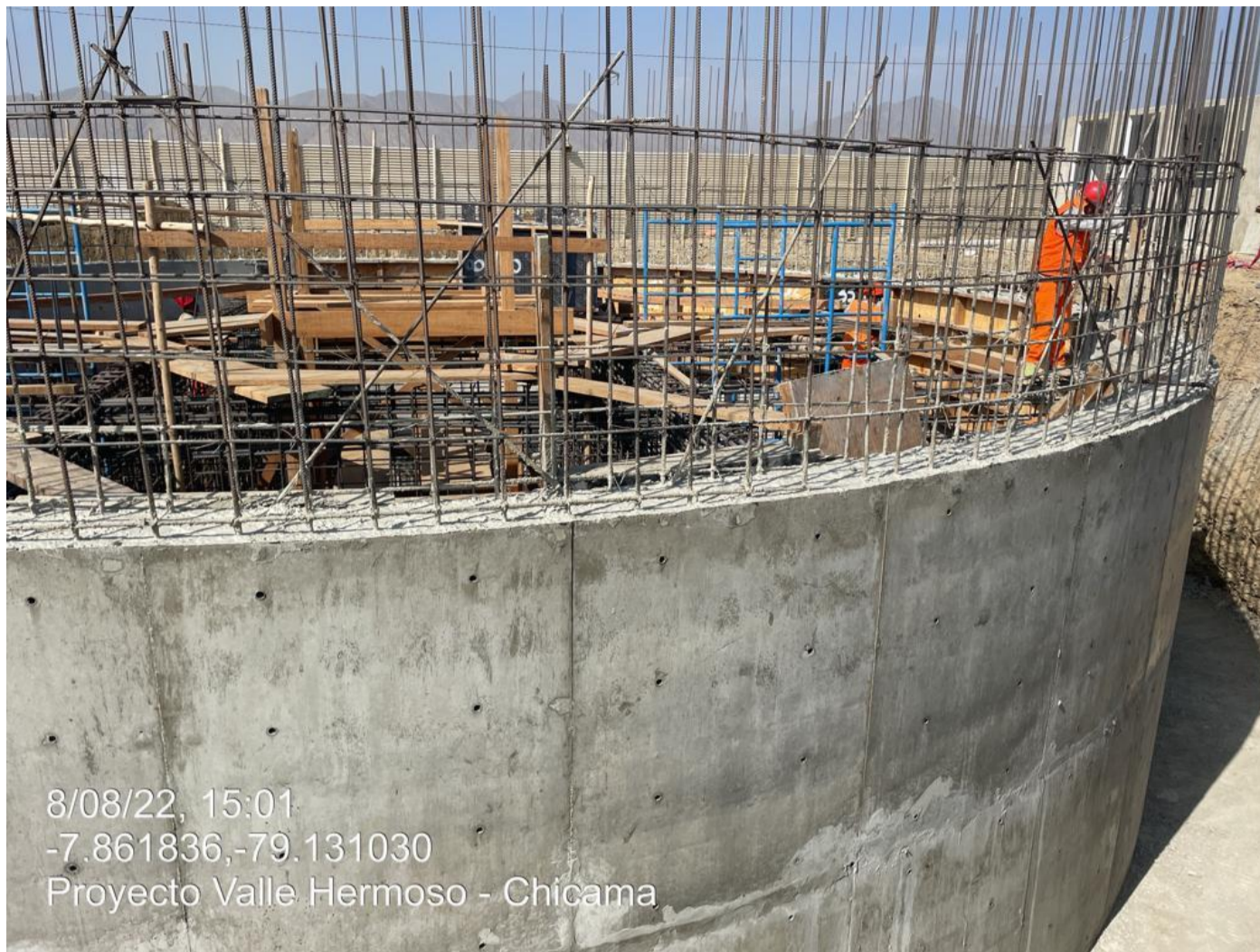
Fig.33. Vaciado de concreto f'c=280 de viga circular 2 de cimentación.
