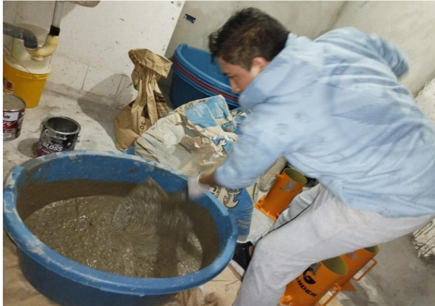
Nota: luego que ya se mezcló con la mano para tener una mejor consistencia en la mezcla y debido al peso de ello se realizó con la palana.
