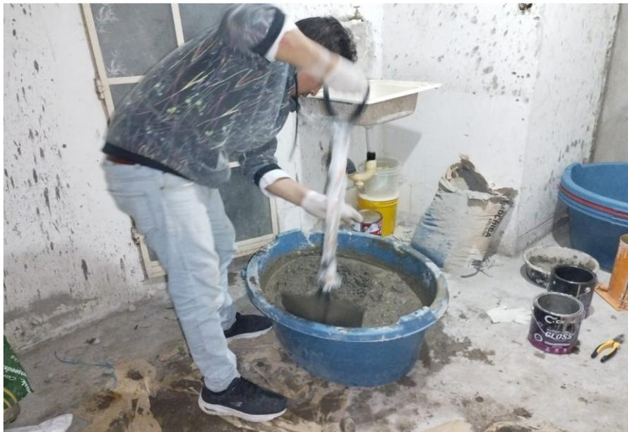
Nota: Luego de completar los materiales junto con el agua, y el mezclado con la mano se realiza otra vez dicha unión con la palana.
