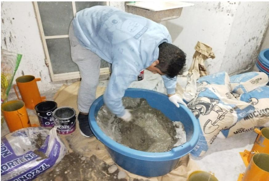
Nota: luego que ya se tiene todo el material para el concreto se procede a mezclarlo, primero debido al ambiente corto para dicha mezcla la hice con la mano.
