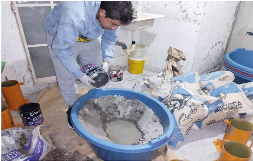
Nota: Como tercer paso para completar la mezcla, una vez ya vaciado el cemento y el hormigón en las cantidades necesarias para la mezcla 1:10 se mide el agua para ser vaciada a la tina.
