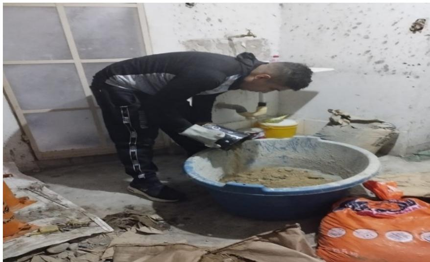
Nota: Para el tercer tramo de las 20 probetas en semana 14 ya teniendo en cuenta los procesos necesarios se comienza a realizar tal labor, primero ya teniendo todos los moldes lavados se procede llenar la tina con el hormigón.
