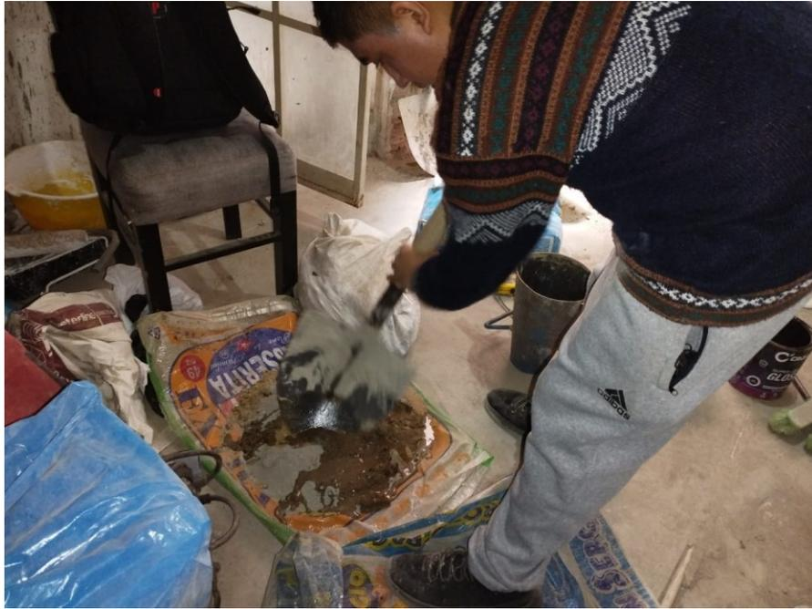
Nota: Juntando el hormigón de Trujillo en mezcla 1:10 con el cemento tipo 1 aplicado para mi proyecto.
