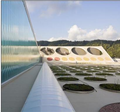
El edificio utiliza el agua y la energía generada por la propia planta. El agua proviene principalmente de la recolección de aguas lluvia y la energía necesaria se obtiene a partir del biogás generado por los residuos encontrados en los vertederos vecinos de Coll Cardús. Los diferentes círculos contienen tierra, grava, y las cubiertas vegetales y arbustos nativos. Con el tiempo, va a equilibrar el impacto de la instalación sin recurrir al camuflaje o mimetismo.
