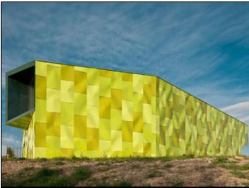
La volumetría contorsionada se envuelve mediante escamas de un mismo material y con mismo sistema constructivo fachadas y cubierta: chapas de gran formato (2,5mx1,5 m)de hojalata de aluminio reciclado lacado, de espesor mínimo.
