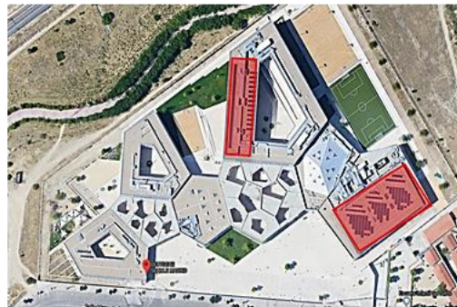
Figura**: Vista satelital de la ubicación de los paneles solares del colegio Alemán de Madrid. Fuente:Detail documentation.
