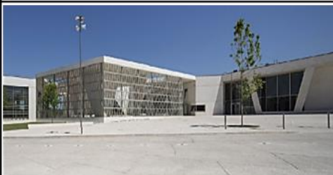
Acceso Primaria y Secundaria.
