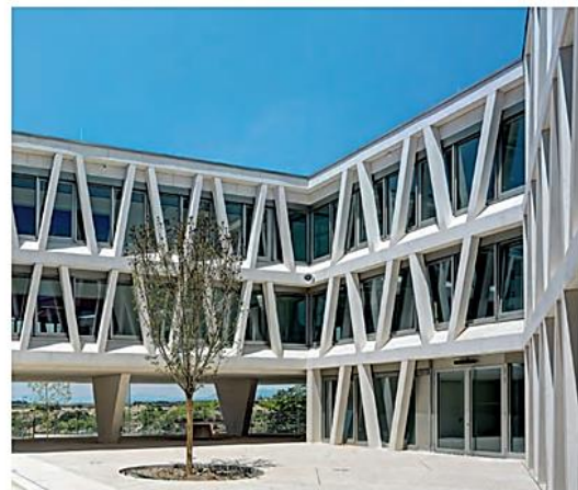
Figura**: Relación entre ambientes exteriores e interiores colegio Alemán de Madrid. Fuente:Detail documentation.
