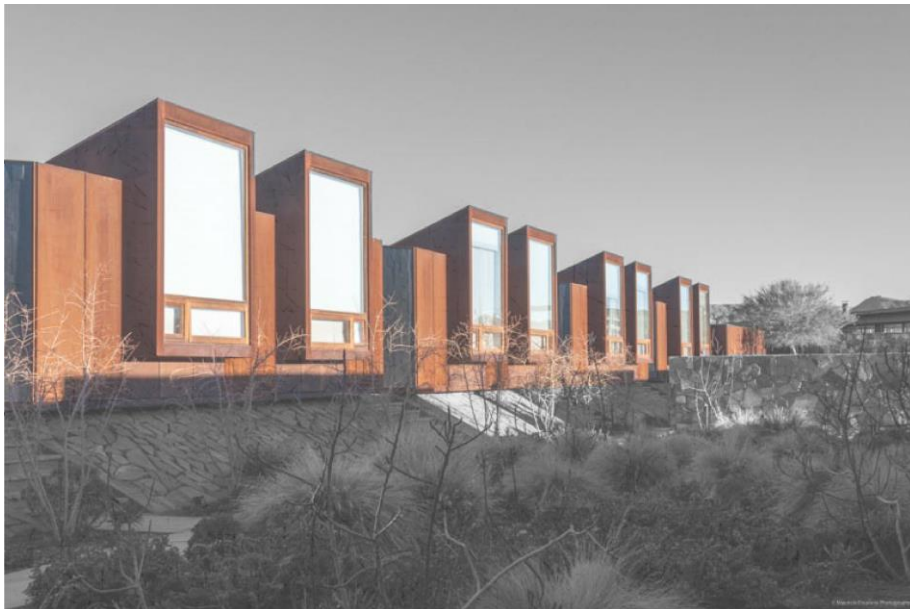
Figura 36: Fachada “Hotel Tierra Atacama”
