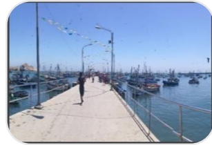
Muelle artesanal con infraestructura obsoleta • No se respeta los requerimientos de seguridad en un muelle artesanal.
