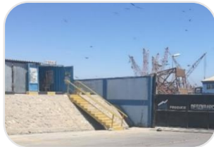
Ingreso • Sistema vial incorrecto
