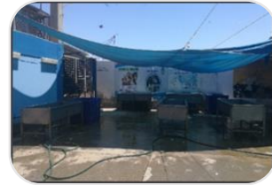
Zonas de lavado-espacios de circulación • Desarrollo de actividades productivas (lavado y despacho) en ambientes inadecuados (circulación)
