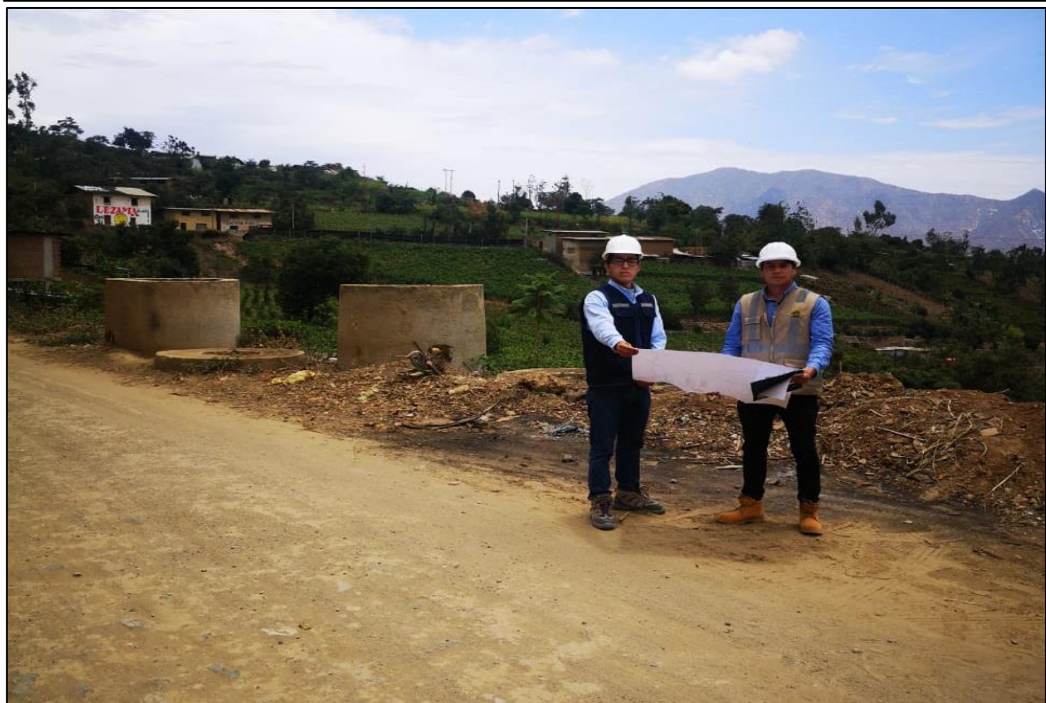
Foto N°5: Zona donde estará ubicado la línea de impulsión de aguas residuales del sistema de alcantarillado sanitario, debió a que en ese punto la cota de terreno comienza a crecer, entonces ya no cumpliría un sistema a gravedad.
