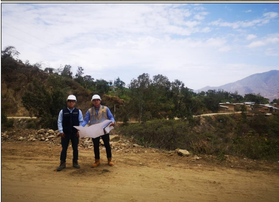
Foto N°4: Lugar donde se ubicará el pase aéreo de 80 metros de longitud, del sistema de alcantarillado sanitario, en compañía de área de gerencia de obras y desarrollo urbano de la unidad ejecutora Municipalidad Provincial de Gran Chimú.
