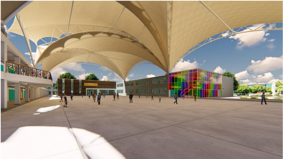
Figura 49: Vista General de los Pabellones de Aulas
