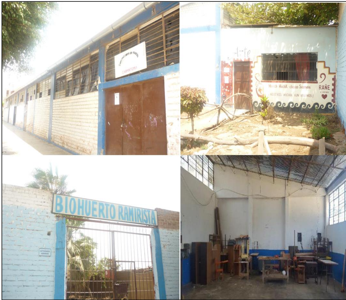
Figura 9: Estado Actual del P-05
