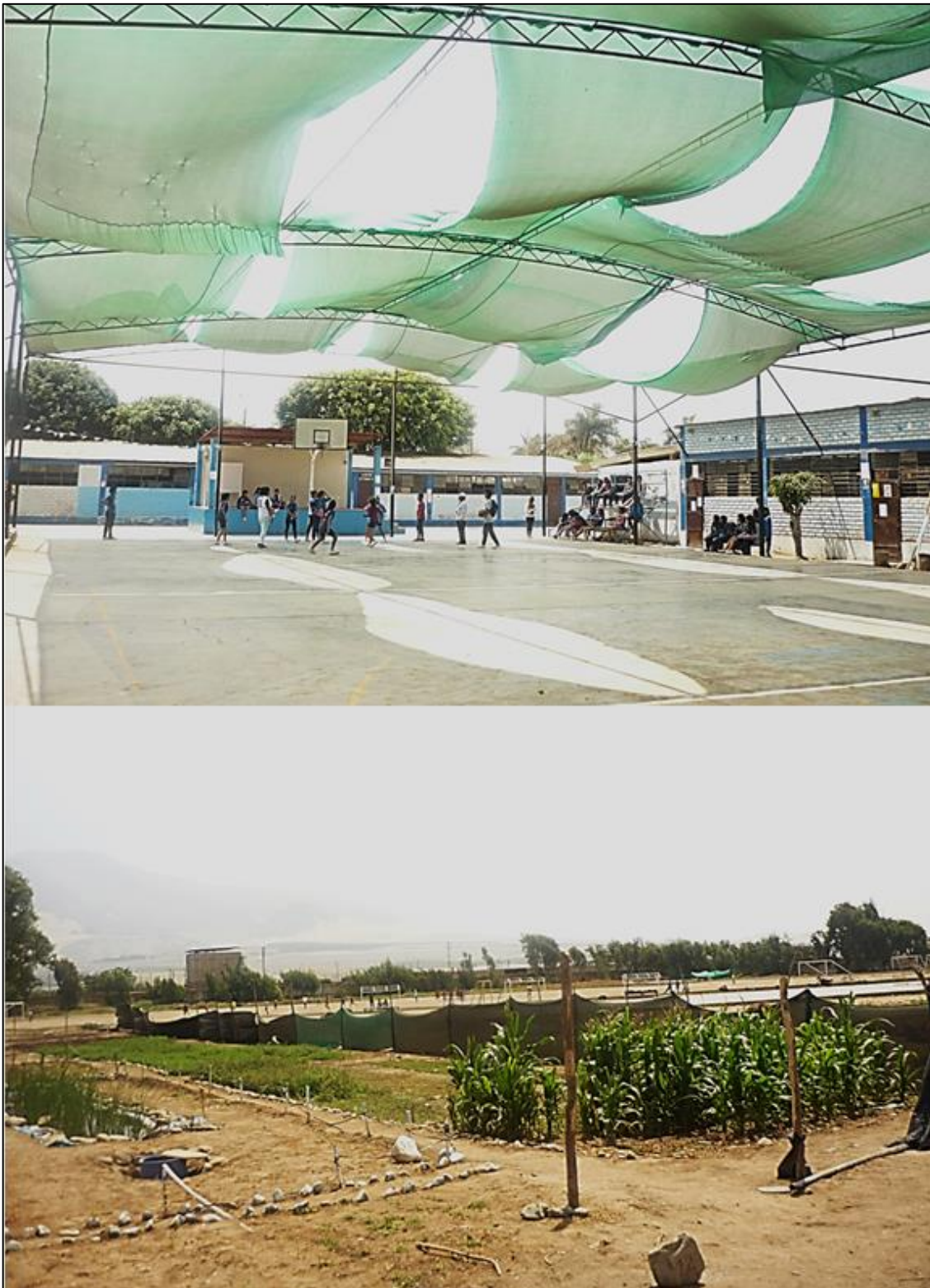
Figura 12: Estado Actual de los Espacios Deportivos
