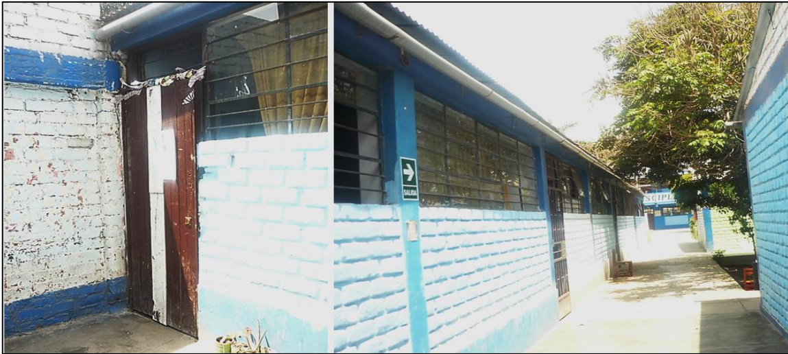
Figura 6: Estado Actual del P-02
