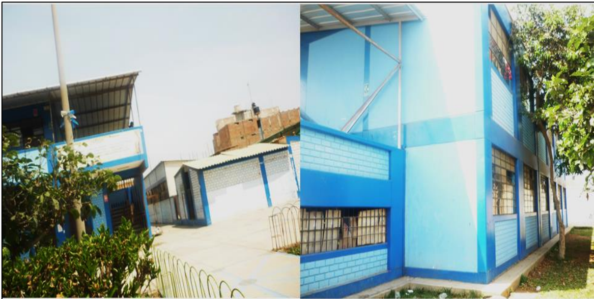
Figura 5: Estado Actual del P-01
