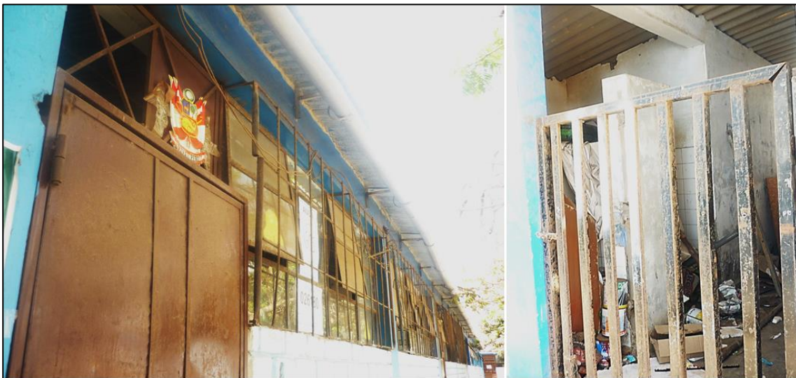
Figura 7: Estado Actual del P-03
