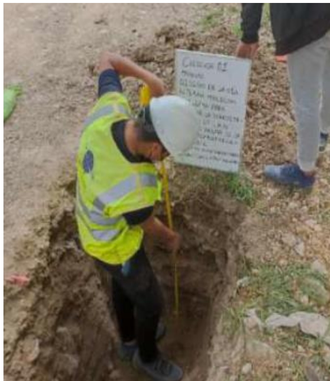
Fotografía 3. Medición de la profundidad de la calicata.
