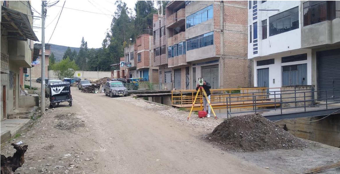
Fotografía 17. Levantamiento topográfico en lugar de estudio.
