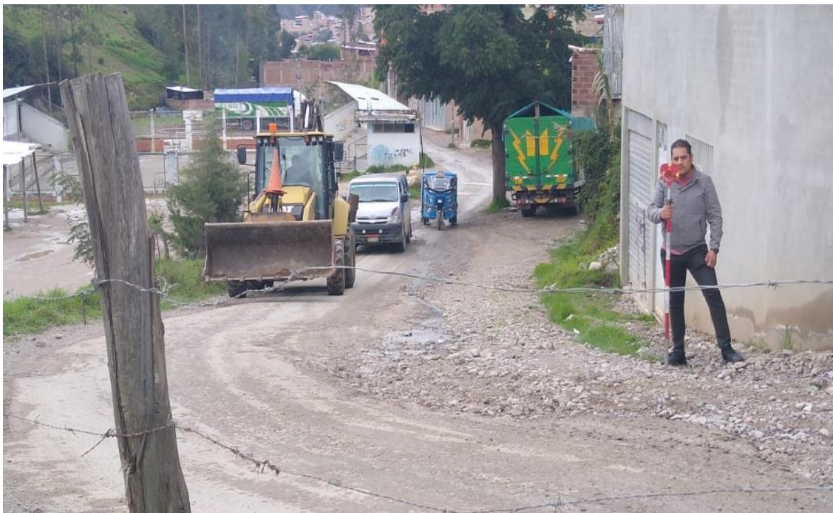
Fotografía 18. Levantamiento topográfico en lugar de estudio.
