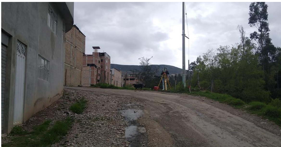
Fotografía 16. Levantamiento topográfico en lugar de estudio.
