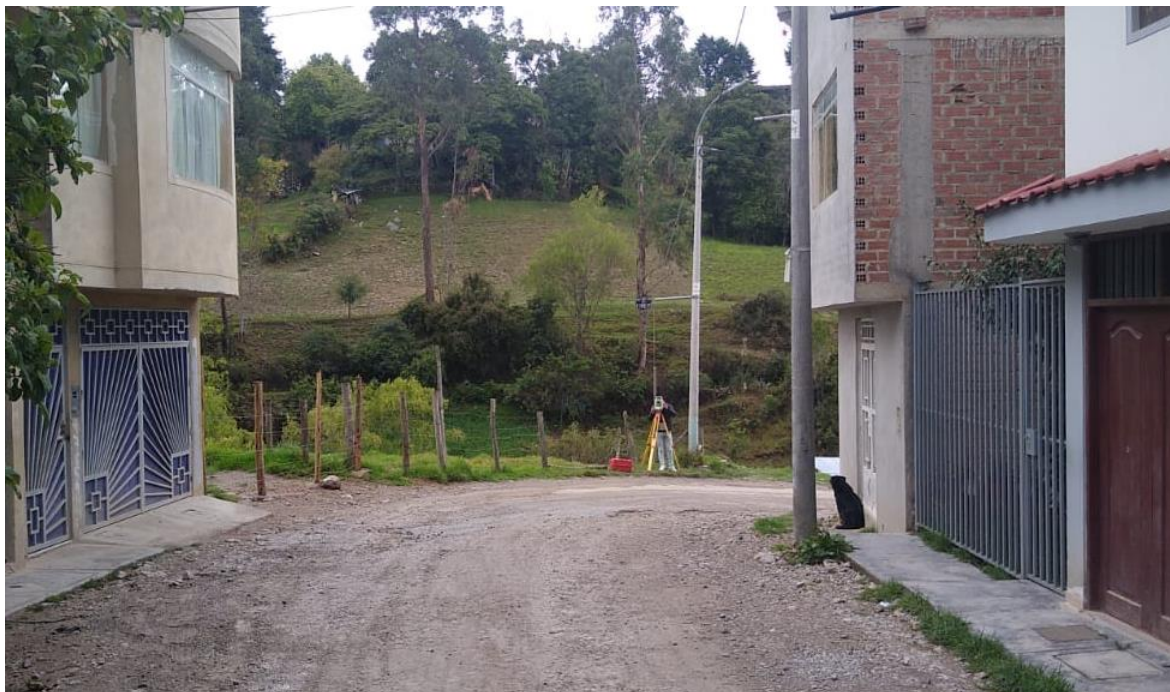
Fotografía 15. Levantamiento topográfico en lugar de estudio.
