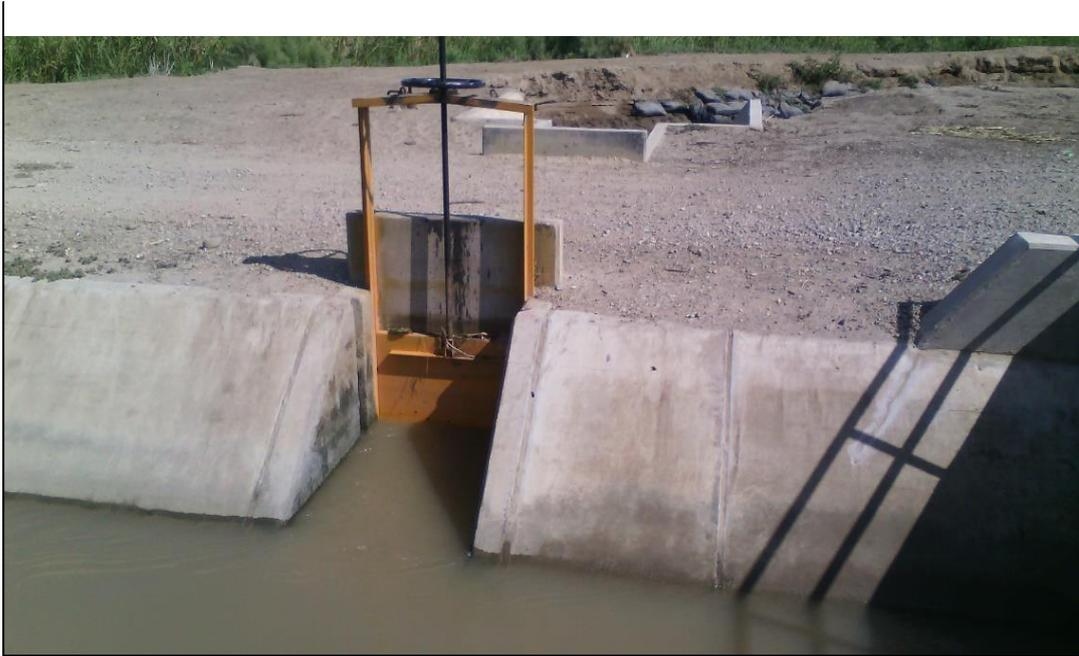
Fotografía 1. Se aprecia la progresiva 1+850.00 km del Canal Principal o Ramal Nuevo con su respectiva compuerta metálica de donde se inicia el Canal Santa Elena
