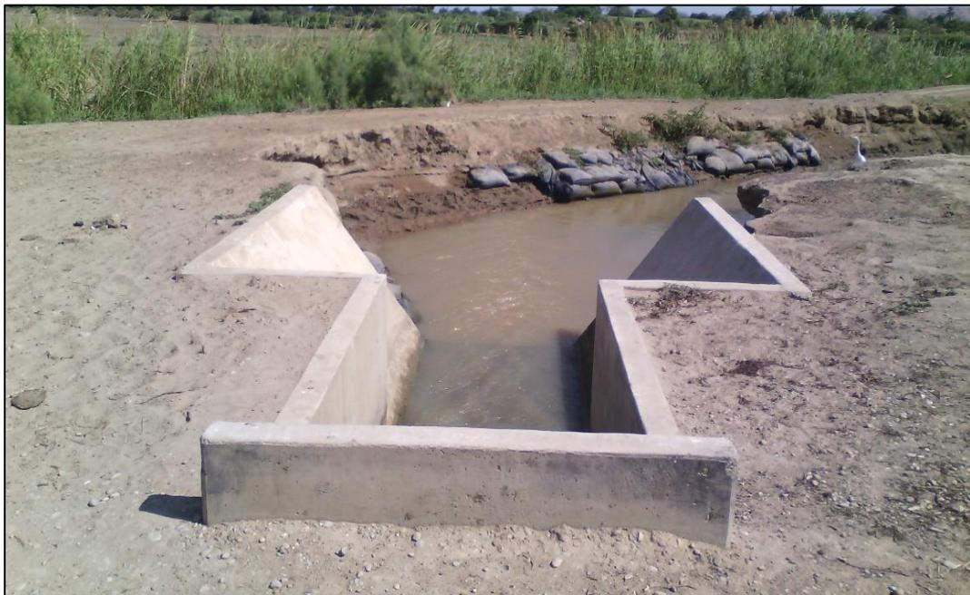
Fotografía 2. Se aprecia la Estructura de Entrega e Inicio del Canal Santa Elena progresiva 0+000.00 km la misma que se encuentra operativa y en buenas condiciones.
