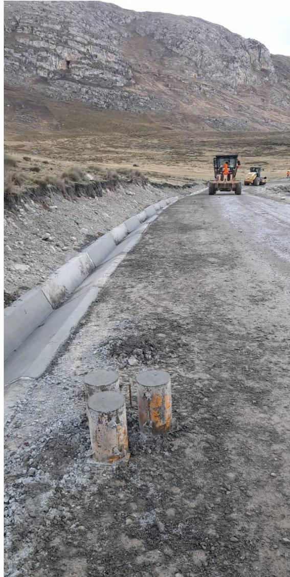
*Nota.* En la Fotografía, maquinaria pesada trabajando en la Obra y probetas muestra para posterior rotura y comprobación de la Resistencia a la compresión del concreto empleado en cunetas y cumplir con especificaciones técnicas, para la Calidad del concreto. Fuente: Propia de los Tesistas.
