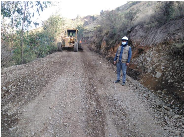
Nota. Fotografía Motoniveladora en trabajos de mantenimiento en camino vecinal *Santa Fe de Carrizal – Miraflores*. Fuente : Propio de Tesistas
