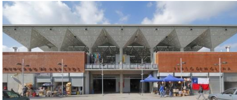
Figura 9: Fachada principal Mercado San Tirso de Molina
