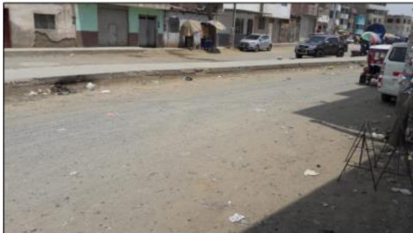
Fotografía N° 01: Vista de Av. Pucará – Trujillo.
