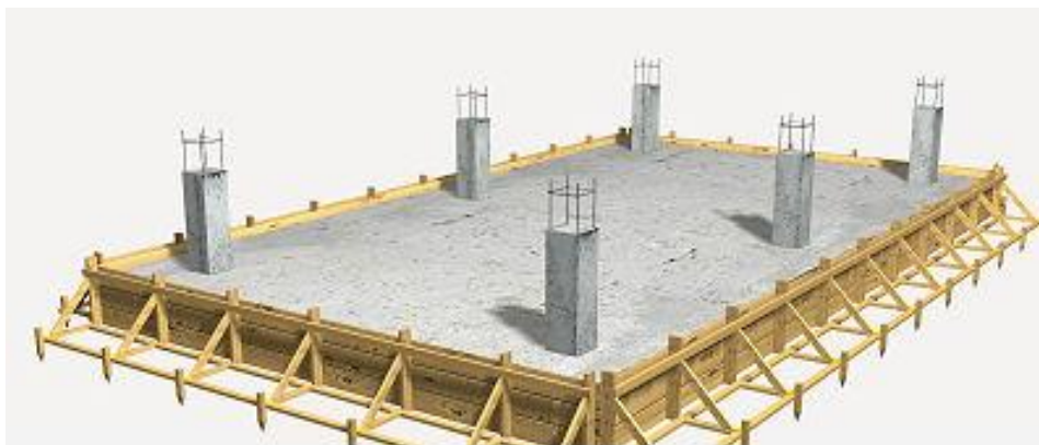
FIGURA 48. Platea de cimentación
