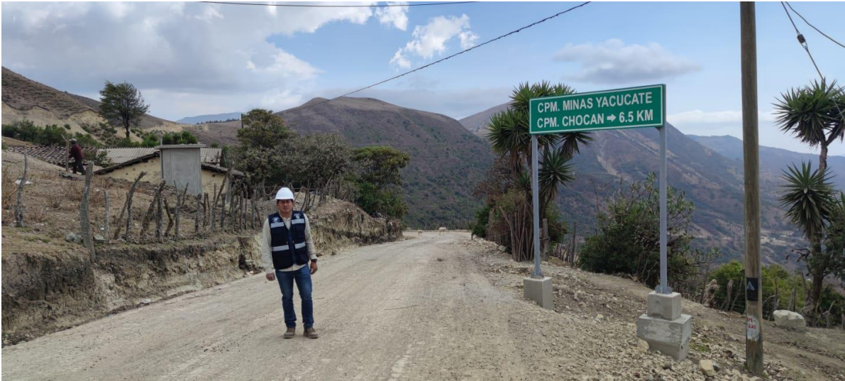
Visita de Campo – Carretera Mostazas - Chocán
