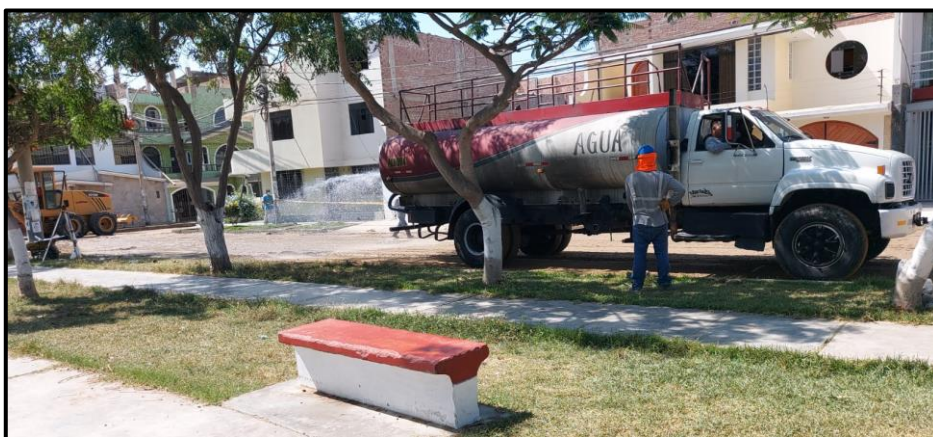
Se realizó el Riego de la zona de trabajo para mitigar la contaminación ambiental.
