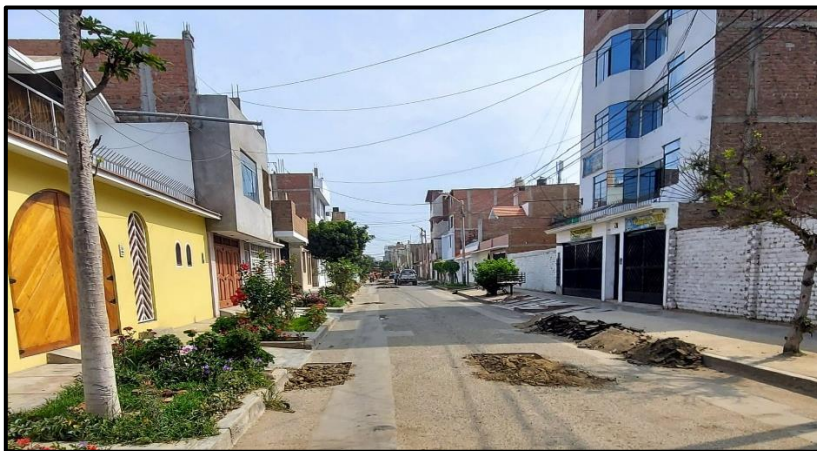
Se realizó la Reposición de base en parche.
