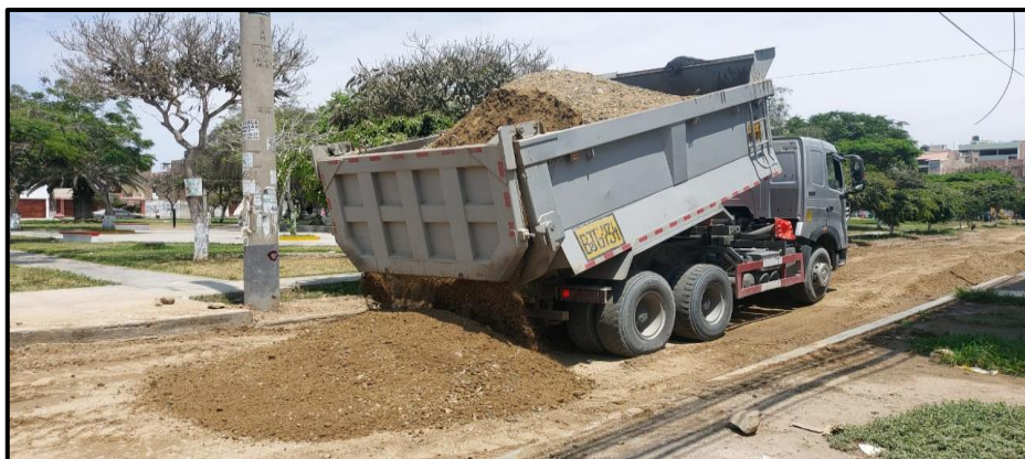
Se realizó la Colocación de base granular e=15 cm.
