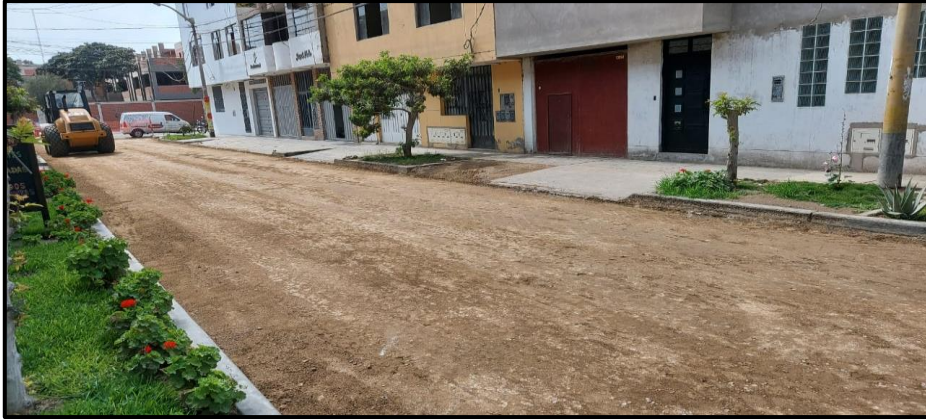
Se realizó el extendido y compactado de Base granular
