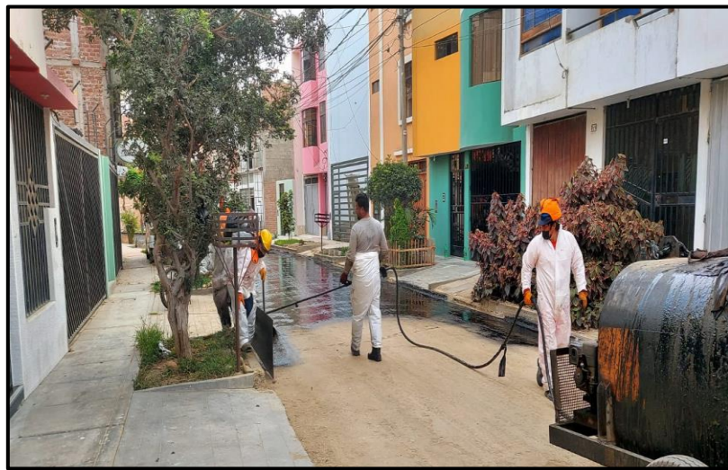
Se realizó la Imprimación de base.
