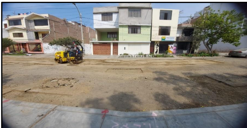
Se realizó el extendido y compactado en parche de la Base granular.
