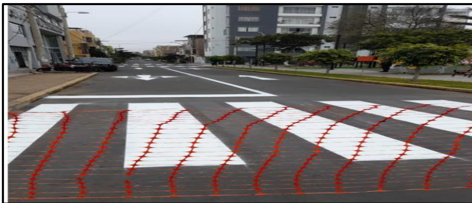
Se realizó el Pintado de la señalización horizontal: líneas y símbolos.
