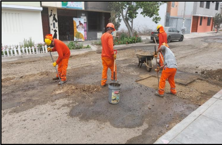
Se realizó el Corte y perfilado de bordes de área de parchado.
