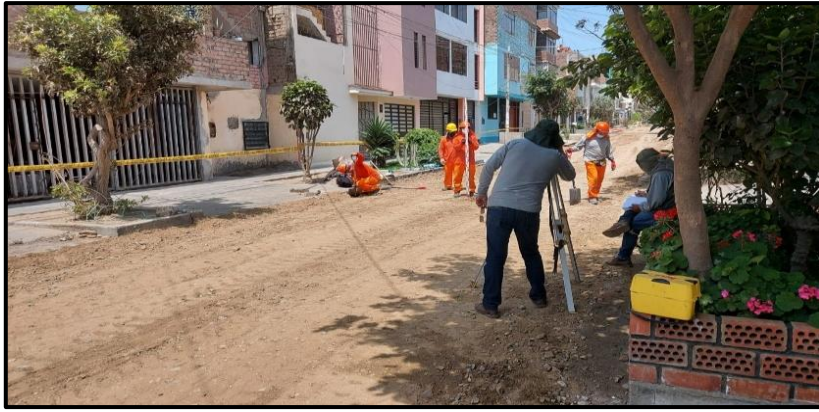
Se realizó la Verificación de nivelación de base.
