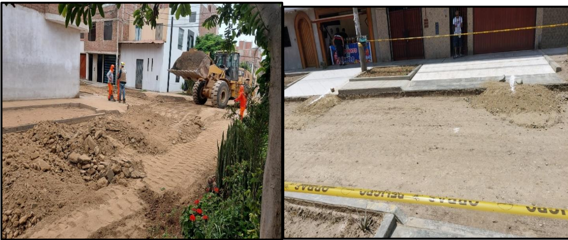
Se realizó el Corte a nivel de subrasante e=15 cm.
