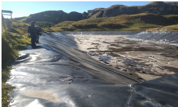
(MINI REPRESA EXISTENTE EN EL CASERÍO DE TRES CRUCES)
