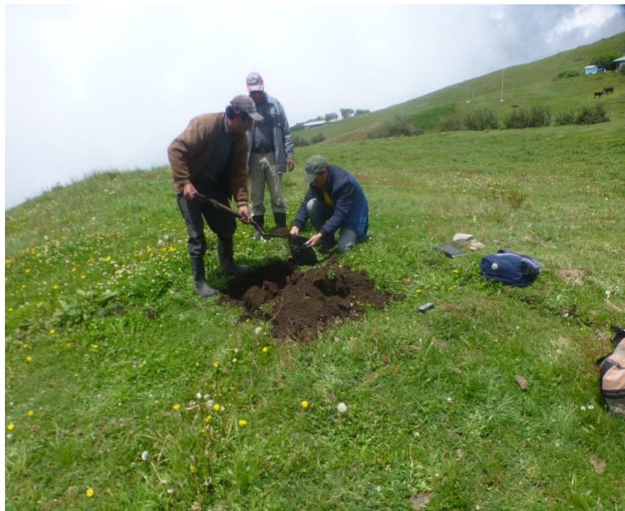
(POBLADORES AYUDANDO A EXCAVAR)
