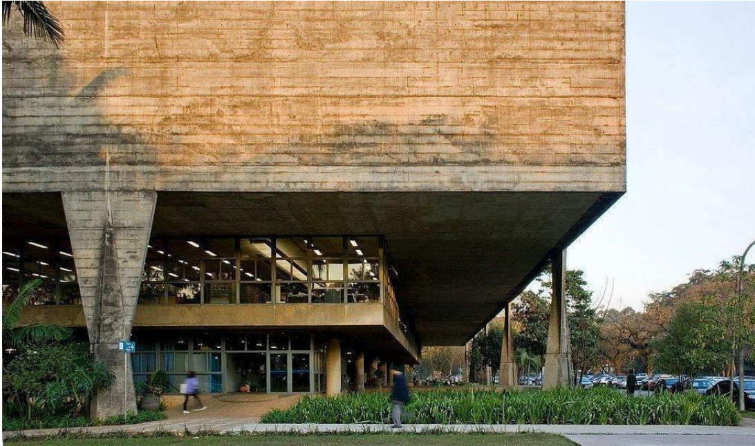
IMAGEN N° 28: FACULTAD DE ARQUITECTURA DE SAO PAULO (FAU/USP)
