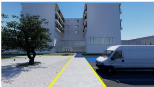
Ilustración 12: Ingreso a área técnica Fuente: Elaboración propia
