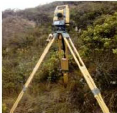
FIGURA N°20: Vista del estacionamiento del equipo para el levantamiento topográfico del terreno.
