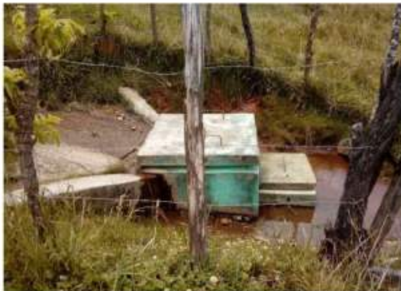
FIGURA N°22: Vista de la captación del Caserío de Huasicaj.
