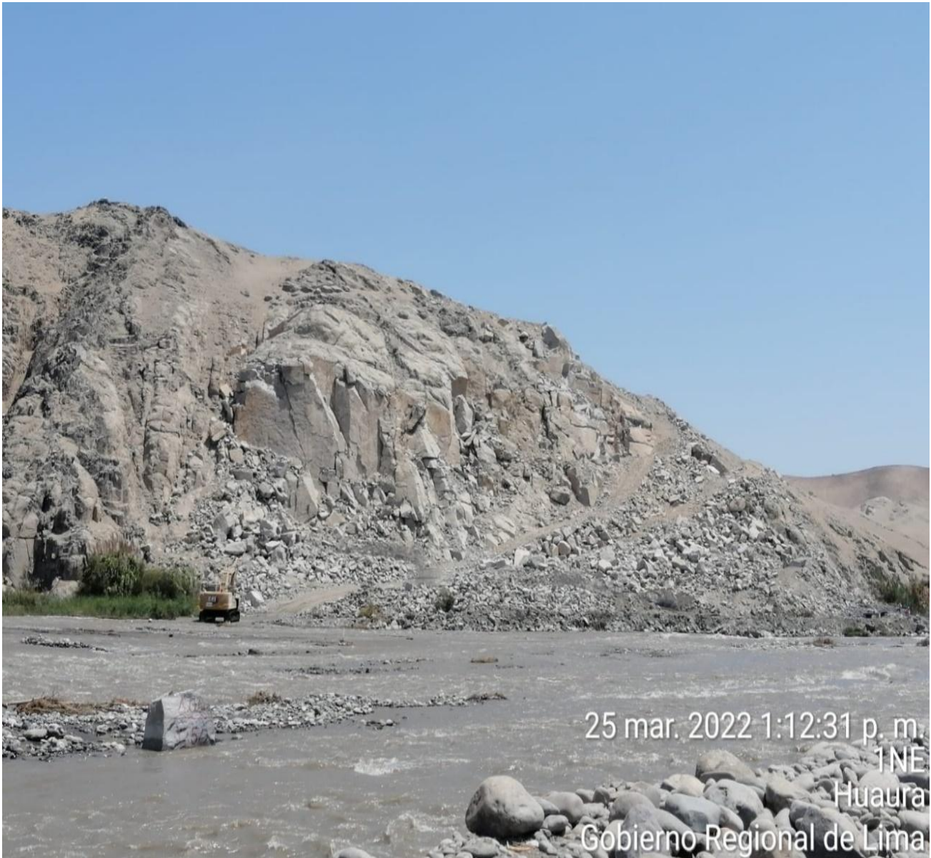
En la toma se muestra la Cantera Cerro X donde explotará Roca para realizar la defensa Ribereña del río Huaura
