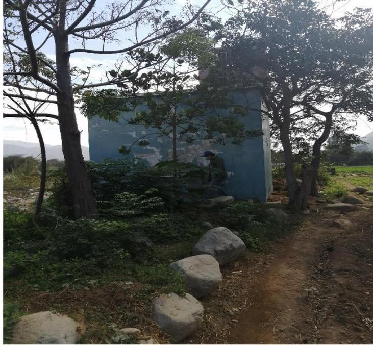
*Figura 12: Caja de válvulas del reservorio 100m<sup>3</sup> existente deteriorado.*
