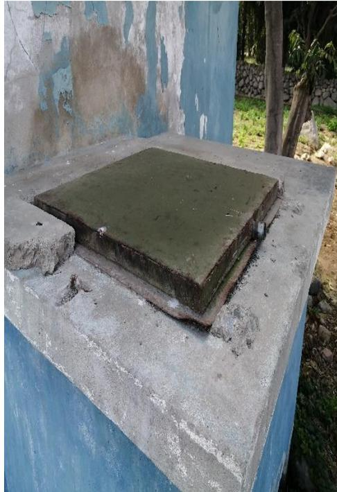
*Figura 13: Caja de válvulas del reservorio 100m3 existente deteriorado.*
