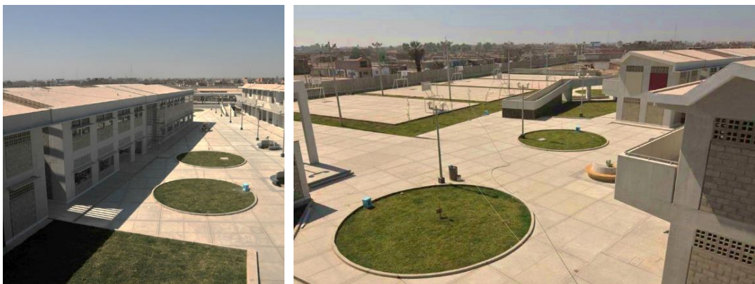
Figura 15. Espacios Exteriores de la I.E. José de San Martín Fuente: Archdaily
