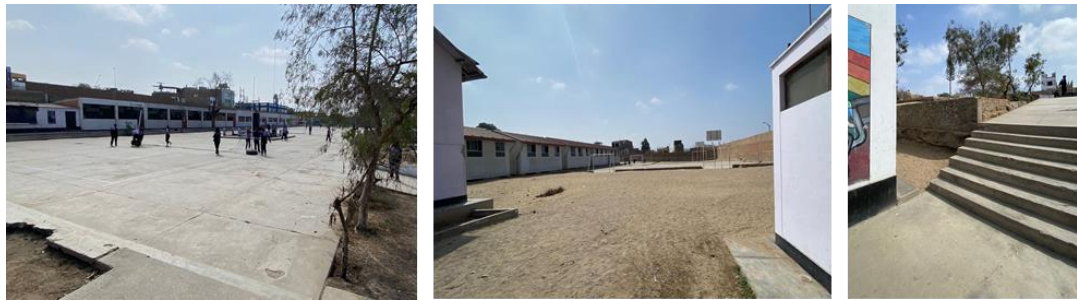
Figura 58. Vistas Espacios Exteriores de la I.E. Túpac Amaru II Fuente: Visita de Campo
