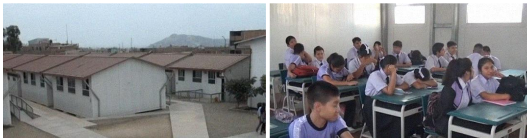
Figura 55. I.E. Túpac Amaru II - Aulas prefabricadas para el nivel secundario Fuente: UPAO Noticias
