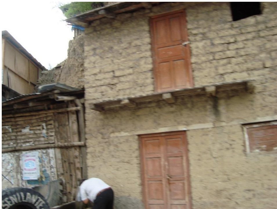
Figura 5. Vivienda típica de adobe en Chiple (Cutervo, Cajamarca, Perú).
