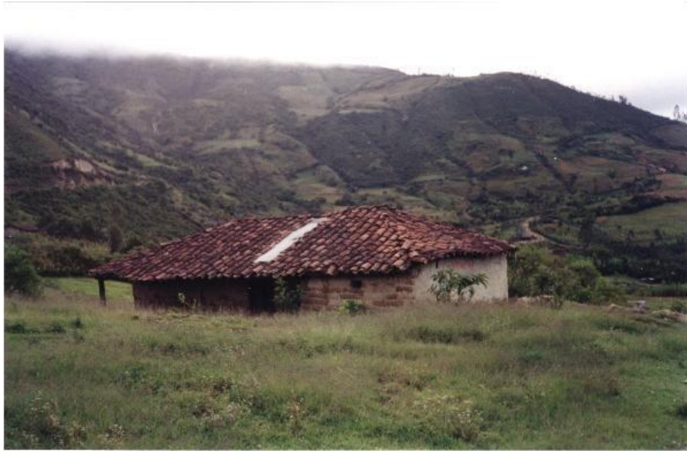
Figura 2. Vivienda típica de los pobladores de Ayabaca, Piura, Perú.
