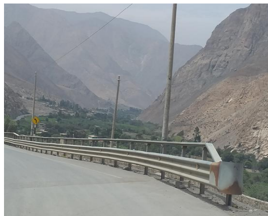
Figura 15: Terminales de las barreras artesanales y a su vez en estado de oxidación.
