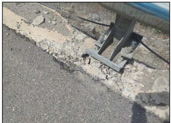
Figura 6: Presencia de anclaje de la barrera de seguridad
