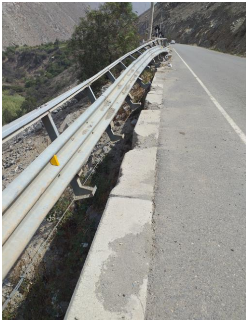
Figura 13: Barreras de seguridad expuesta después del huayco
