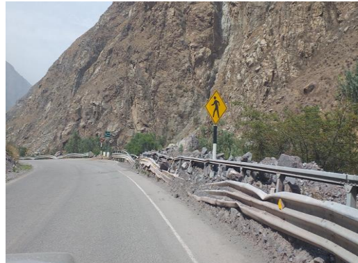
Figura 14: Barreras de seguridad pendientes de análisis, para su reposición.
