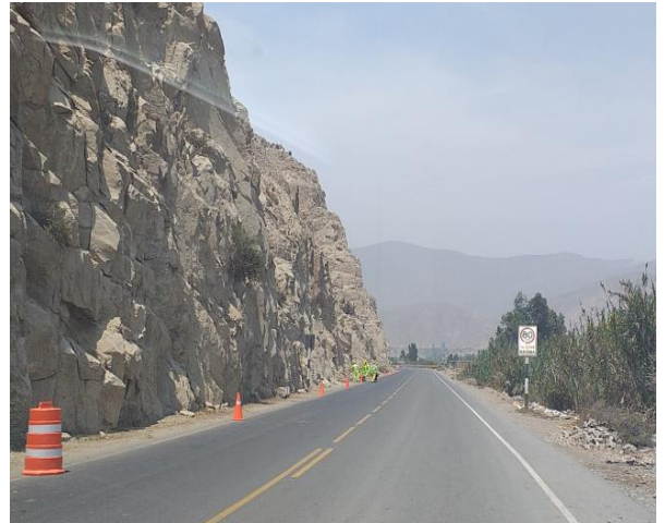
Figura 4: Señal vertical de giba visible y en horizontal no se visualiza, ya que se encuentra sin demarcación.
