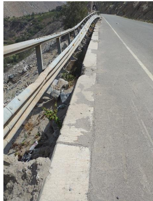
Figura 14: Barreras de seguridad pendientes de análisis, para su reposición.
