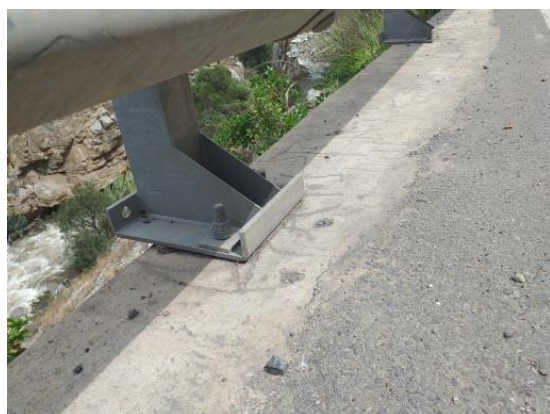
Figura 12: Barreras de seguridad instaladas en zonas samiplanas y/o llanas
