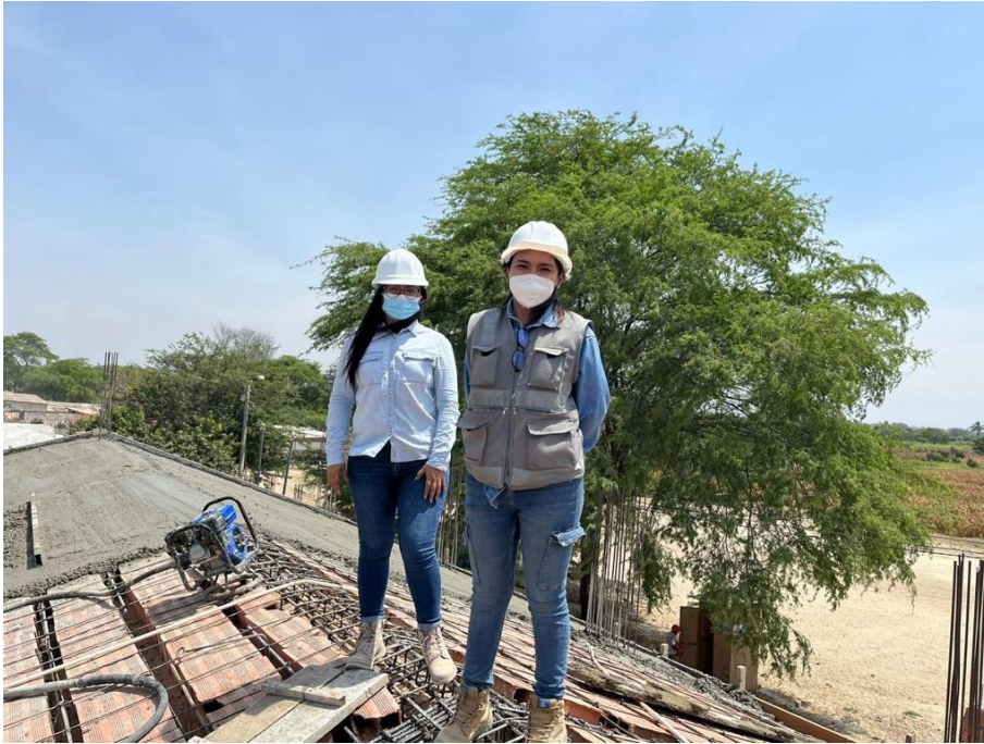
Imagen 1. Control de procesos constructivos.
