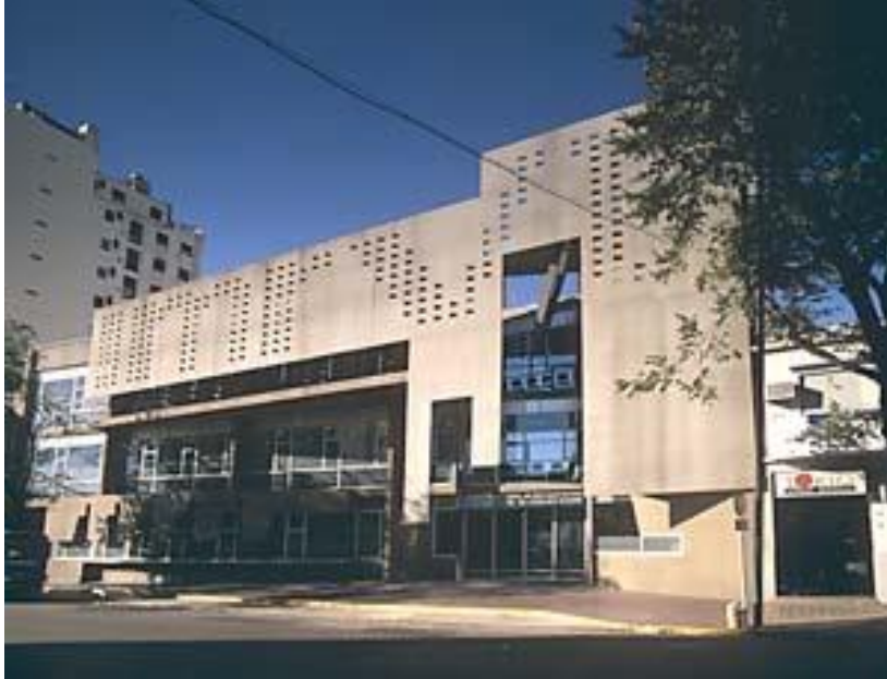
Figura 115: Fachada Centro de Rehabilitación Vicente López
