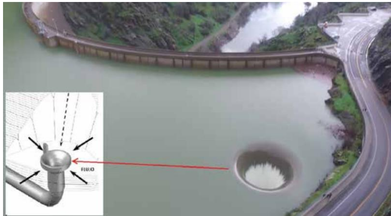
Figura N° 12: Vertedero de conducción cerrada, presa Monticello, USA.
