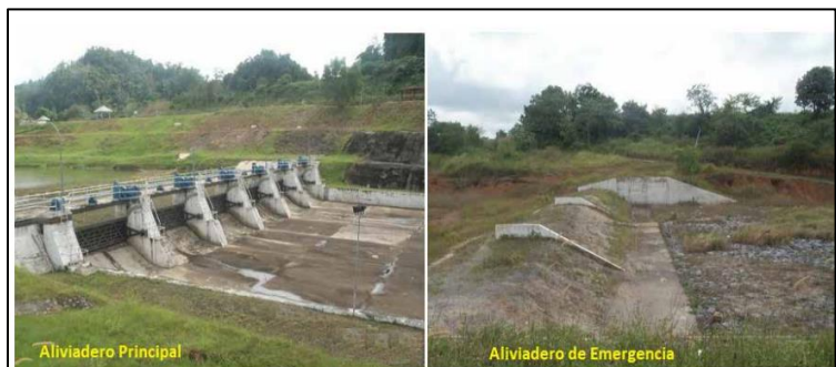
Figura N° 8: Aliviaderos principales y de emergencia de la presa Timah Tasoh, Malasia
