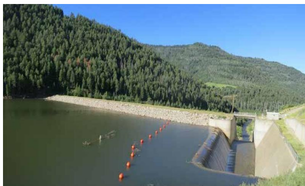
Figura N° 10: Aliviadero lateral de la presa Paonia, USA
