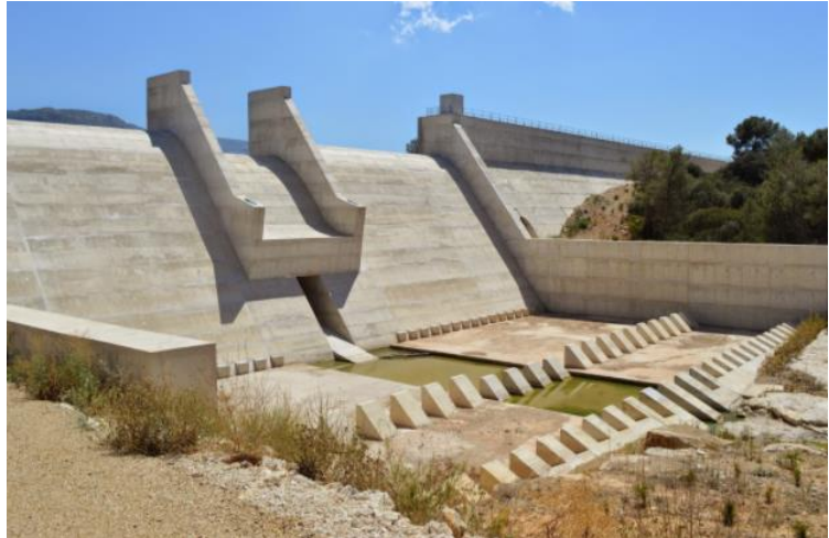
Figura N° 13: Aliviadero dentado de la presa Terrateig
