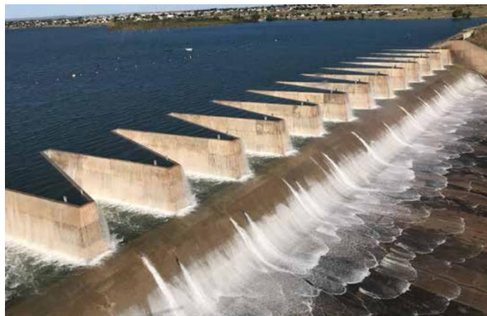
Figura N° 11: Aliviadero tipo laberinto de la presa Ute, USA
