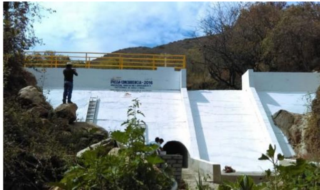
Figura N° 9: Aliviadero de caída libre
