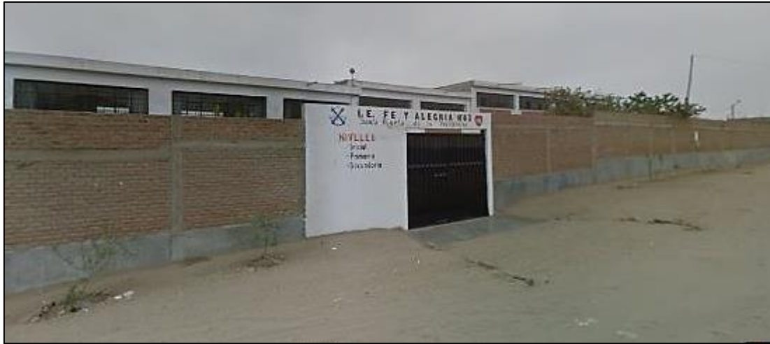
Figura 12 FACHADA PRINCIPAL DEL I.E FE Y ALEGRÍA
