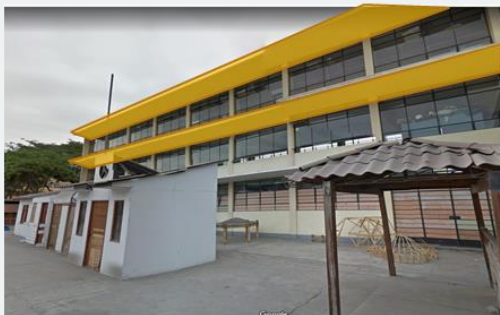
Aleros de fachada Norte
