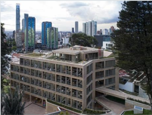
Vista exterior de la facultad de arquitectura de la universidad de los andes – Colombia.
