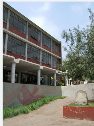
Vista externa de la FAU -UNI
