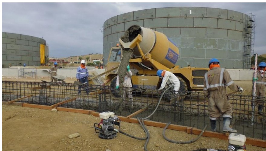
Fotografía 11: Trabajos de vaciado de concreto para anillo de cimentación.
