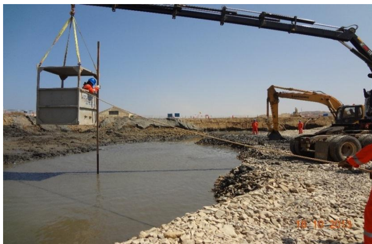
Fotografía 2: Trabajos de nivelación con ayuda de camión grúa.
