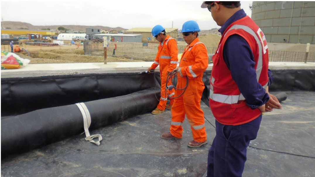
Fotografía 12: Vista de geomembrana instalada al interior del anillo de cimentación.
