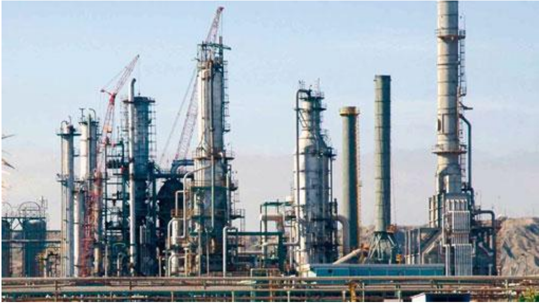
Fotografía 1: Vista de planta refinera Petroperu Talara.
