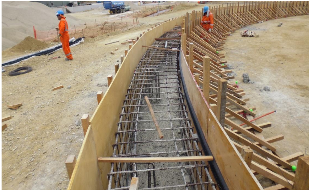
Fotografía 10: Vista del encofrado y habilitación de acero para anillo de cimentación.
