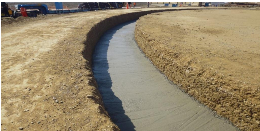
Fotografía 9: Vista del concreto ciclópeo para anillo de cimentación.
