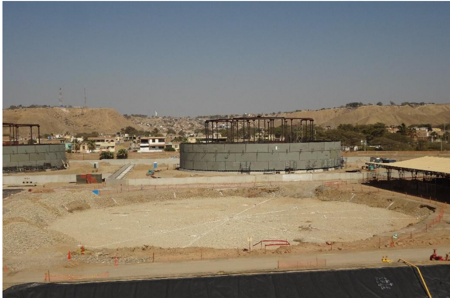
Fotografía 7: Trazo ubicación del Tanque.
