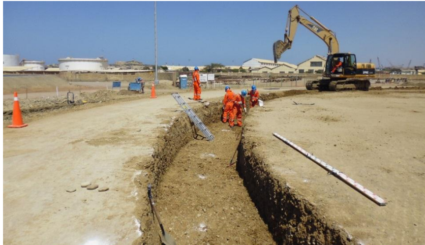
Fotografía 8: Trabajos de excavación de zanjas para cimentaciones.
