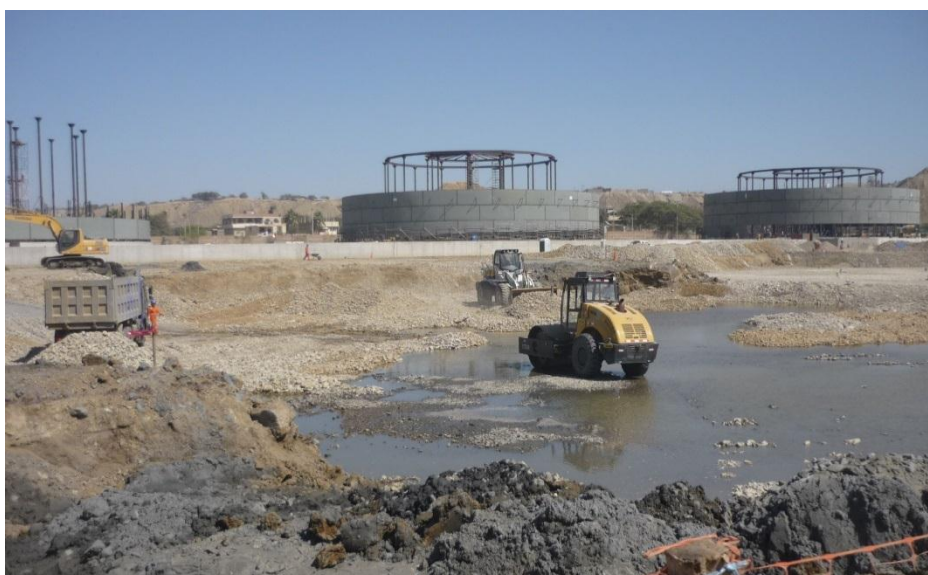
Fotografía 6: Trabajos de compactación.
