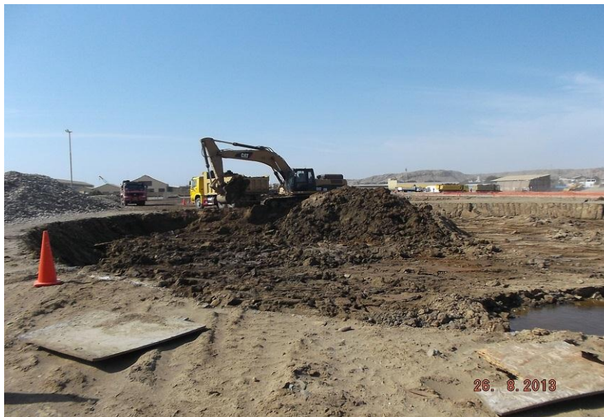
Fotografía 3: Trabajos de excavación con maquinaria pesada.
