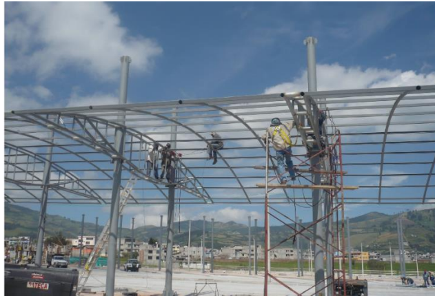
Figura 109. Sistema estructural, en construcción – Terminal Terrestre Quitumbe
