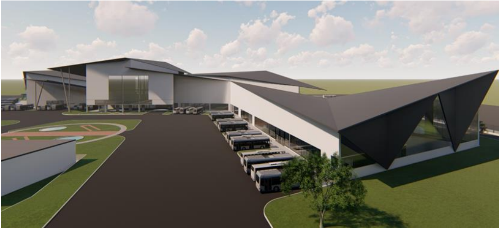
Figura 60. Vista posterior del proyecto – patio de embarque
