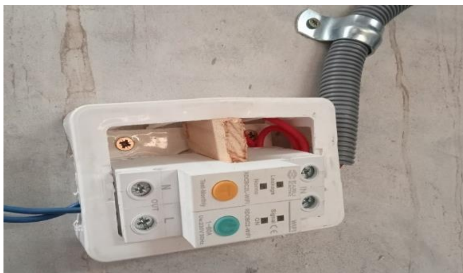
Figura 6. Funcionamiento de cuchilla inteligente para medir el consumo de energía eléctrica.
