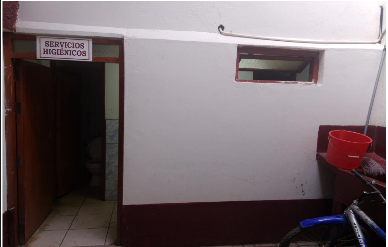
FOTO 3: Fachada de Baños
