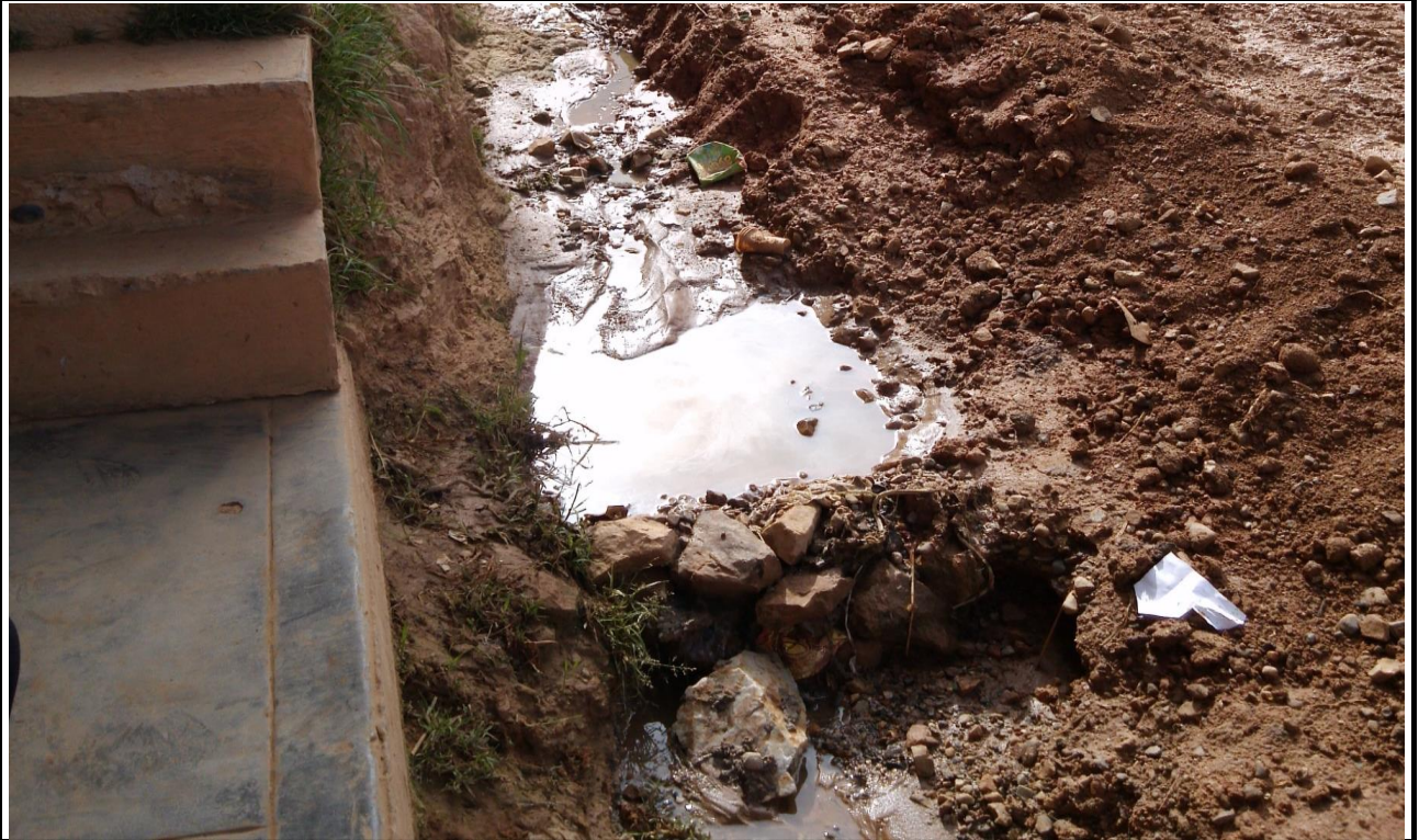
FOTO 2: AV. DEL EJERCITO CUADRA N° 4 (Se observa el pesimo estado de la calle a causa de las constantes lluvias, ocasionando lodo y haciendo casi imposible el transito vehicular y peatonal)
