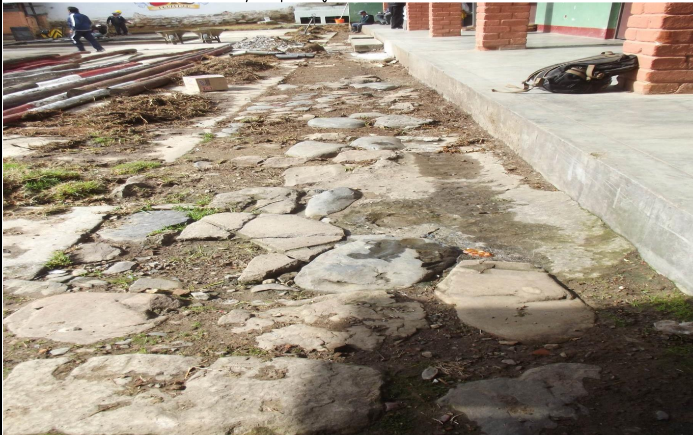
FOTO 1: Acondicionamiento de Vereda y Rampas a Ejecutarse
