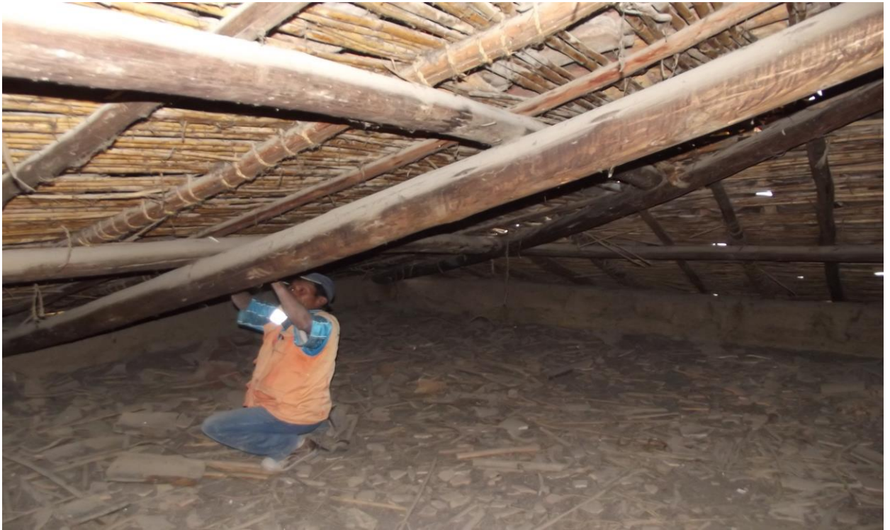
FOTO 5: Inspeccion de la Estructura Vigas y Mandayones
