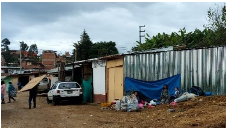
Imagen 5. Estado actual, precariedad y puestos improvisados del mercado en estudio.
