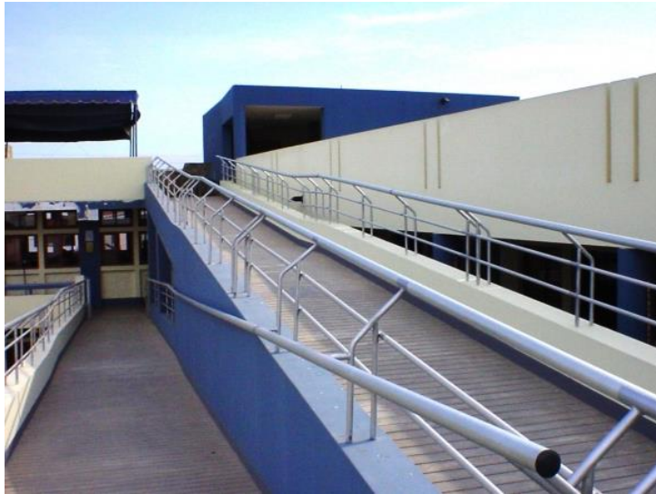
Figura 26 Rampa de acceso para el nivel superior del Centro Ann Sullivan del Perú – CASP.
