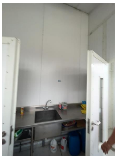
Figura 56 Registro fotográfico zona de servicios generales del EBE PRITE – EE.
