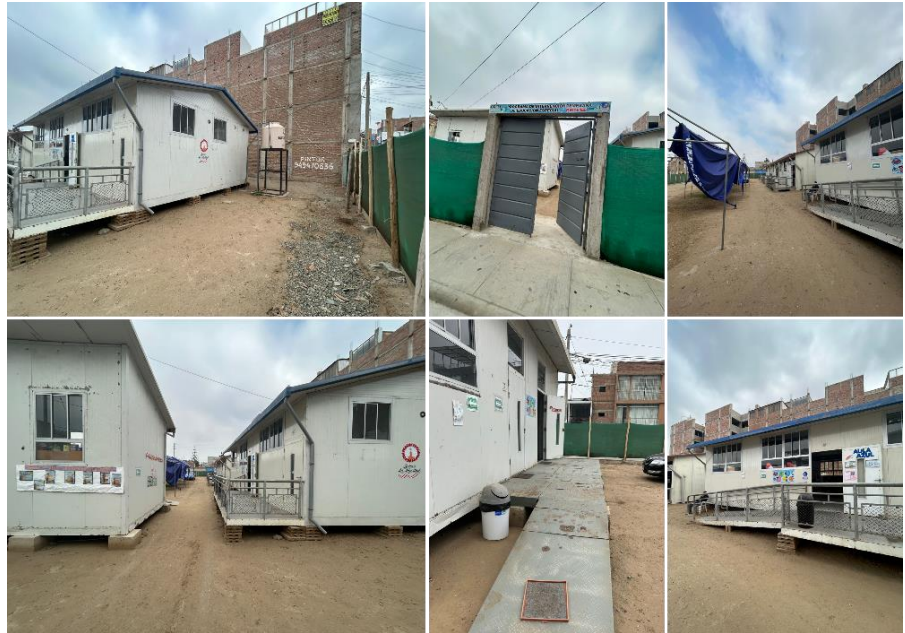
Figura 54 Registro fotográfico del ingreso e infraestructura del EBE PRITE – EE.
