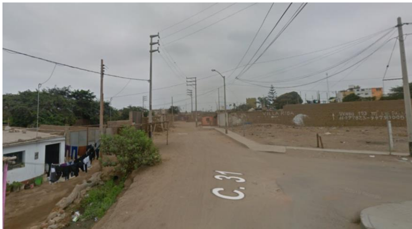
Figura 97 Vista este del predio – intersección de calle 31 y calle 36.
