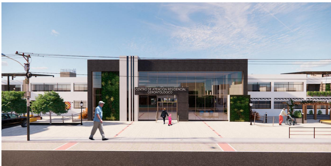
Figura N° 61: Vista de ingreso al Centro de Atención Residencial Gerontológico
