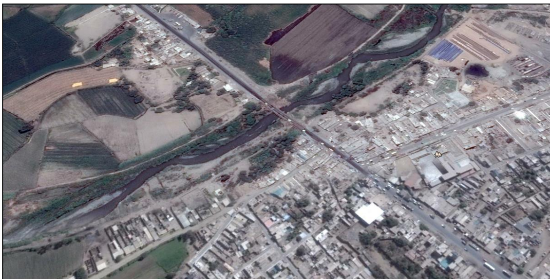
IMAGEN 10: ÁREAS URBANAS EN ZONA DE RIESGO POR INUNDACIÓN - VIRÚ PUEBLO
