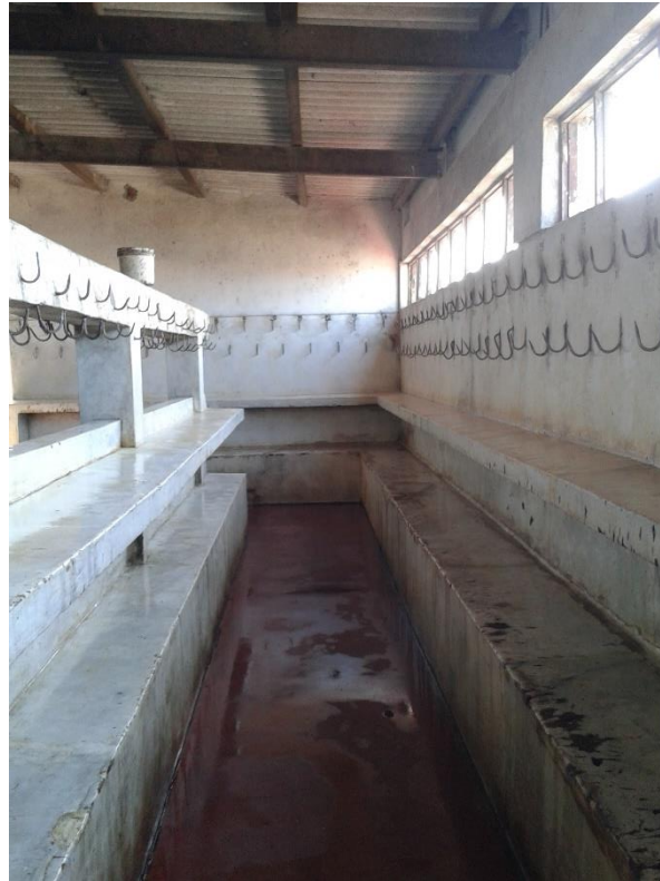
Sala de Inspección sanitaria
