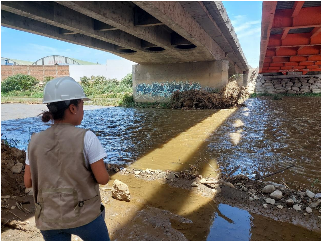
ANEXO 5.4: Fotografía tomada en el puente - Rio Moche
