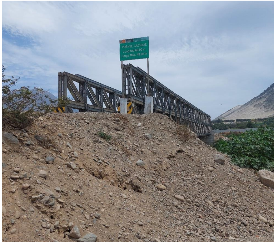
ANEXO 5.13: Fotografía tomada en el puente - Rio Cacique
