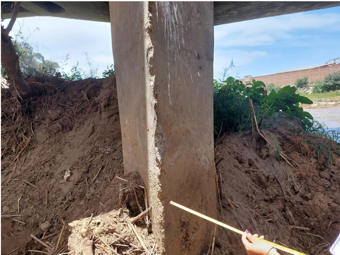
ANEXO 5.6: Fotografía tomada en el puente - Rio Moche
