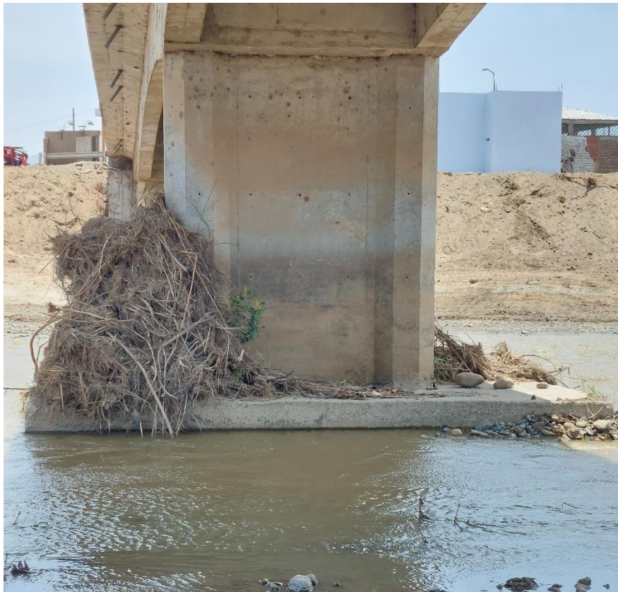
ANEXO 5.10: Fotografía tomada en el puente - Rio Santa Rosa
