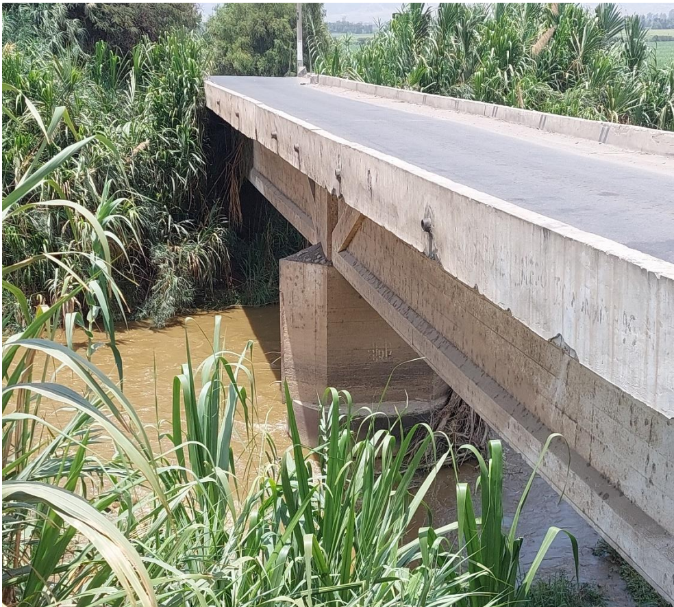
ANEXO 5.20: Fotografía tomada en el puente - Rio Conache
