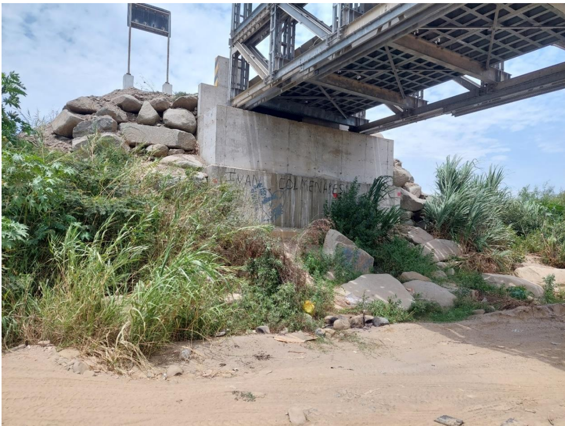
ANEXO 5.16: Fotografía tomada en el puente - Rio Cacique
