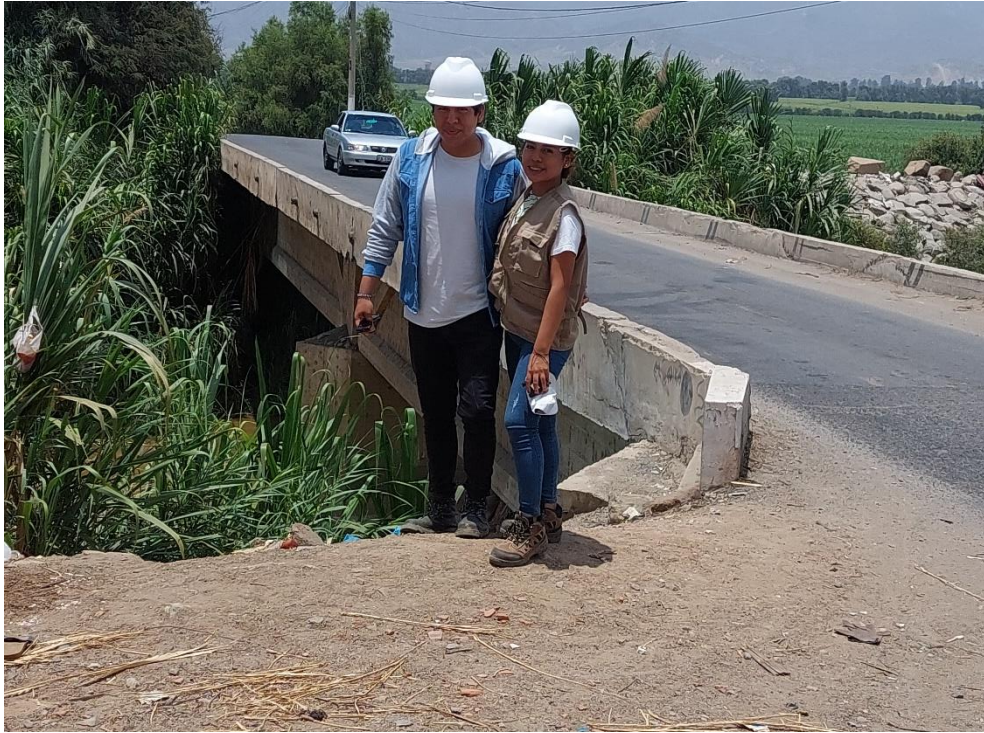
ANEXO 5.19: Fotografía tomada en el puente - Rio Conache
