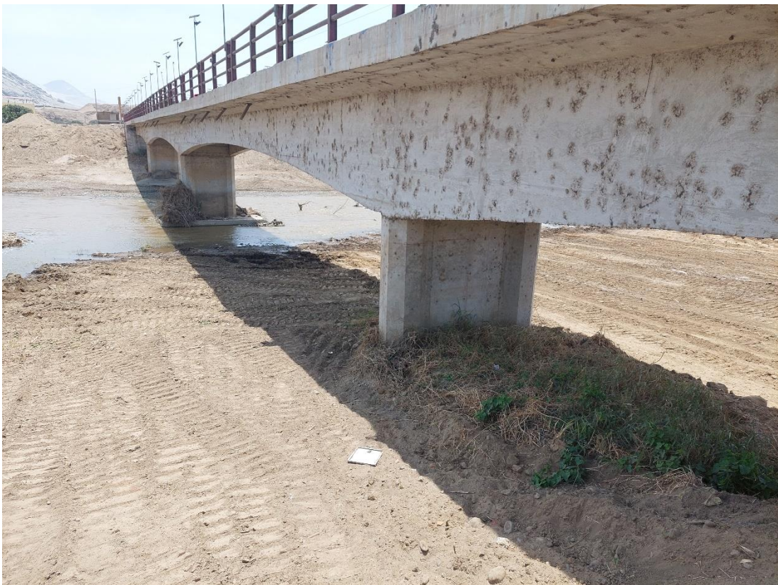
ANEXO 5.8: Fotografía tomada en el puente - Rio Santa Rosa
