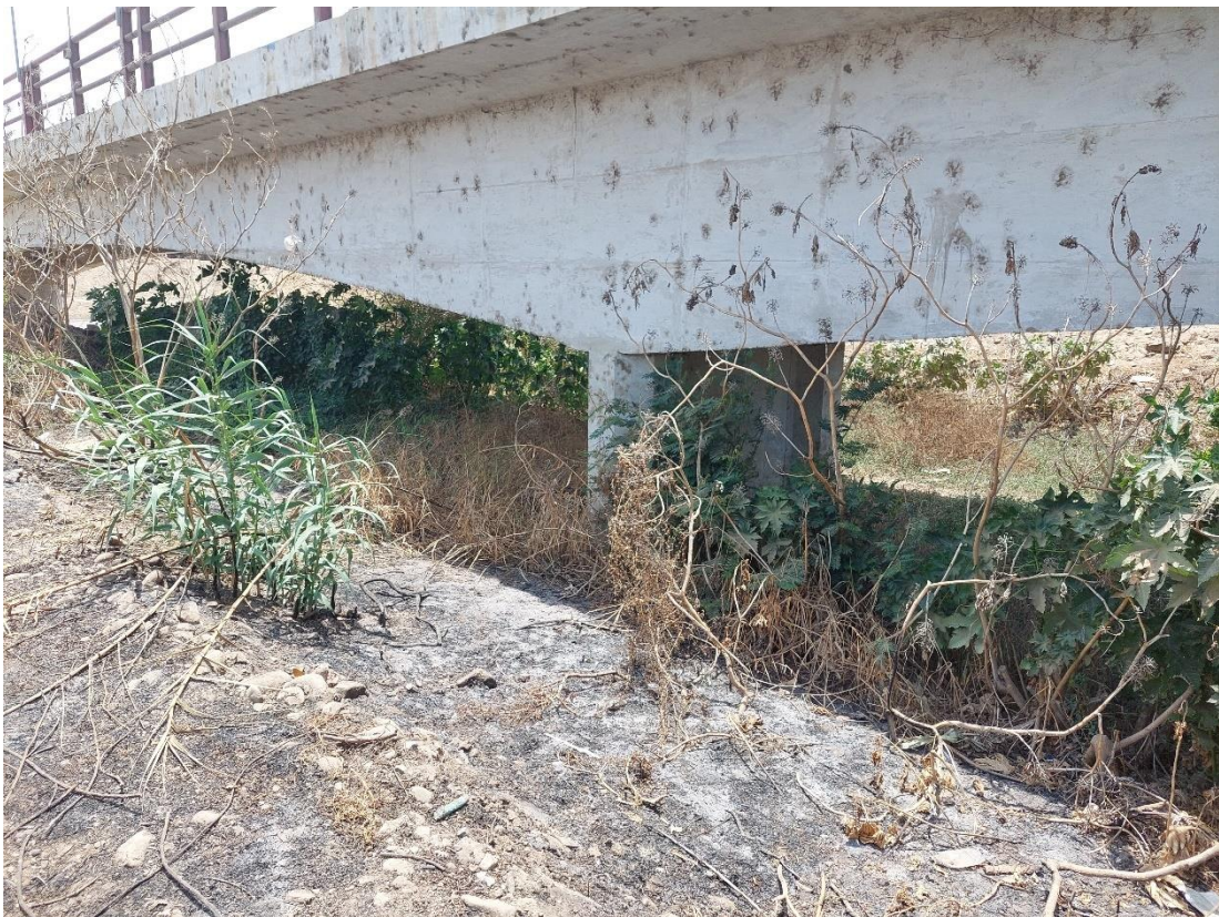
ANEXO 5.12: Fotografía tomada en el puente - Rio Santa Rosa
