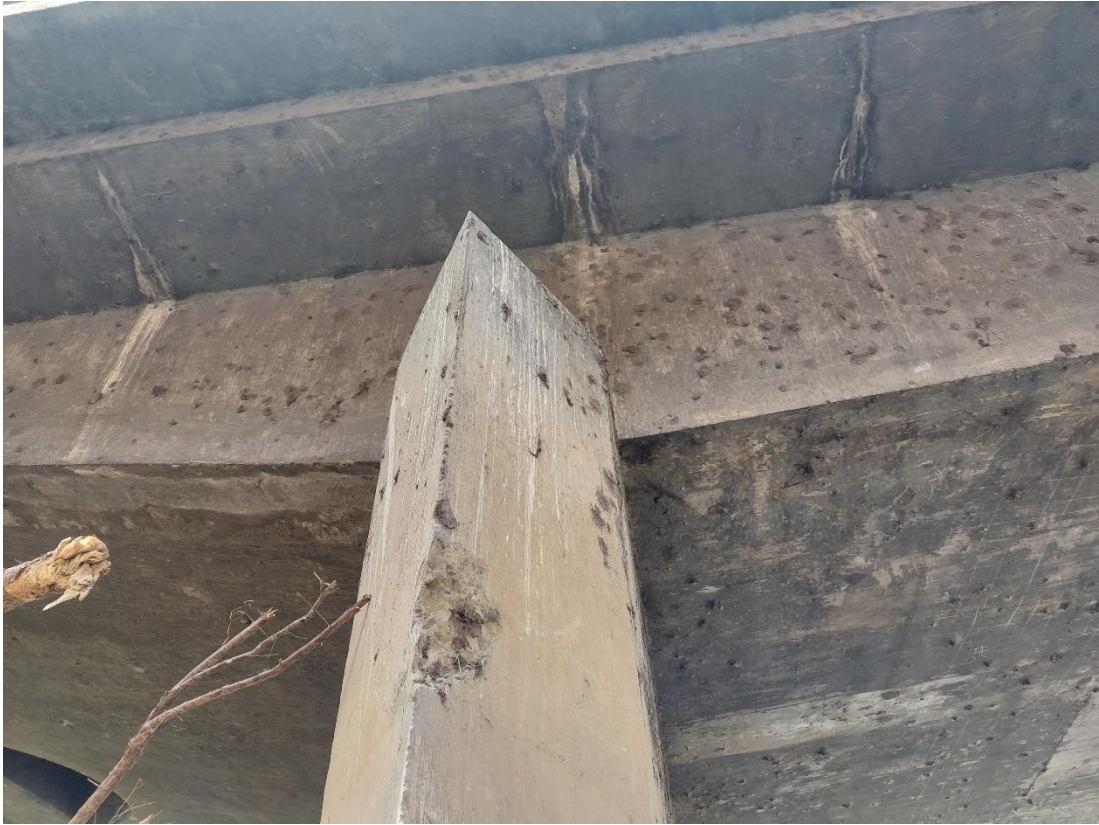
ANEXO 5.5: Fotografía tomada en el puente - Rio Moche
