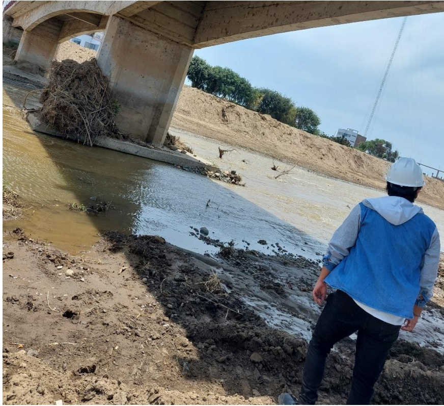
ANEXO 5.9: Fotografía tomada en el puente - Rio Santa Rosa
