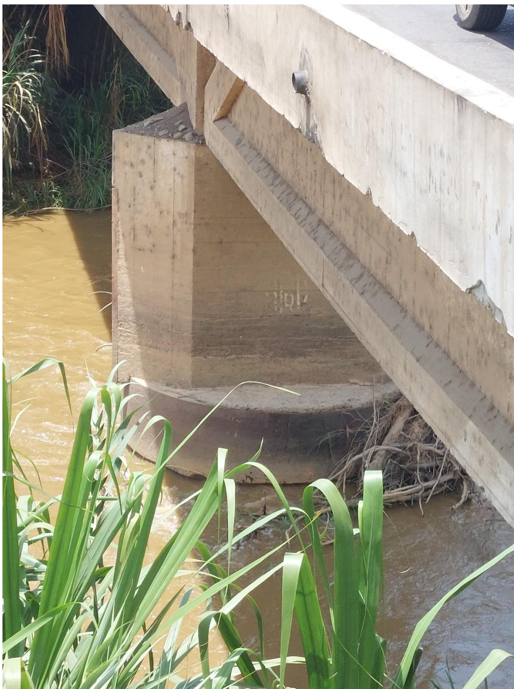
ANEXO 5.21: Fotografía tomada en el puente - Rio Conache
