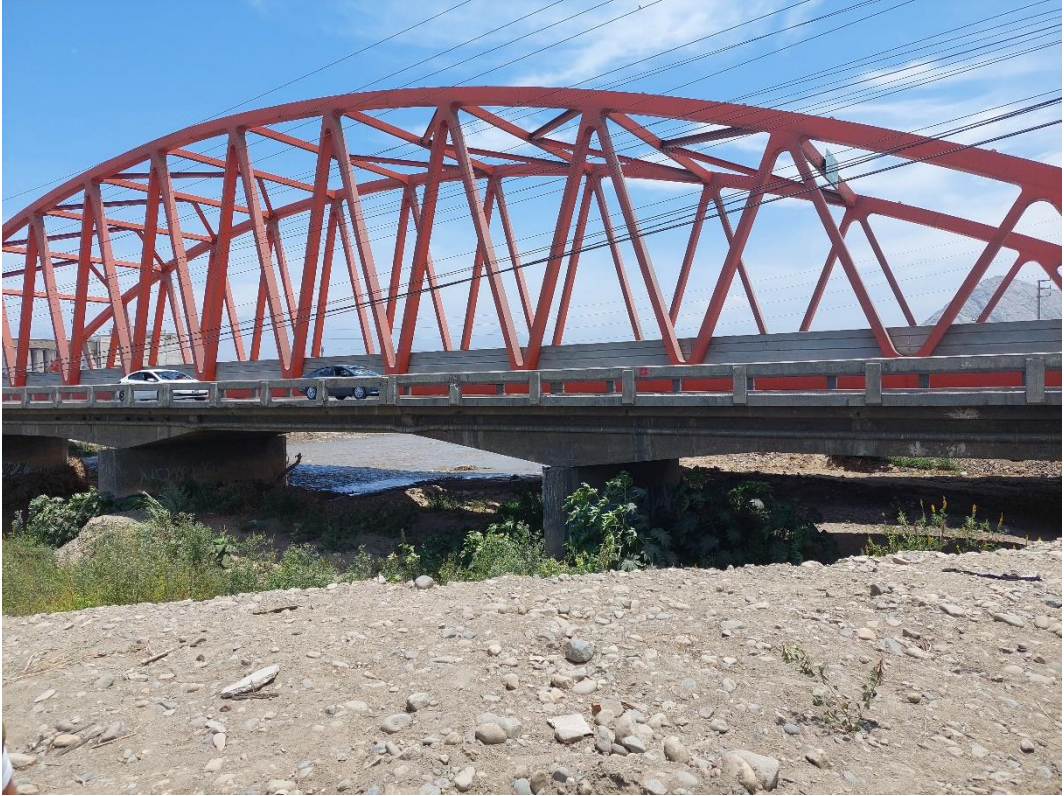
ANEXO 5.1: Fotografía tomada en el puente - Rio Moche
