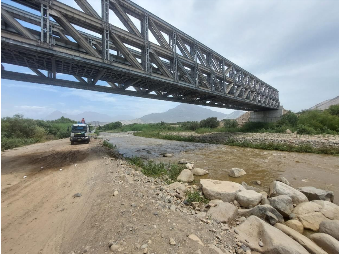
ANEXO 5.15: Fotografía tomada en el puente - Rio Cacique
