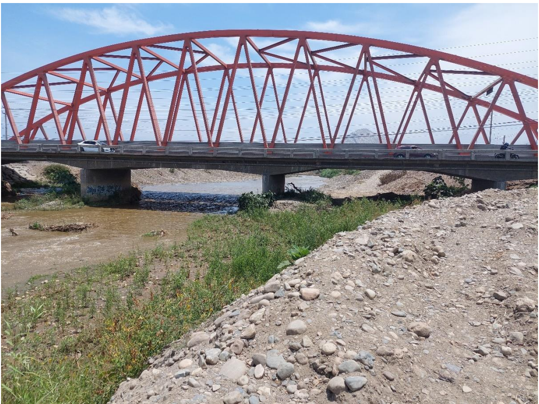
ANEXO 5.2: Fotografía tomada en el puente - Rio Moche
