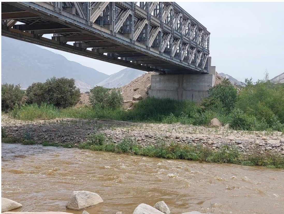
ANEXO 5.14: Fotografía tomada en el puente - Rio Cacique
