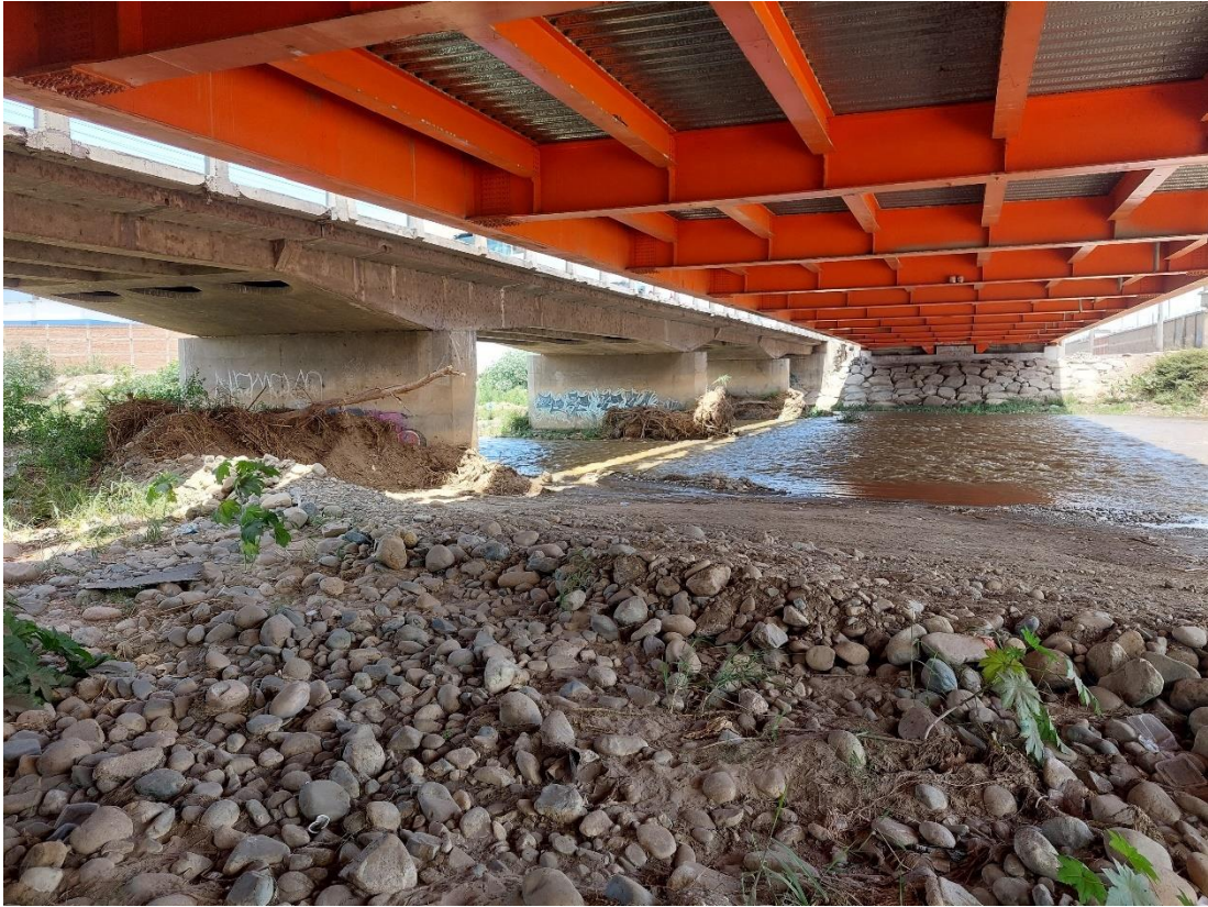
ANEXO 5.3: Fotografía tomada en el puente - Rio Moche
