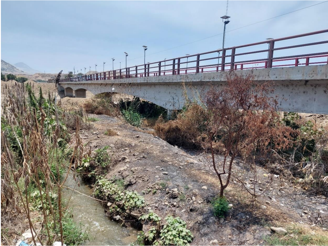
ANEXO 5.7: Fotografía tomada en el puente - Rio Santa Rosa
