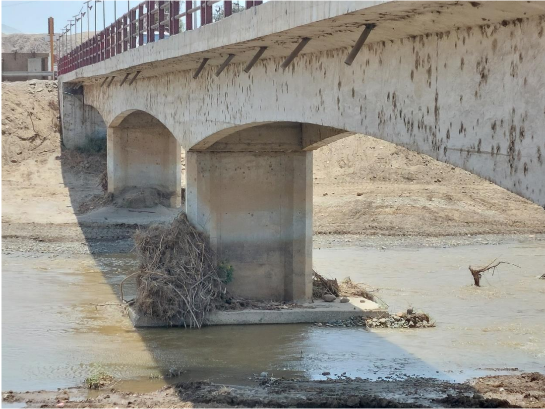
ANEXO 5.11: Fotografía tomada en el puente - Rio Santa Rosa
