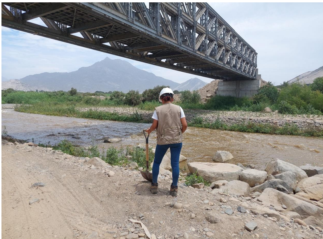
ANEXO 5.18: Fotografía tomada en el puente - Rio Cacique
