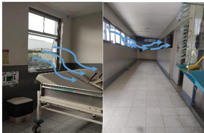
Imagen N° 13: Habitación y pasillos de la unidad de hospitalización
