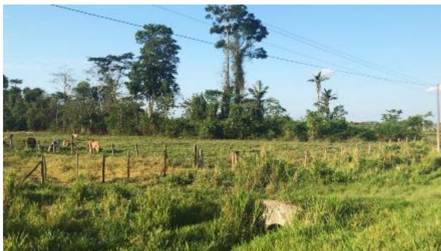
FIGURA 43. Conducto de desagüe en el sector El Castañal – Fuente: Propia.
