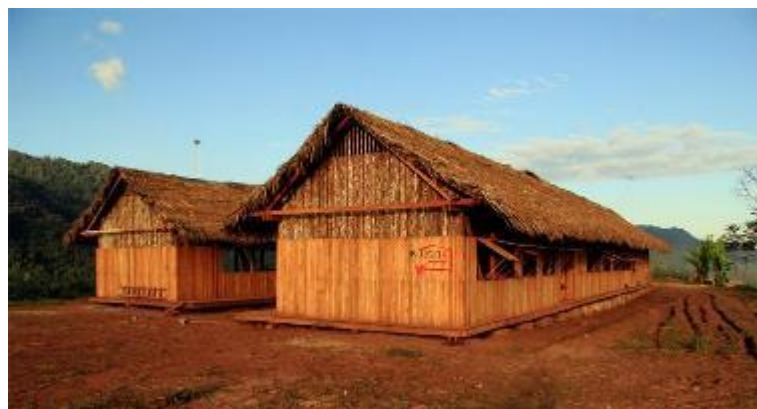
FIGURA 13. Módulos de educación secundaria terminados. Fuente: Archivo Construye Identidad.
