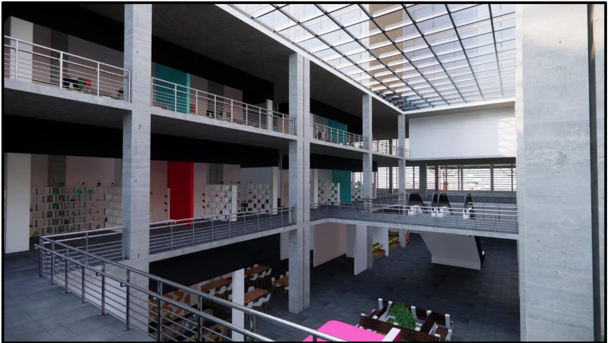
FIGURA N°32: Interior del Segundo Nivel del Mercado
