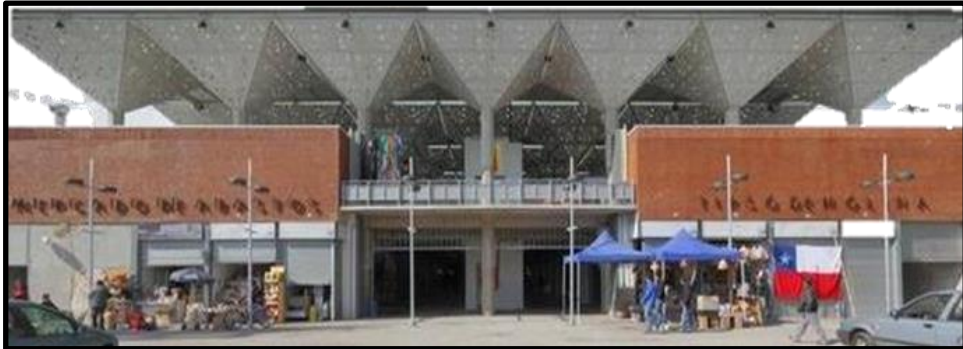
FIGURA N°16: Mercado San Tirso de Molina - Fachada
