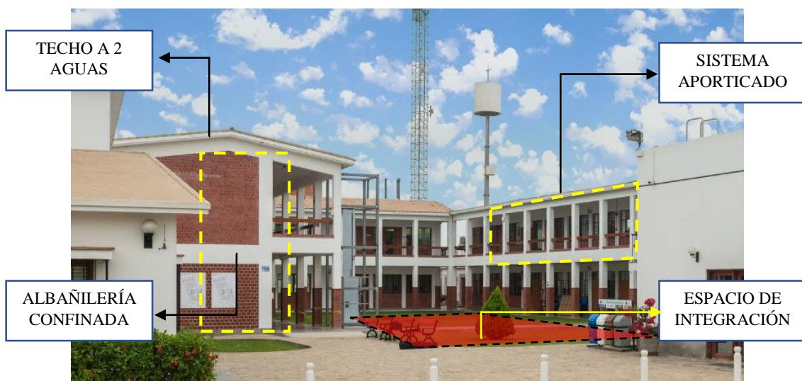
Figura 10. Plaza, sistema Aporticado y Techos a 2 aguas Valle Grande Fuente: Valle Grande, 2021
