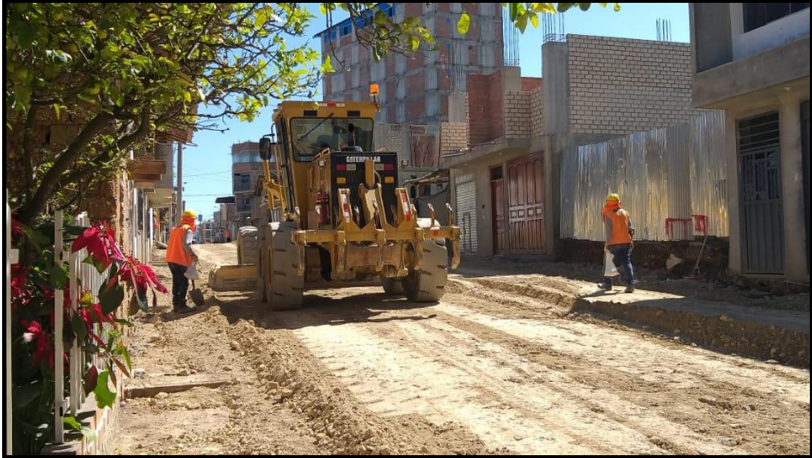
Conformación y compactación de la subrasante en el Jr. San Sebastián de la Cruz.
