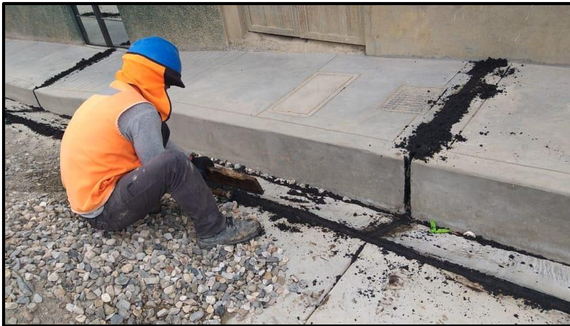
Sellado con asfalto en el borde de las cunetas del Jr. Nacarino.
