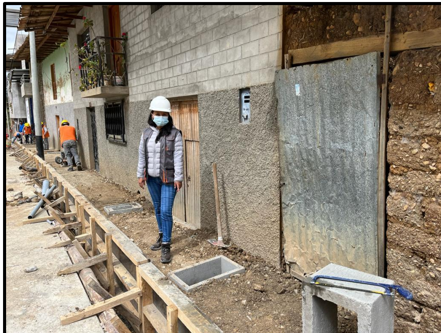
Reposición de conexiones domiciliarias de agua y desagüe en el Jr. San Sebastián.
