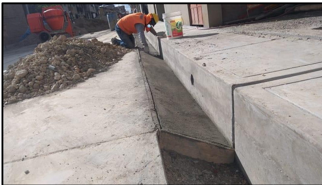
Acabado de cunetas en el Jr. San Sebastián.
