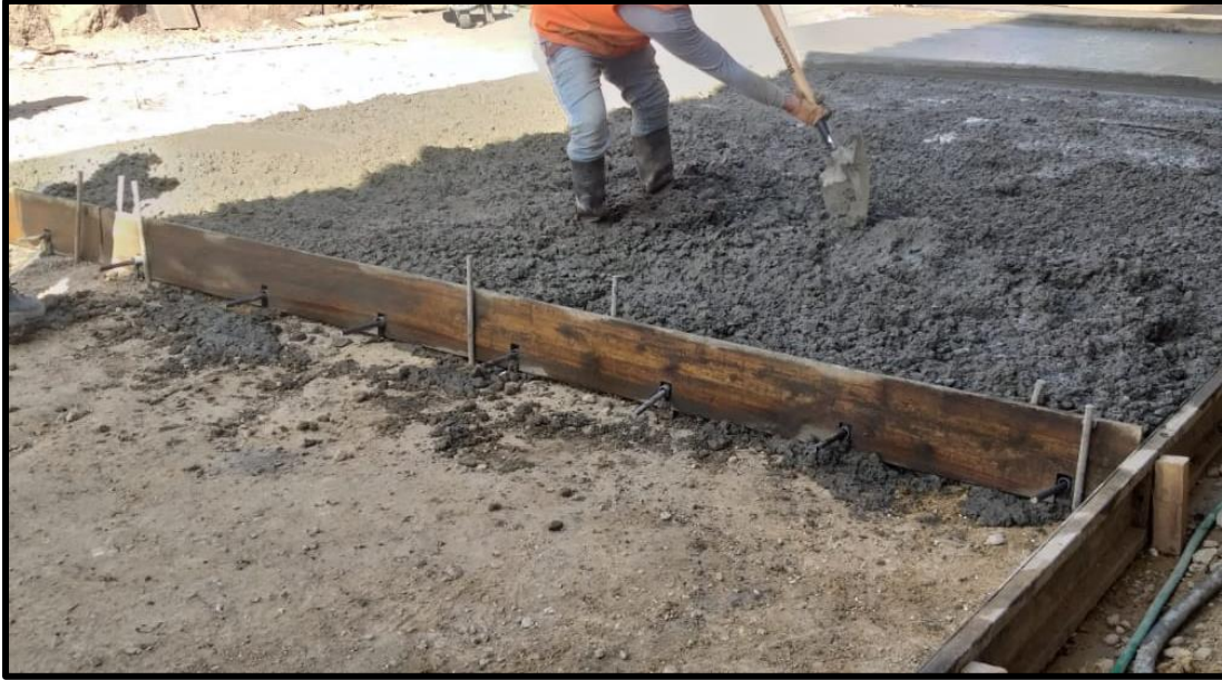
Junta asfáltica de dilatación y aislación E=1" en Jr. Nacarino.
