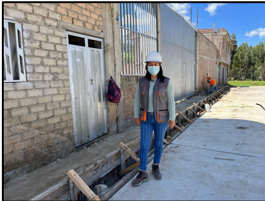
Encofrado y desencofrado de veredas en el Jr. San Sebastián.
