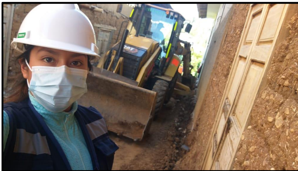
Corte de material excedente en el pasaje 02.
