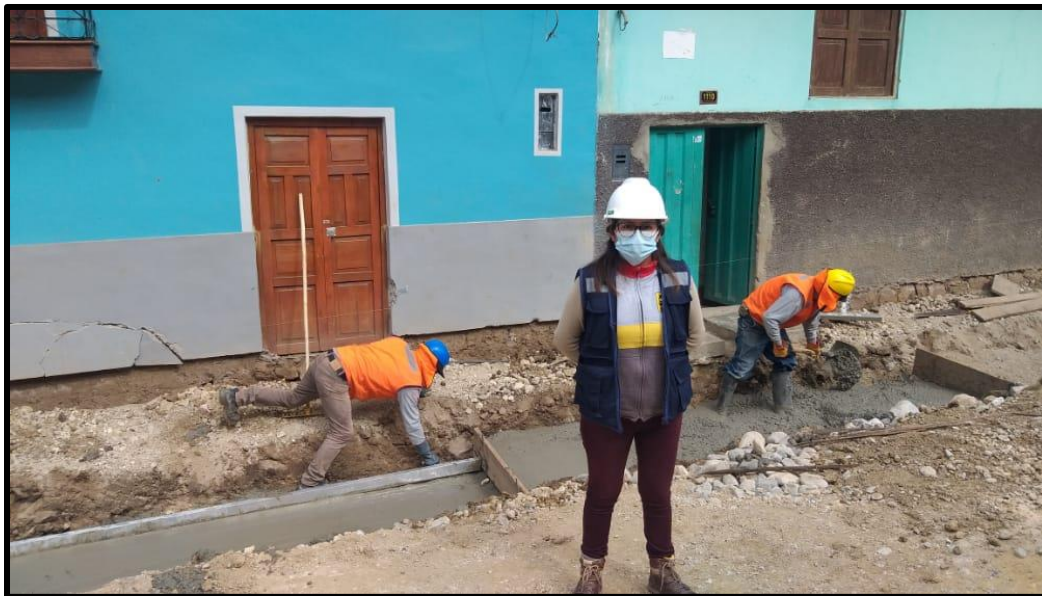
Solado de E=4" para el muro de contención de concreto armado en Jr. Nacarino.
