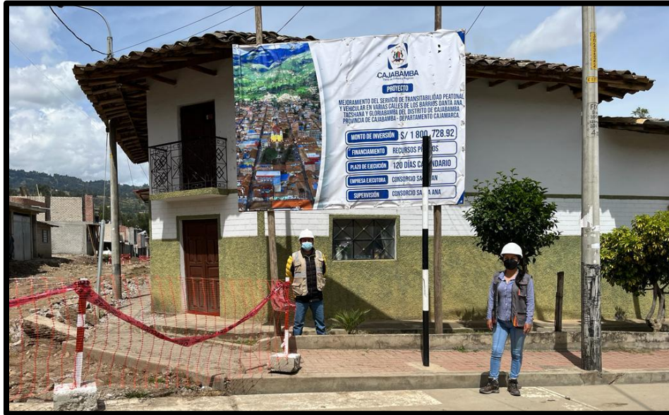
Colocación del cartel de obra en el Jr. San Sebastián de la Cruz.
