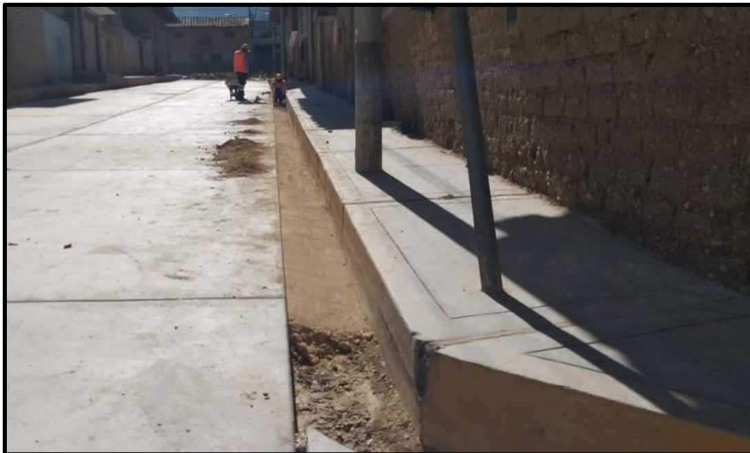
Conformación de relleno compactado para cunetas en el Jr. José Gálvez.
