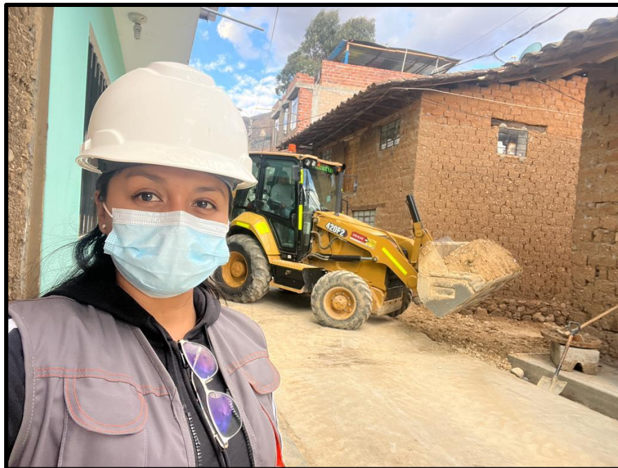
Colocación de afirmado en el pasaje 02.
