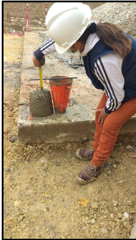
Slump óptimo de 3.5" en el primer tramo vaciado en el Jr. José Gálvez.
