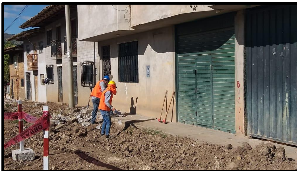
Demolición manual de veredas.
