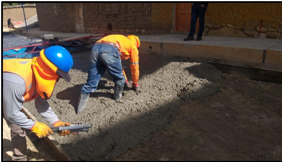
Colocación de dowel liso de \frac{3}{4} " grado 60 en juntas de contracción en el Jr. José Gálvez.
