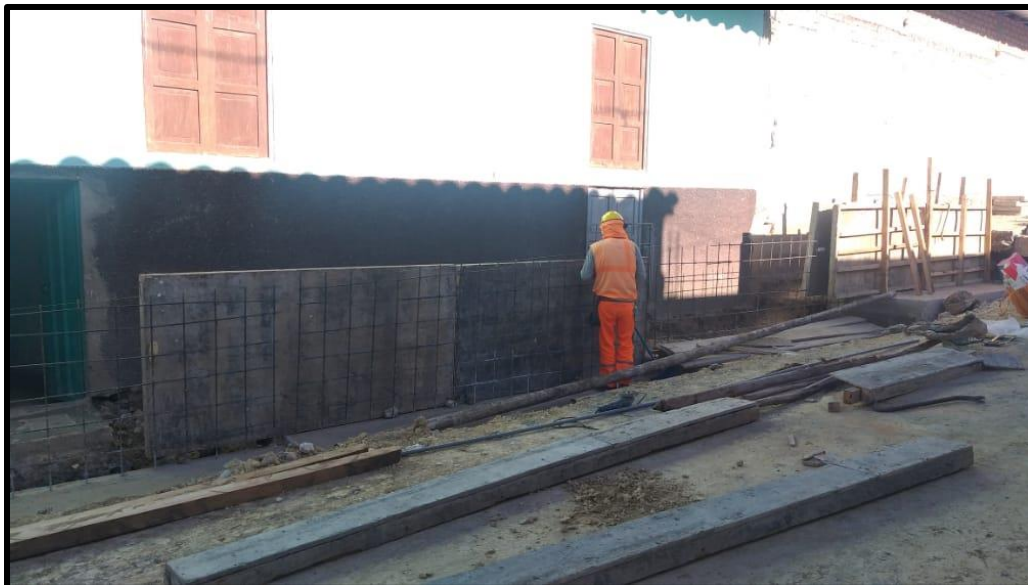
Encofrado y desencofrado para muros caravista del muro de contención de concreto armado en Jr. Nacarino.
