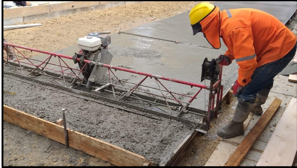
Vibrado de concreto en el en Jr. José Gálvez.
