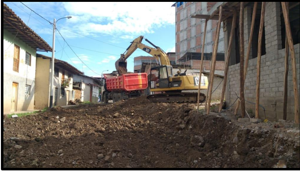
Eliminación de material excedente.
