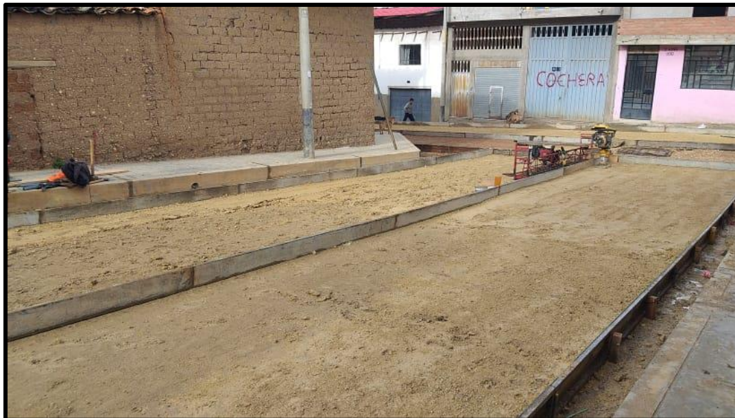
Encofrado y desencofrado de pavimento rígido en el Jr. José Gálvez.
