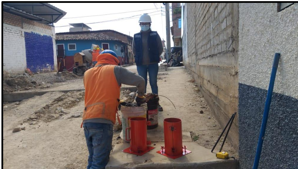
Realización de probetas del muro de contención de concreto armado en Jr. Nacarino.
