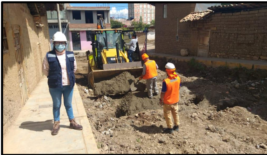
Cama de apoyo para las conexiones domiciliarias.
