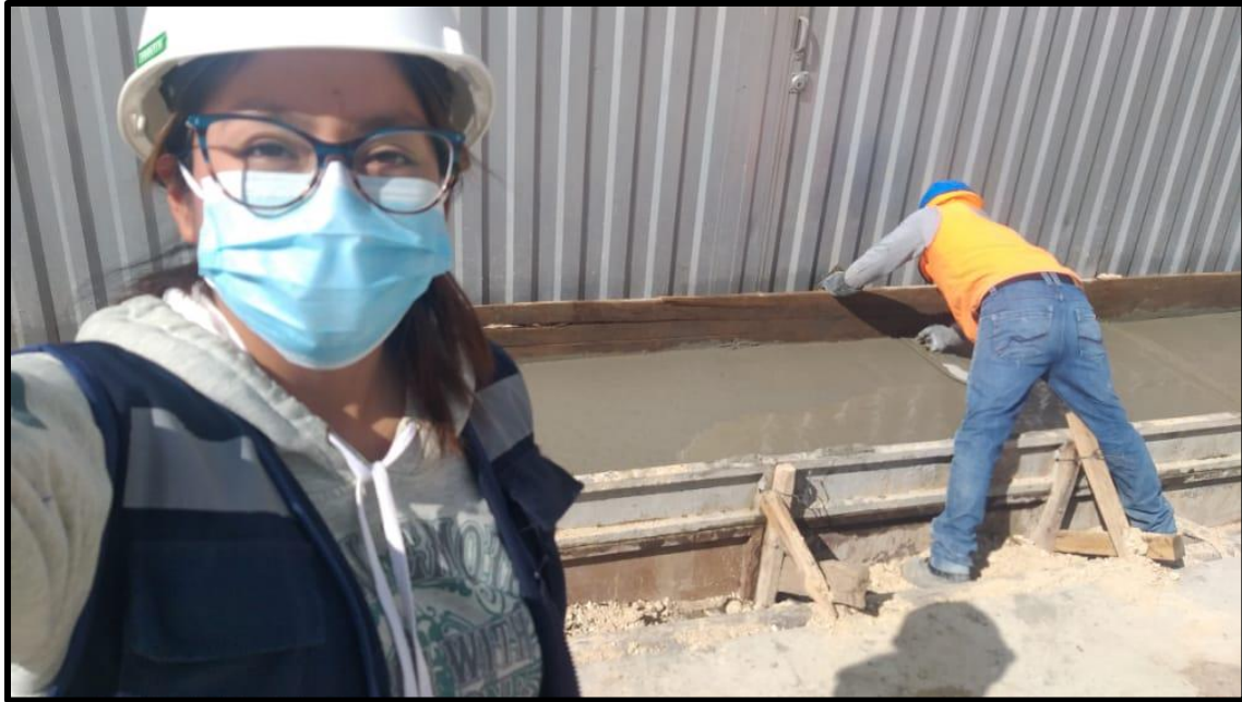
Acabado y bruñado de las veredas en el Jr. San Sebastián.
