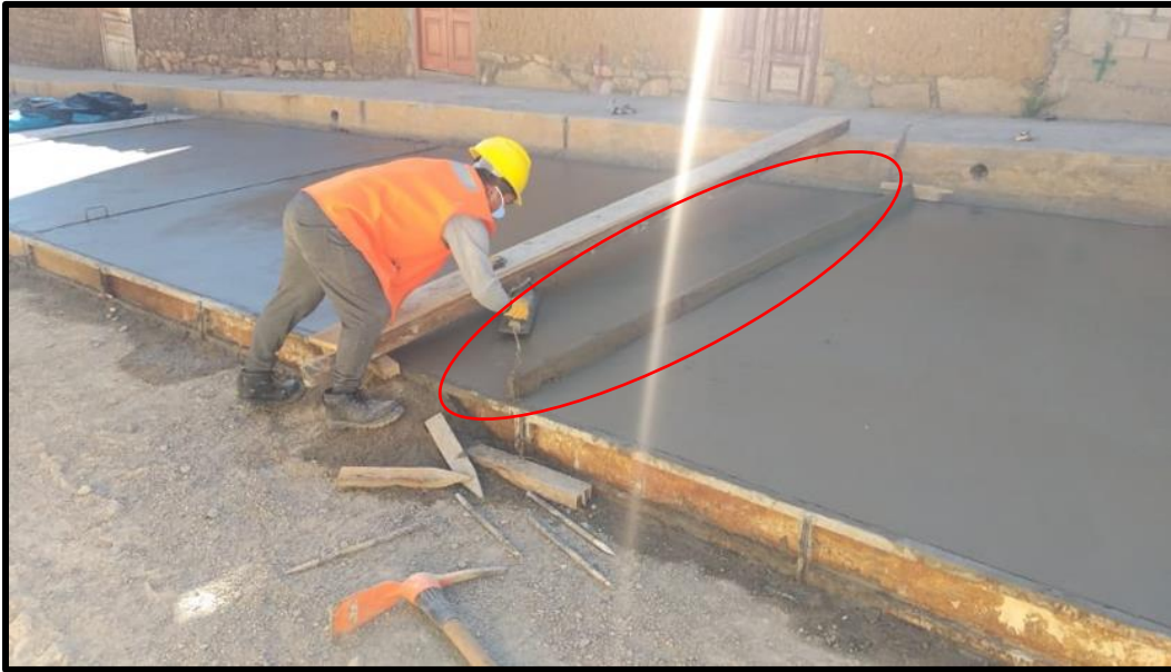
Junta asfáltica de dilatación y aislación E=1" en Jr. José Gálvez.
