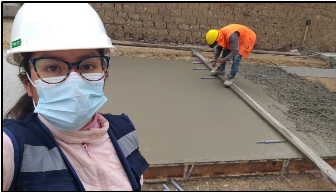
Colocación de dowel liso de \frac{3}{4} " grado 60 en juntas de dilatación y contracción en el Jr. San Sebastián.
