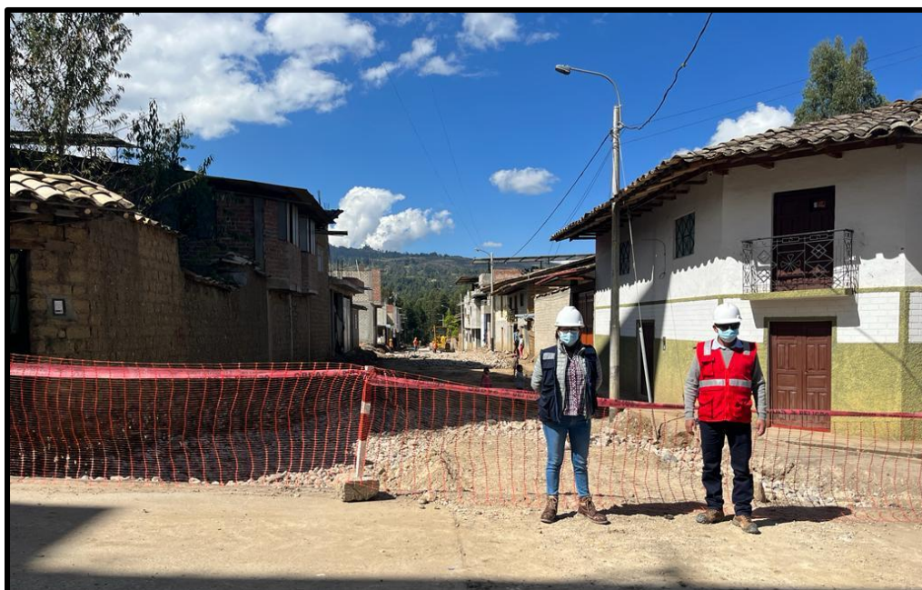
Señalización mediante cinta y malla durante la ejecución de obra.
