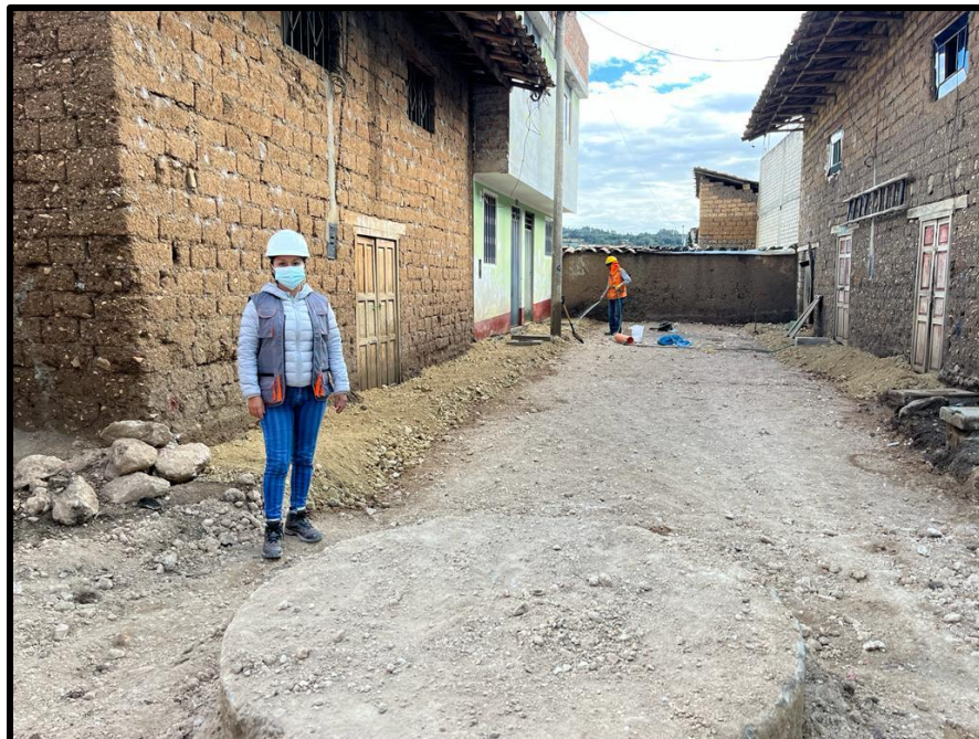
Colocación de relleno en vereda de la Prolongación San Martín.
