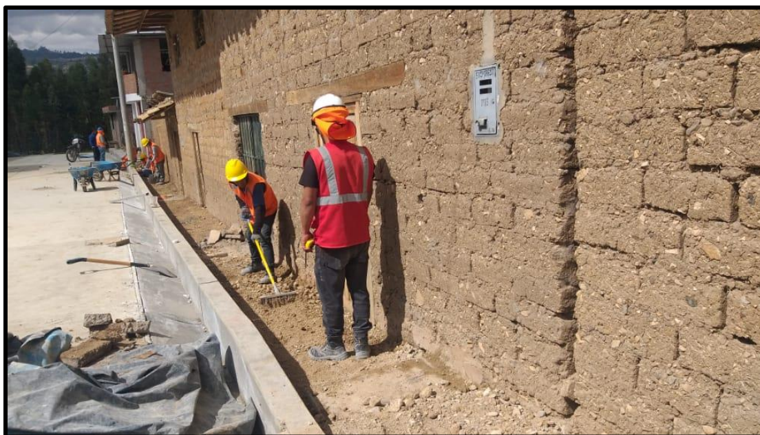
Conformación de relleno compactado para veredas y rampas en el Jr. San Sebastián.
