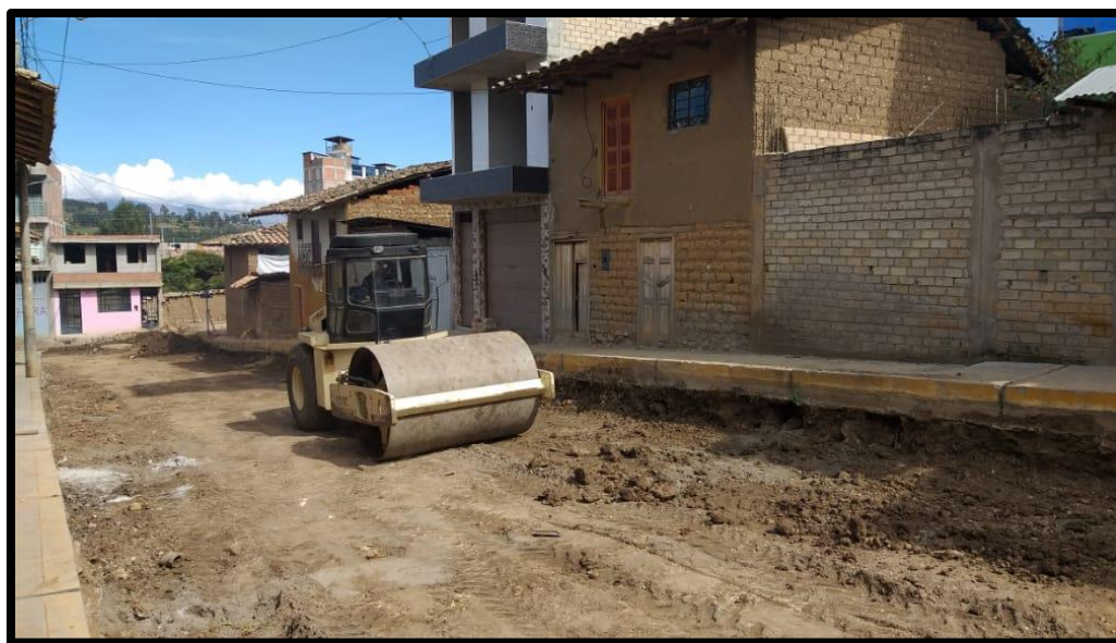
Conformación y compactación subrasante.
