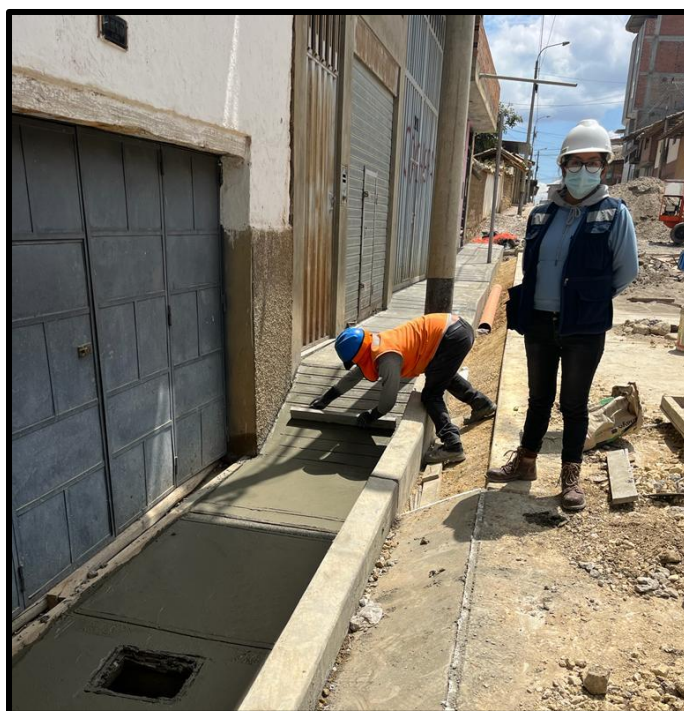
Bruñado de las rampas en el Jr. King.
