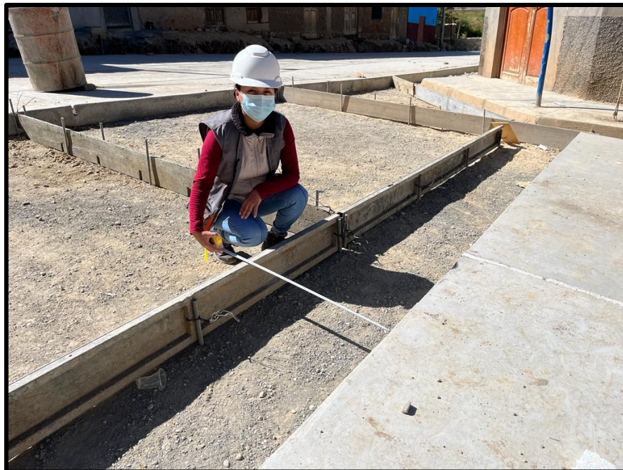
Medición del ancho para las cunetas rectangulares en el Jr. José Gálvez.
