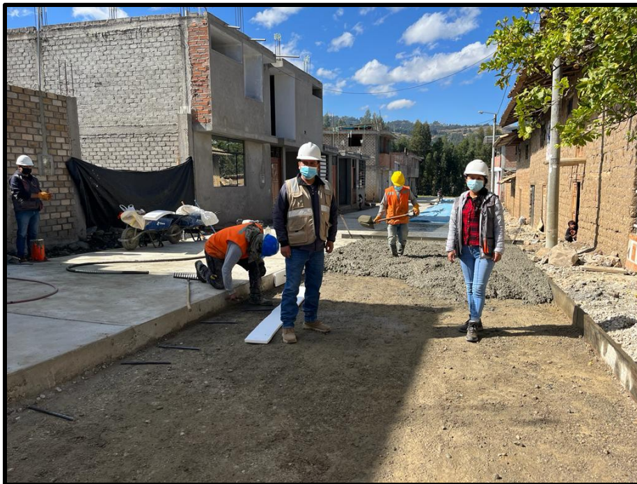
Vaciado de concreto F'c=210 \text{ Kg/cm}^2 de E=0.20\text{m} en Jr. San Sebastián, junto al residente de obra.
