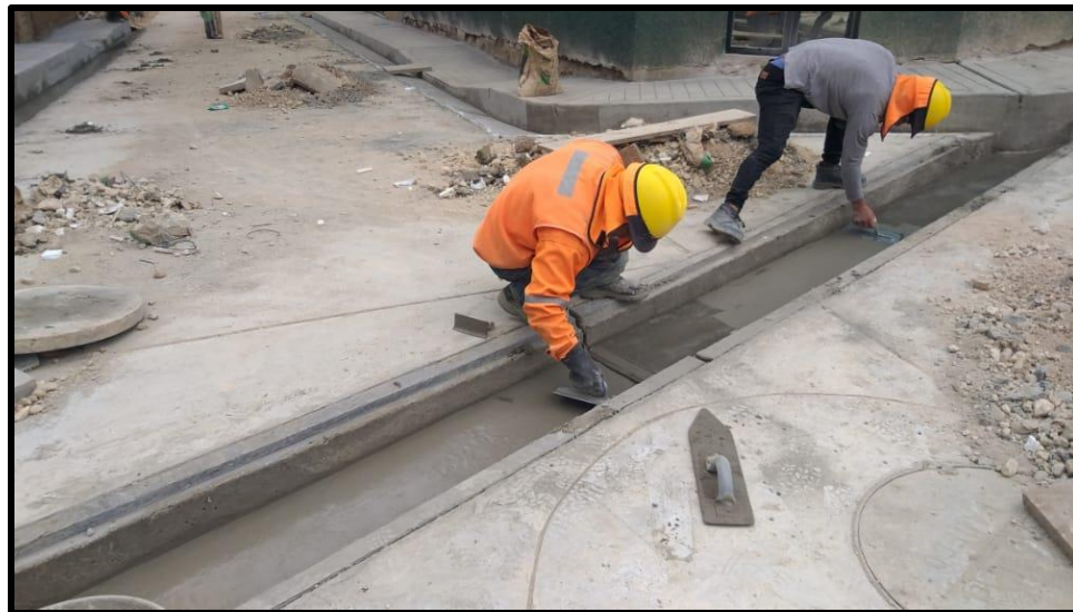
Acabado de las cunetas rectangulares en el Jr. Nacarino.
