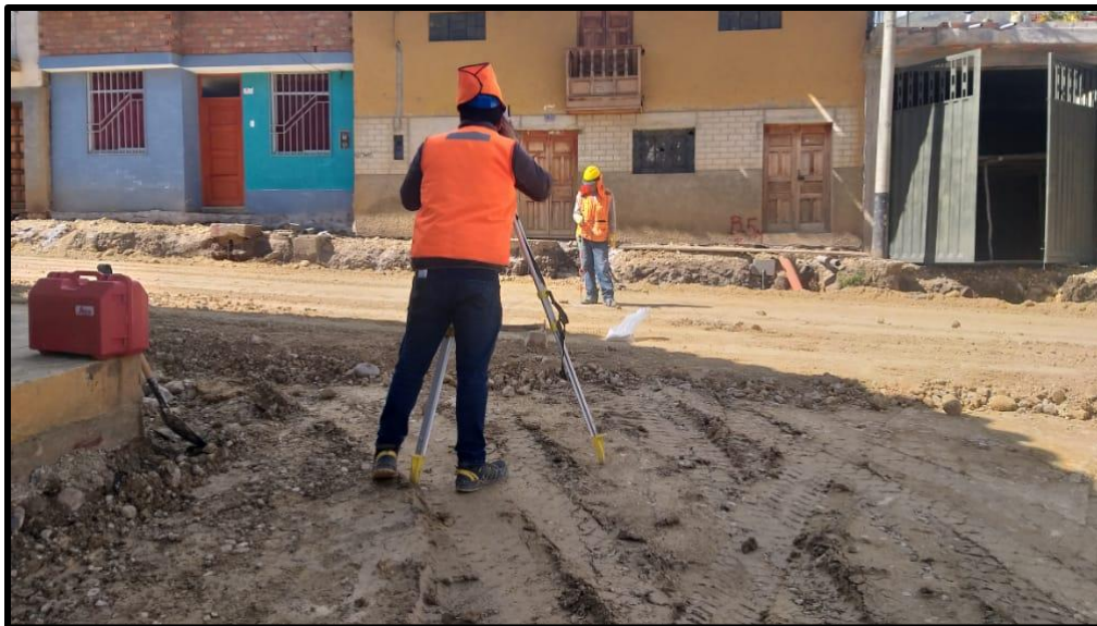
Trazo y replanteo con equipo.
