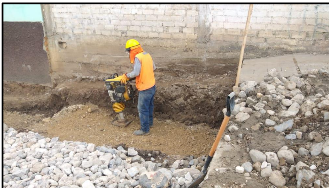
Nivelación y compactación del muro de contención de concreto armado en Jr. Nacarino.
