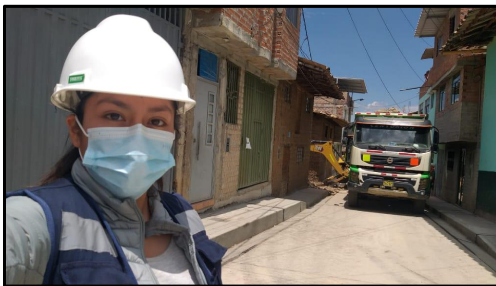
Eliminación de material excedente de corte en el pasaje 02.
