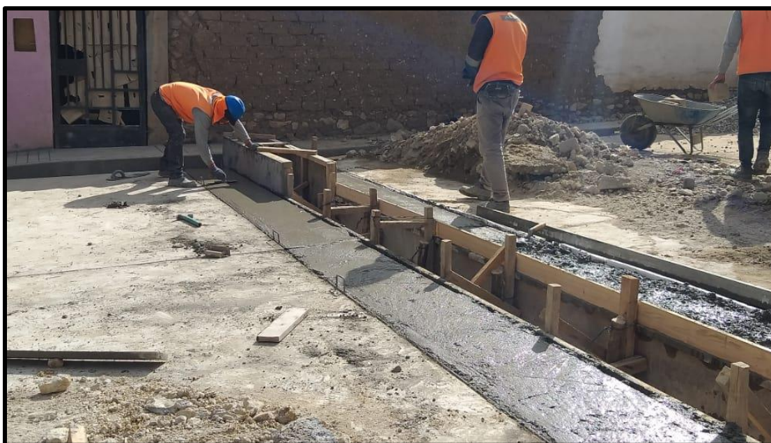
Vaciado de concreto F'c=175 Kg/cm 2 en cuneta rectangular del Jr. King.
