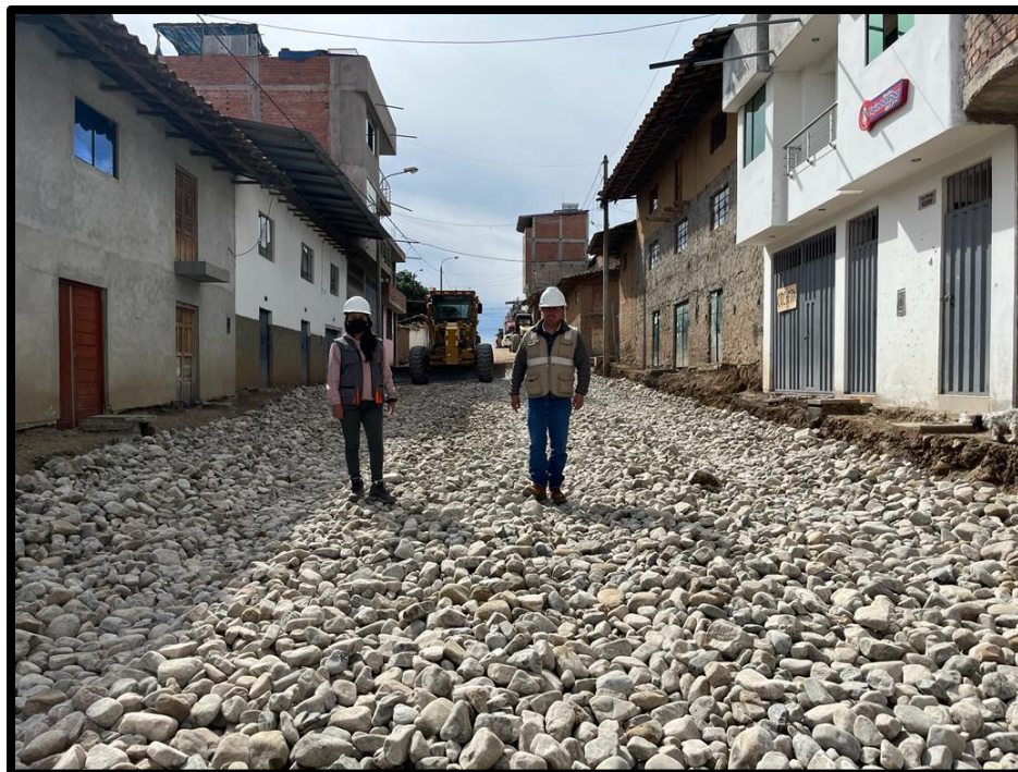
Extendido, riego y compactado del over en el Jr. King.
