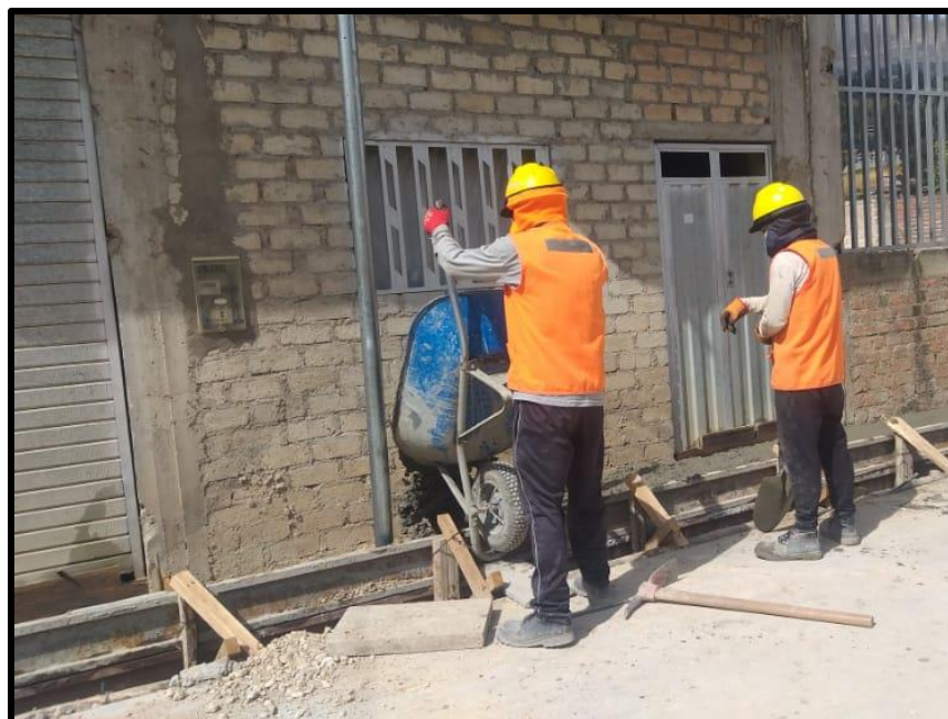
Vaciado de concreto F'c=175 \text{ Kg/cm}^2 de E=0.10\text{m} en veredas y rampas del Jr. San Sebastián.
