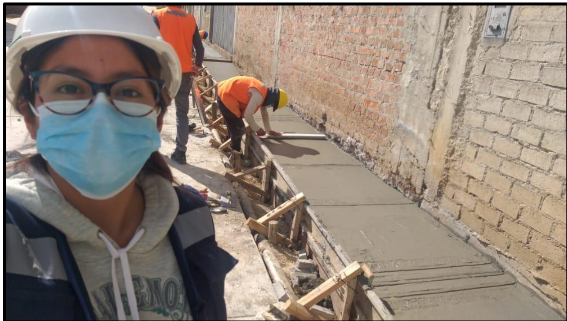
Acabado y bruñado de las rampas en el Jr. San Sebastián.
