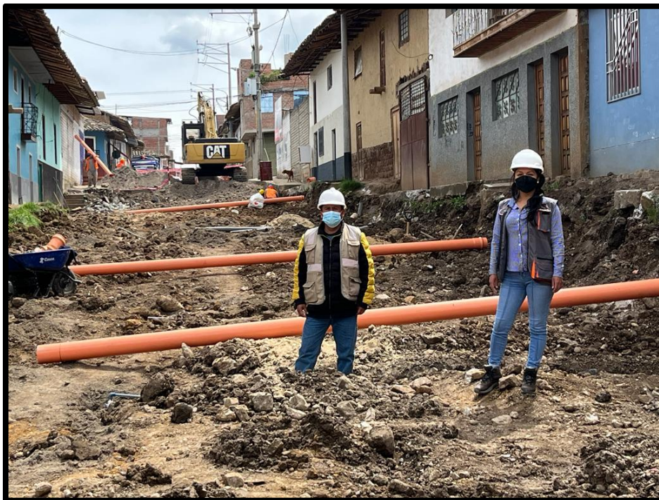
Reposición de conexiones domiciliarias de desagüe.
