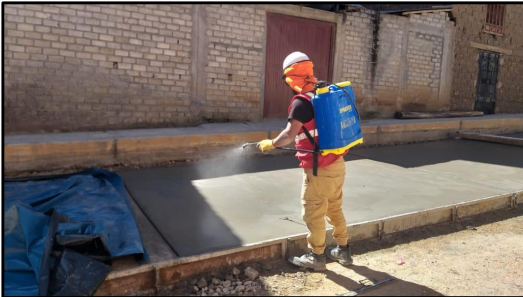
Curado de concreto con aditivo antisol en Jr. José Gálvez.
