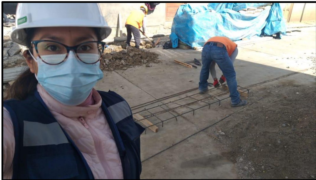
Armado de acero para sardineles en el Jr. San Sebastián.
