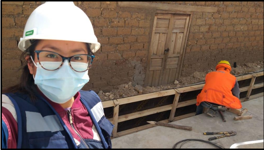
Encofrado y desencofrado de sardineles en el Jr. San Sebastián.
