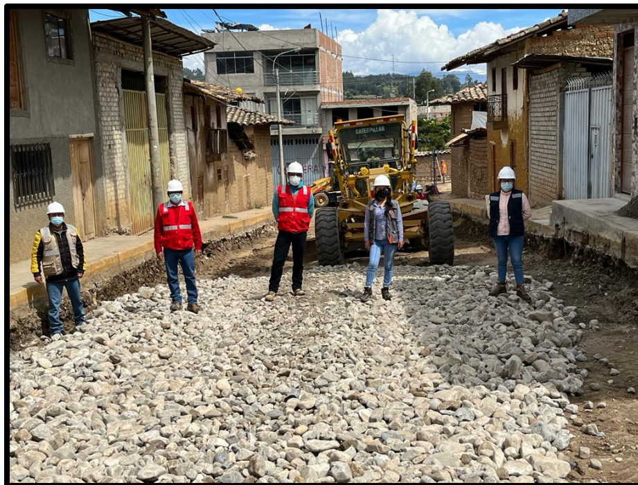
Mejoramiento con over en Jr. José Gálvez.
