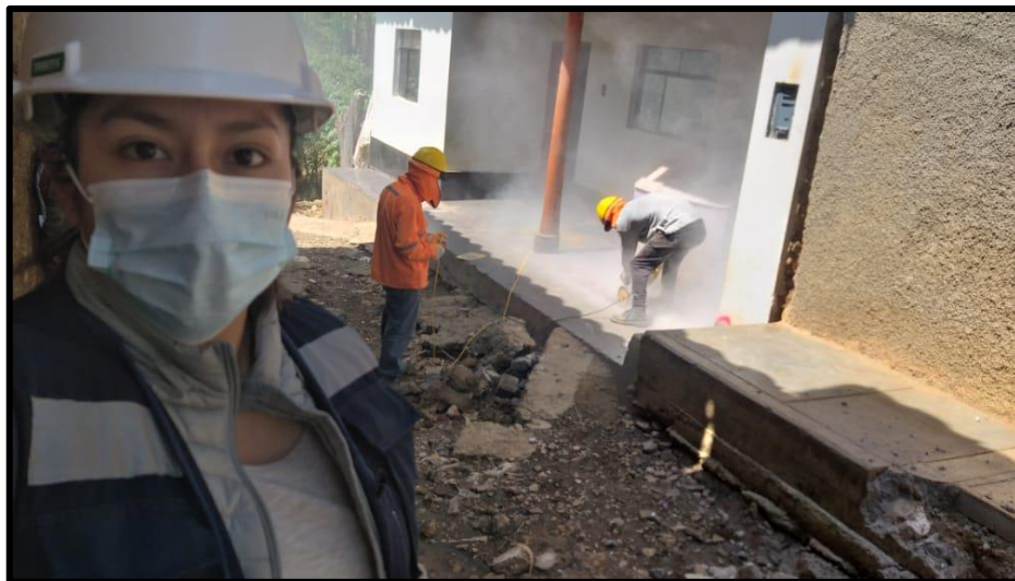
Corte y demolición de las veredas existentes en el pasaje 02.
