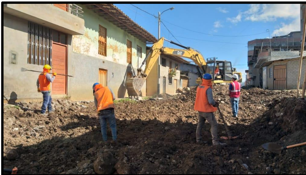
Demolición de veredas en el Jr. San Sebastián de la Cruz con el tractor de orugas.
