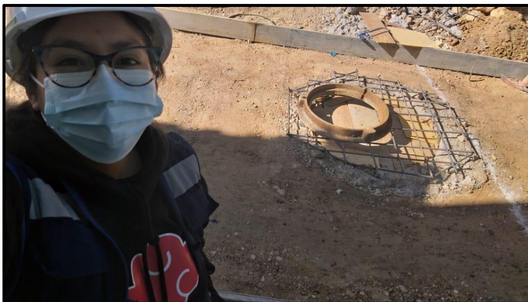
Armado de buzón en la Prolongación San Martín.
