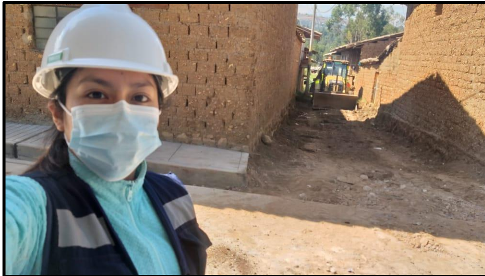
Trabajos de corte de sub rasante en el pasaje 02.
