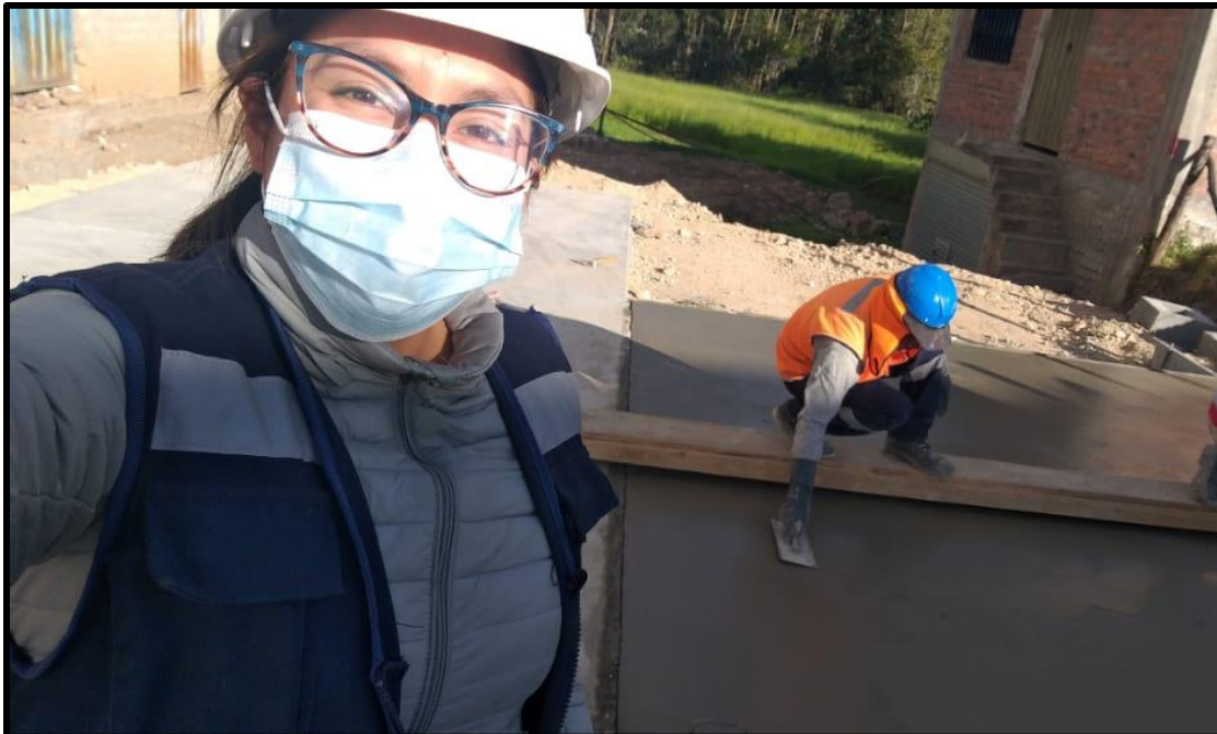
Acabado de los paños de concreto en el Jr. San Sebastián.
