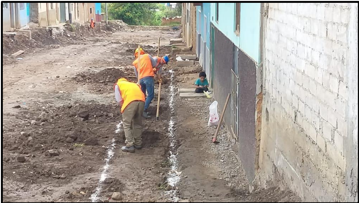
Trazo y replanteo para el muro de contención de concreto armado en Jr. Nacarino.
