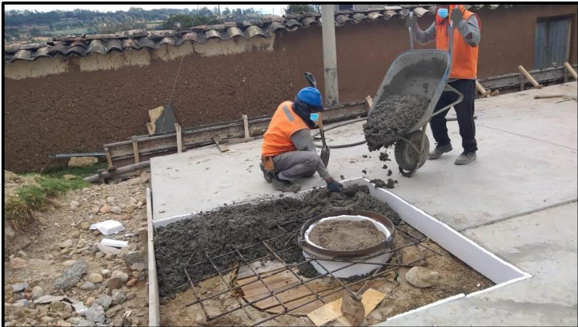
Vaciado de buzones en el Jr. King.
