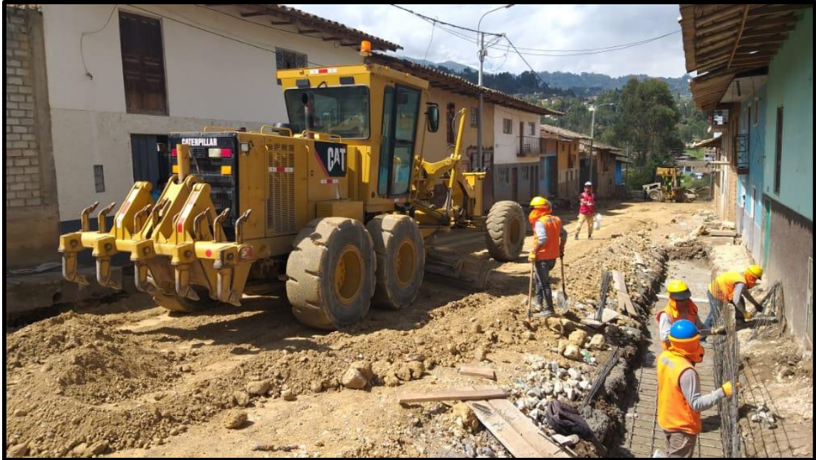
Conformación y Compactación del afirmado en Jr. Nacarino.
