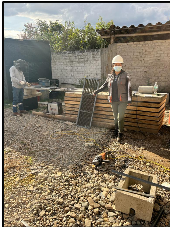
Trabajos de habilitación de estructura metálica en rejillas para discapacitados.
