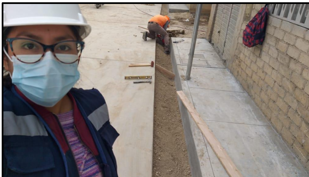
Encofrado y desencofrado de cunetas en el Jr. San Sebastián.
