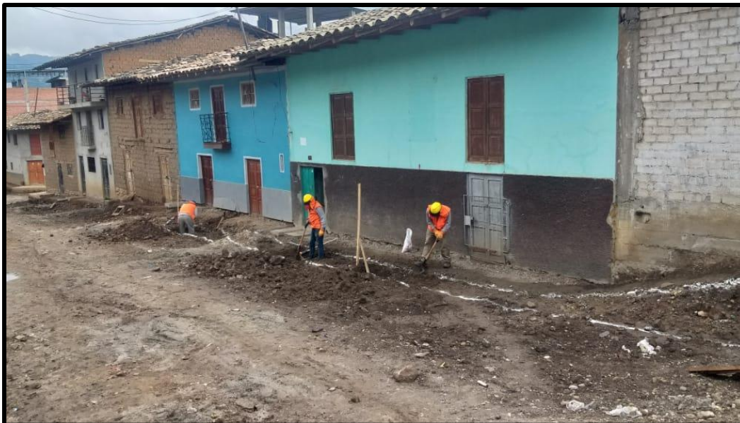
Excavación en terreno para el muro de contención de concreto armado en Jr. Nacarino.
