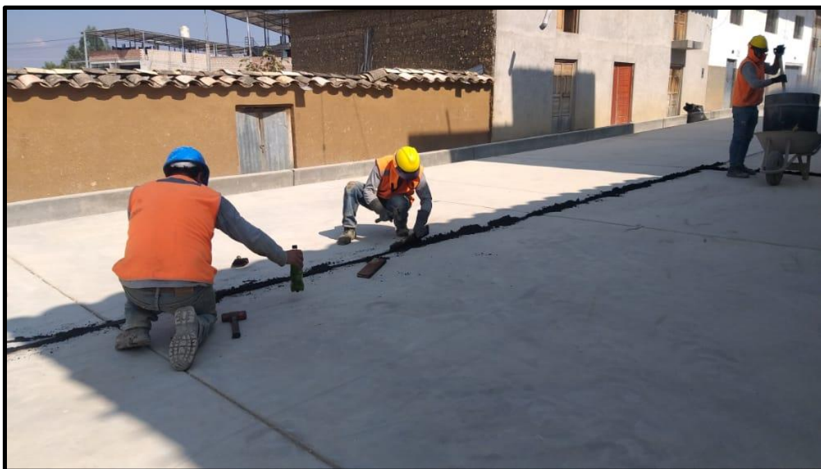
Compactación del asfalto en juntas del Jr. King.
