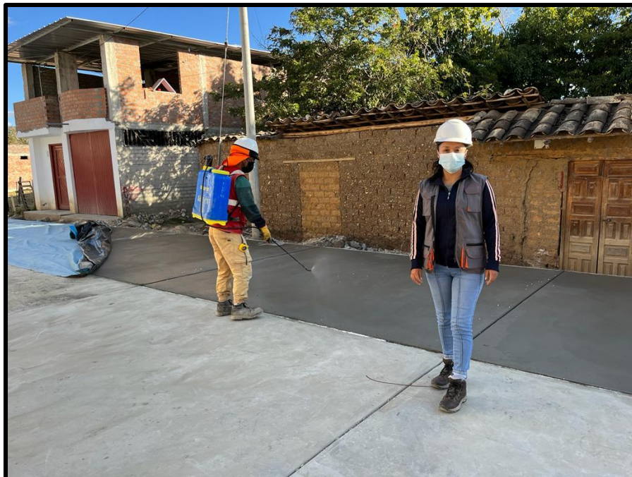
Curado de concreto con aditivo antisol en Jr. San Sebastián.
