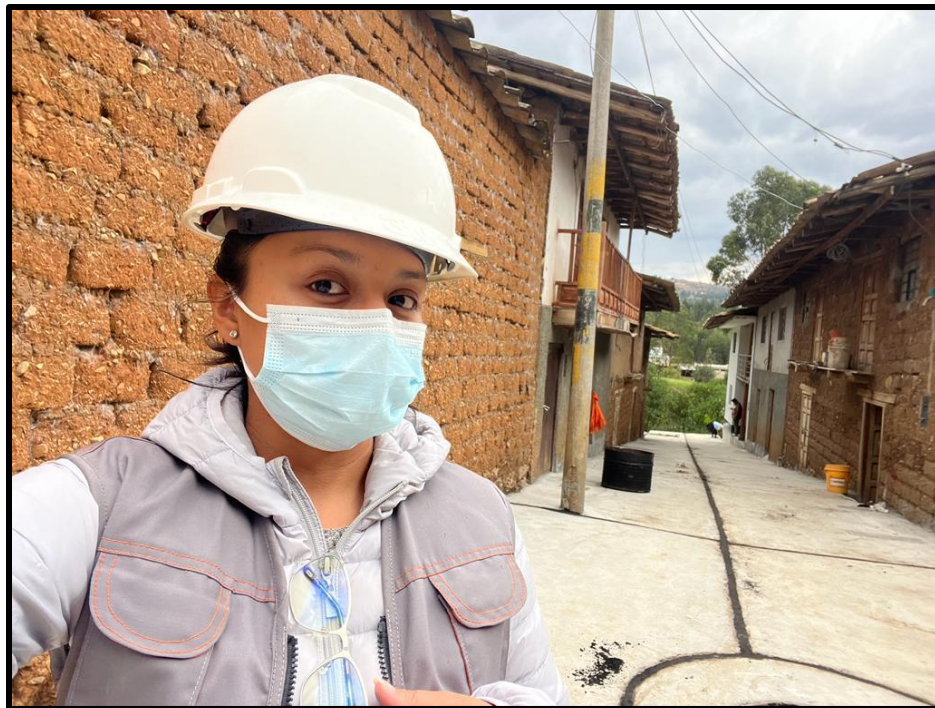
Culminación del vaciado de concreto f'c=210\text{kg/cm}^2 en pavimento del Pasaje 02.
