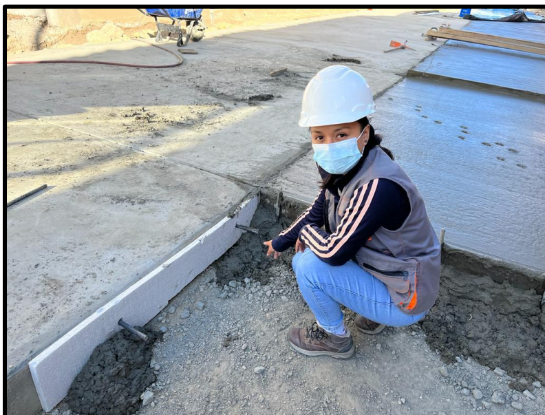
Colocación de dowel liso de \frac{3}{4} " grado 60 en juntas de dilatación en el Jr. San Sebastián.
