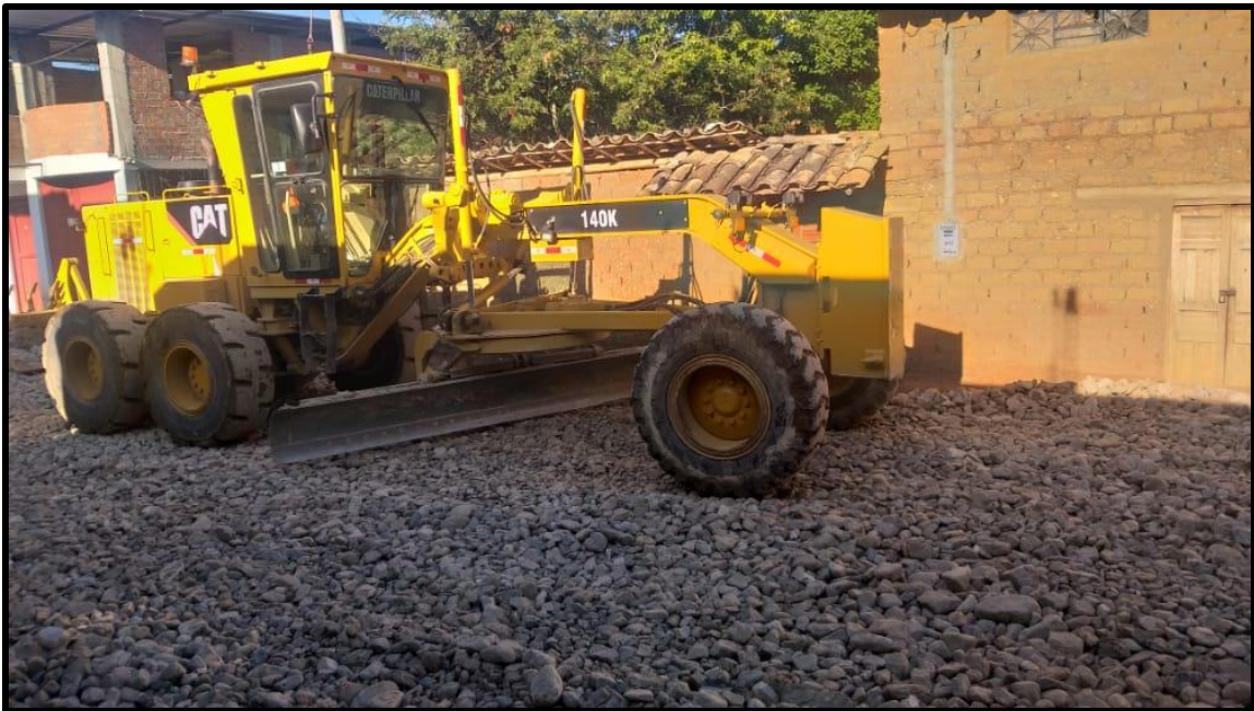
Mejoramiento con over en Jr. San Sebastián de la Cruz.
