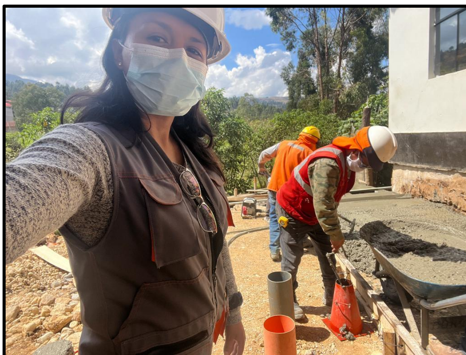
Encofrado y vaciado de pavimento rígido con la colocación de dowells acorde a planos.
