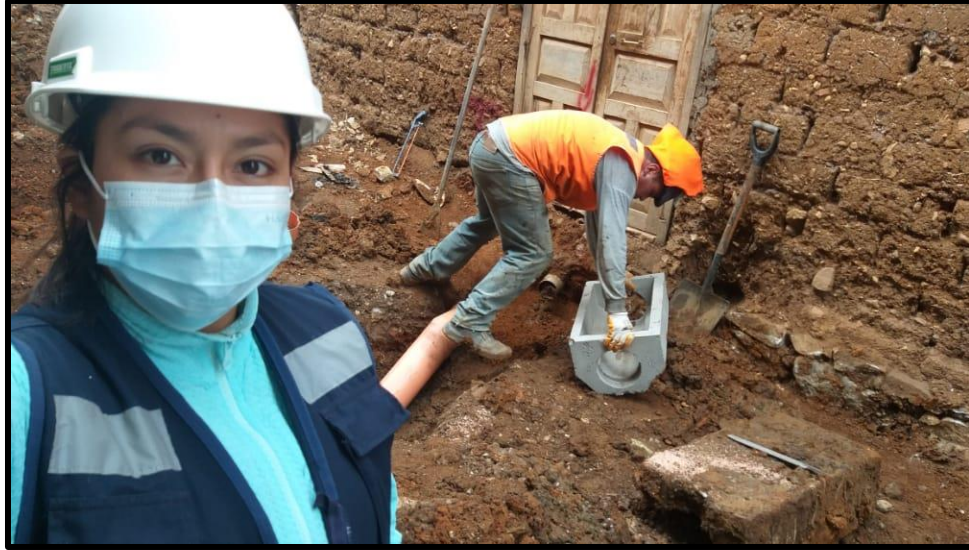
Reposición de las cajas de agua y desagüe en el pasaje 02.
