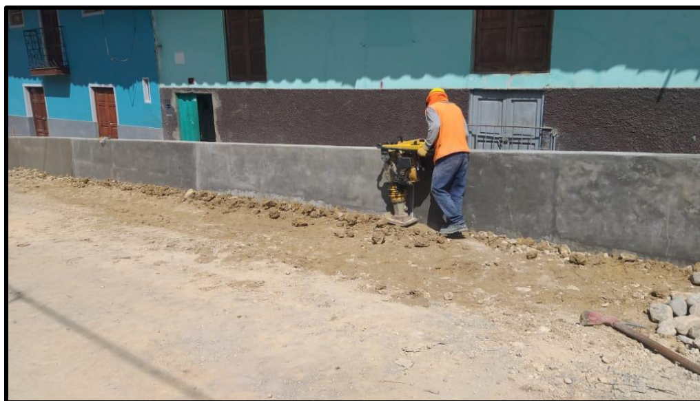
Relleno compactado con material de préstamo para el muro de contención de concreto armado en
