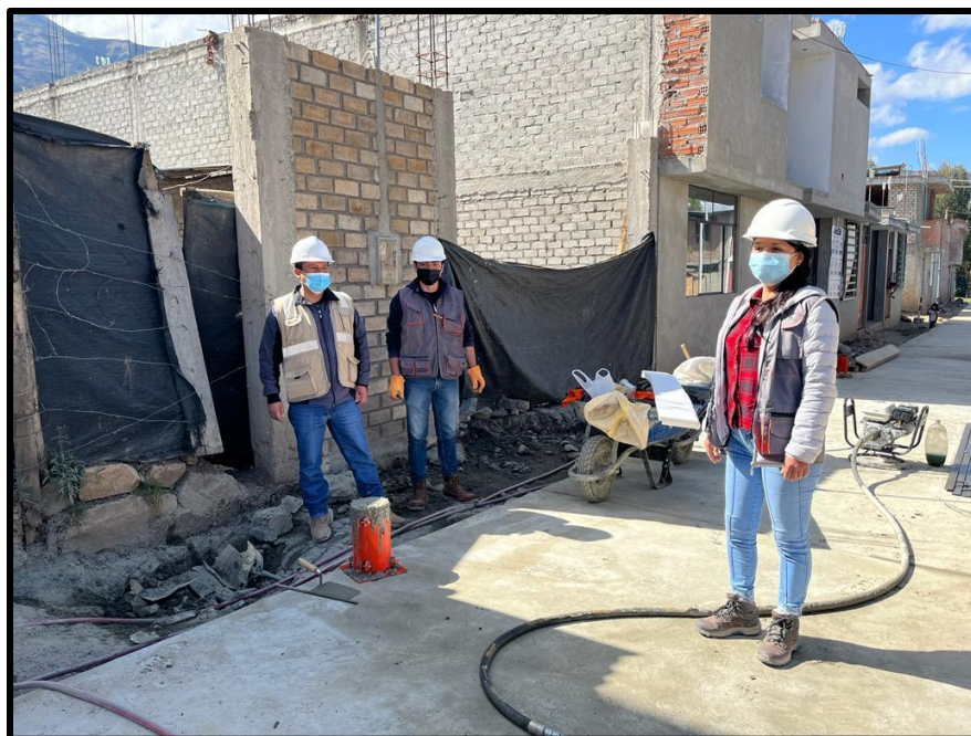
Realización de probetas en el vaciado del Jr. San Sebastián.
