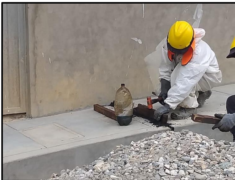
Sellado con asfalto en las veredas del Jr. Nacarino.
