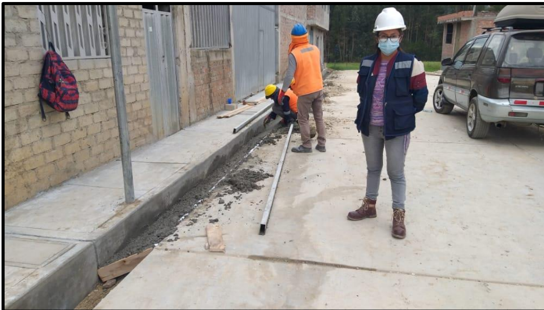
Vaciado de concreto F'c=175 Kg/cm 2 en cunetas del Jr. San Sebastián.
