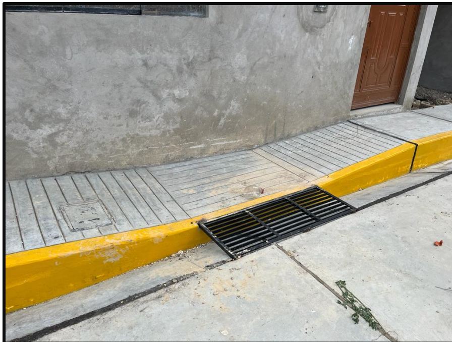
Colocación de rejillas para discapacitados en rampas de acceso.
