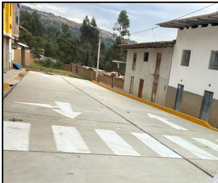
Trabajos de pintado de señalización en los Jirones del proyecto.
