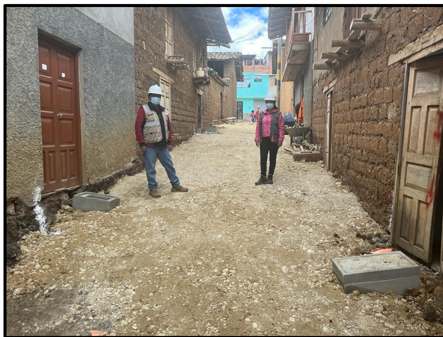
Compactación del afirmado en el pasaje 02, por parte de la supervisión y residente de obra.
