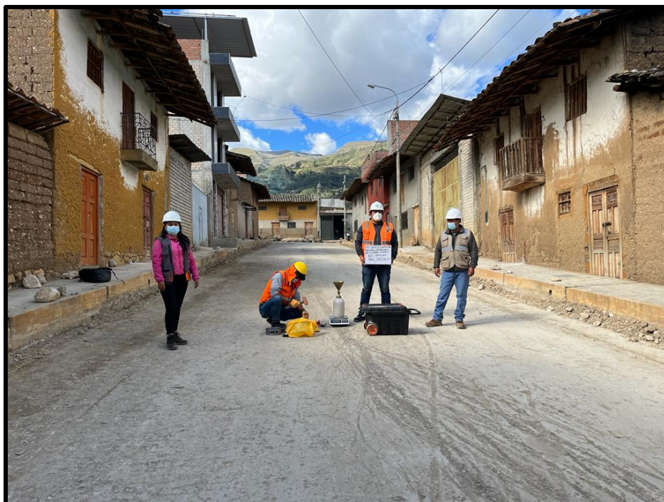
Ensayo de densidad del afirmado en el Jr. José Gálvez.
