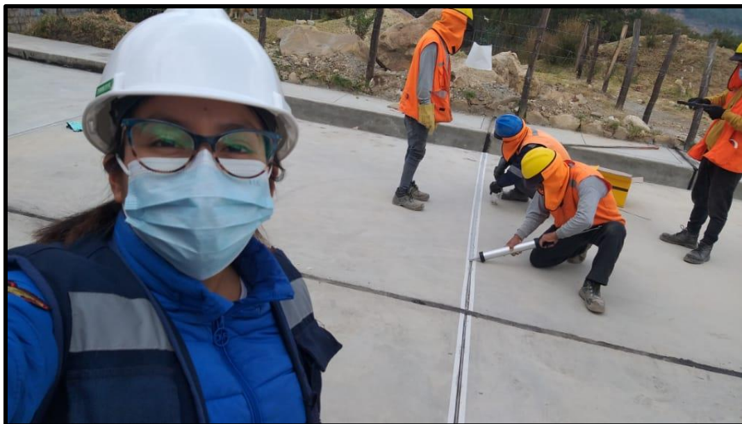
Sellado de las juntas elastoméricas de contracción en el Jr. San Sebastián.
