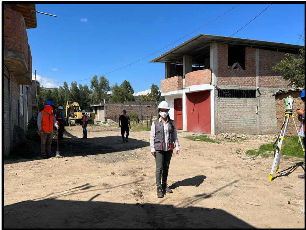
Trazo y replanteo con equipo.
