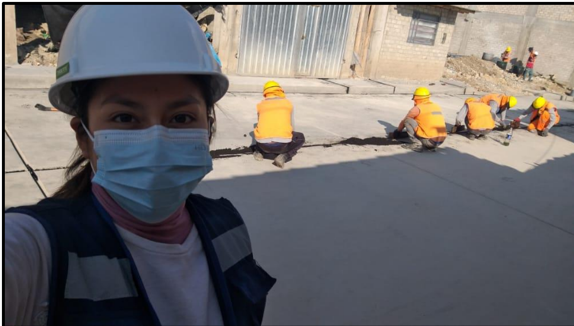
Sellado de juntas en el Jr. San Sebastián.
