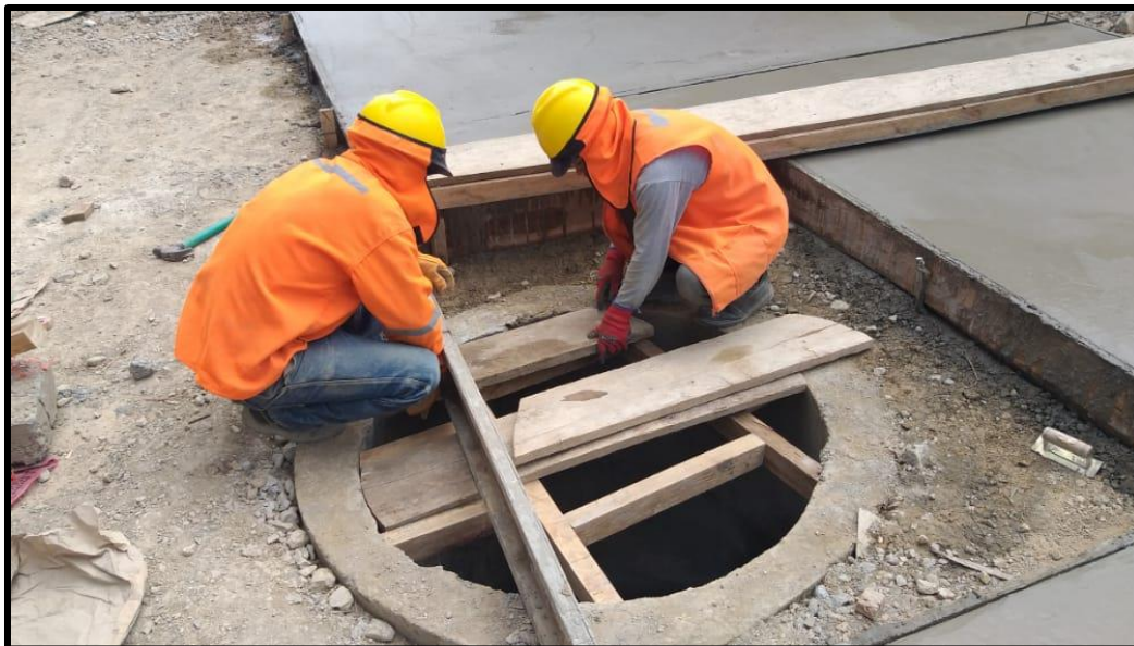
Encofrado y desencofrado de buzones en el Jr. San Sebastián.
