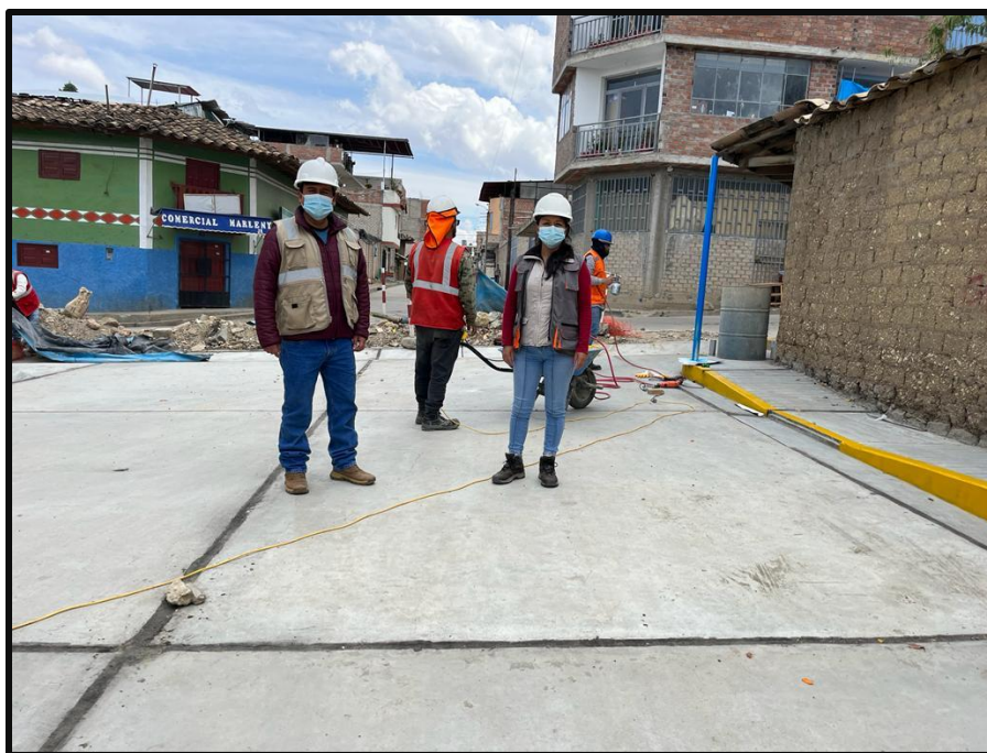
Pintado de las señalizaciones verticales en el Jr. San Sebastián.
