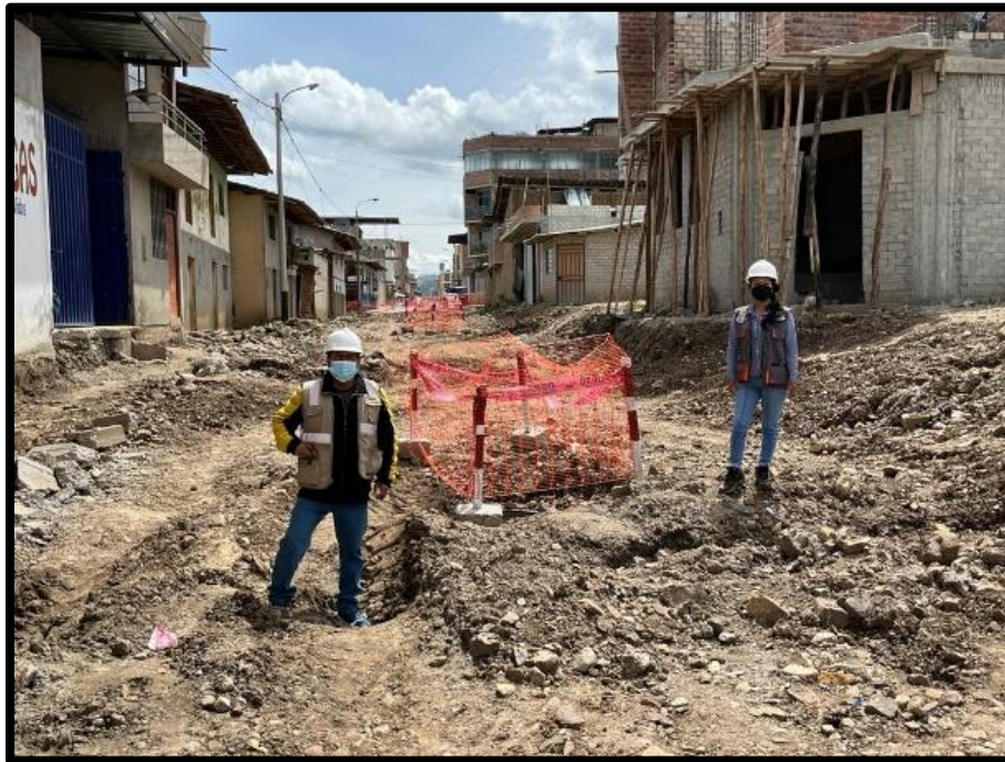
Señalización en obra durante ejecución.
