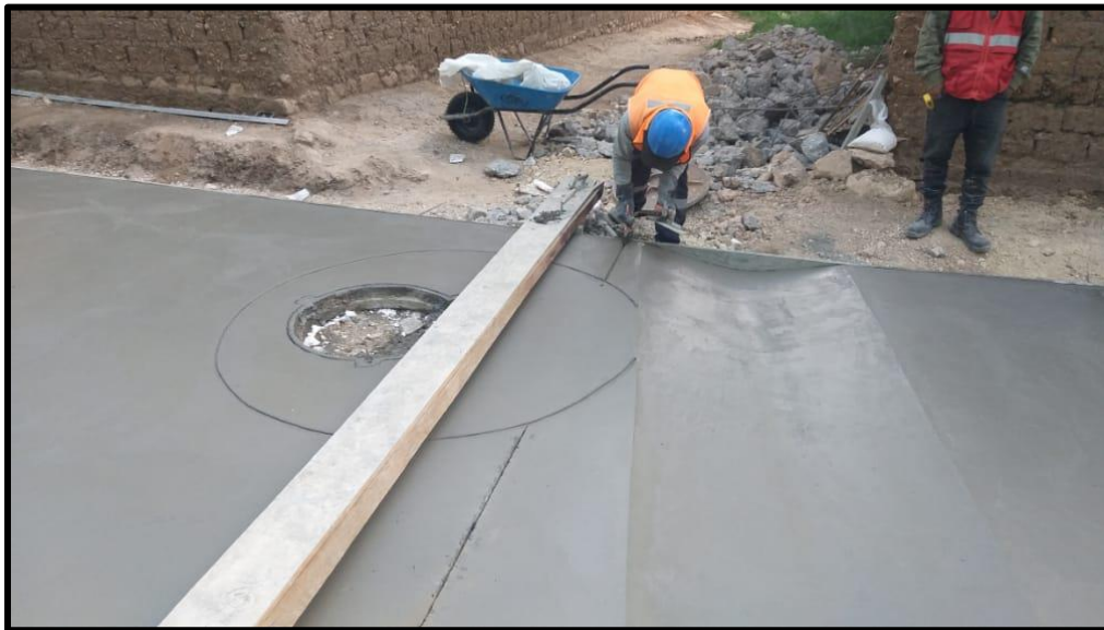
Acabado del baden ubicado en la Prolongación San Martin.
