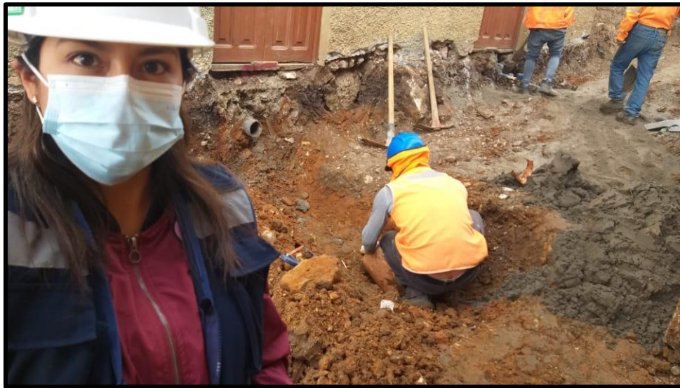
Reposición de las tuberías de agua y desagüe en el pasaje 02.
