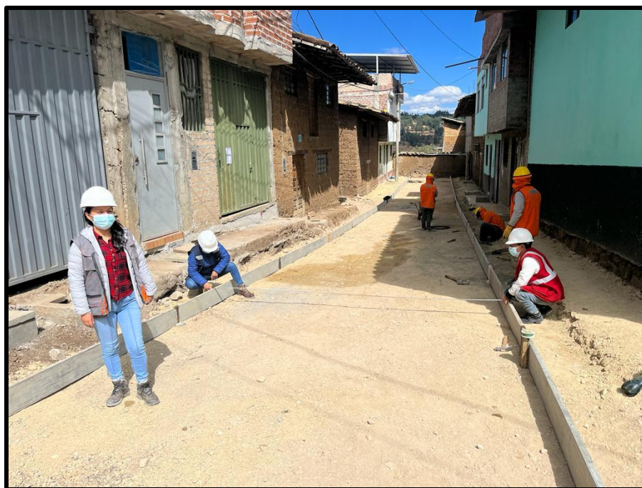
Encofrado y desencofrado de pavimento rígido en la Prolongación San Martín.
