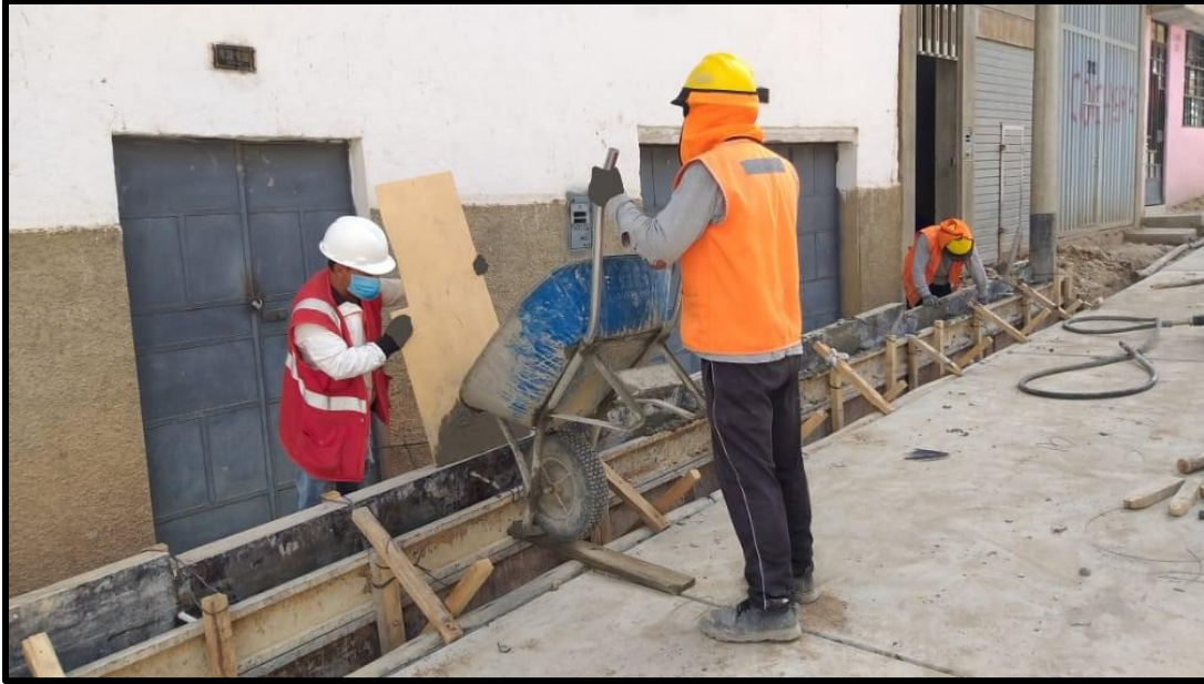
Vaciado de concreto F'c=175 Kg/cm 2 en sardinel del Jr. King.
