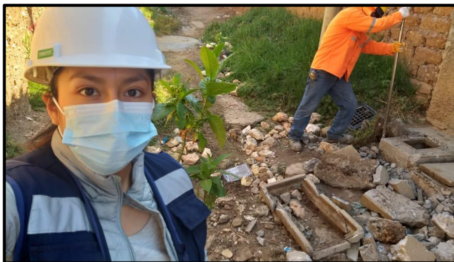
Demolición de las veredas existentes en el pasaje 02.
