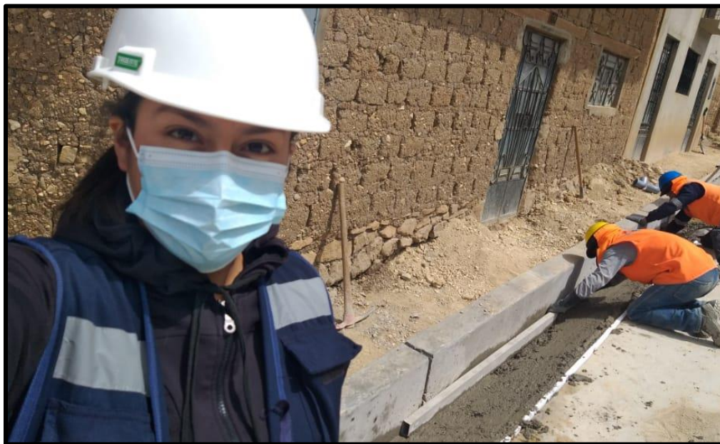
Vaciado de cunetas en el Jr. Nacarino.
