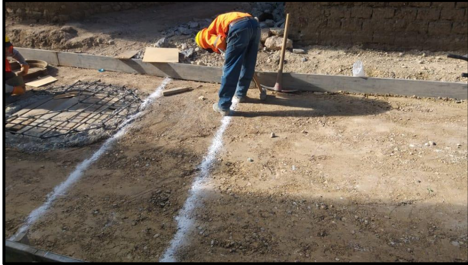
Trazo y replanteo para el vaciado de F'c=175 \text{ Kg/cm}^2 del baden ubicado en la Prolongación San Martin.
