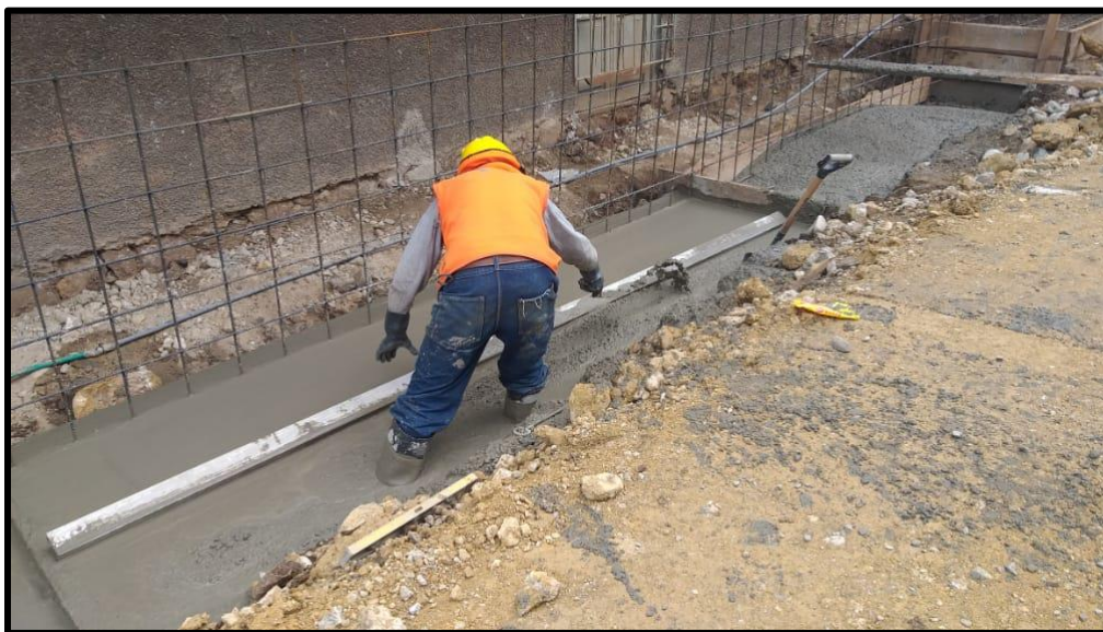
Concreto F'c=210 \text{ Kg/cm}^2 para el muro de contención de concreto armado en Jr. Nacarino.
