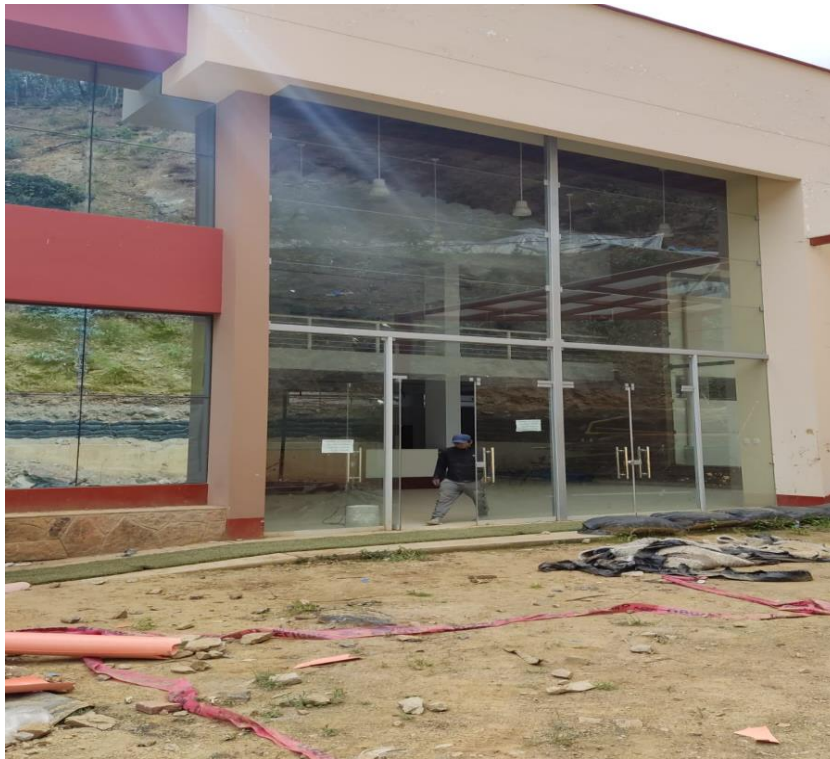
Gráfico 03. Edificación nueva (Biblioteca)
