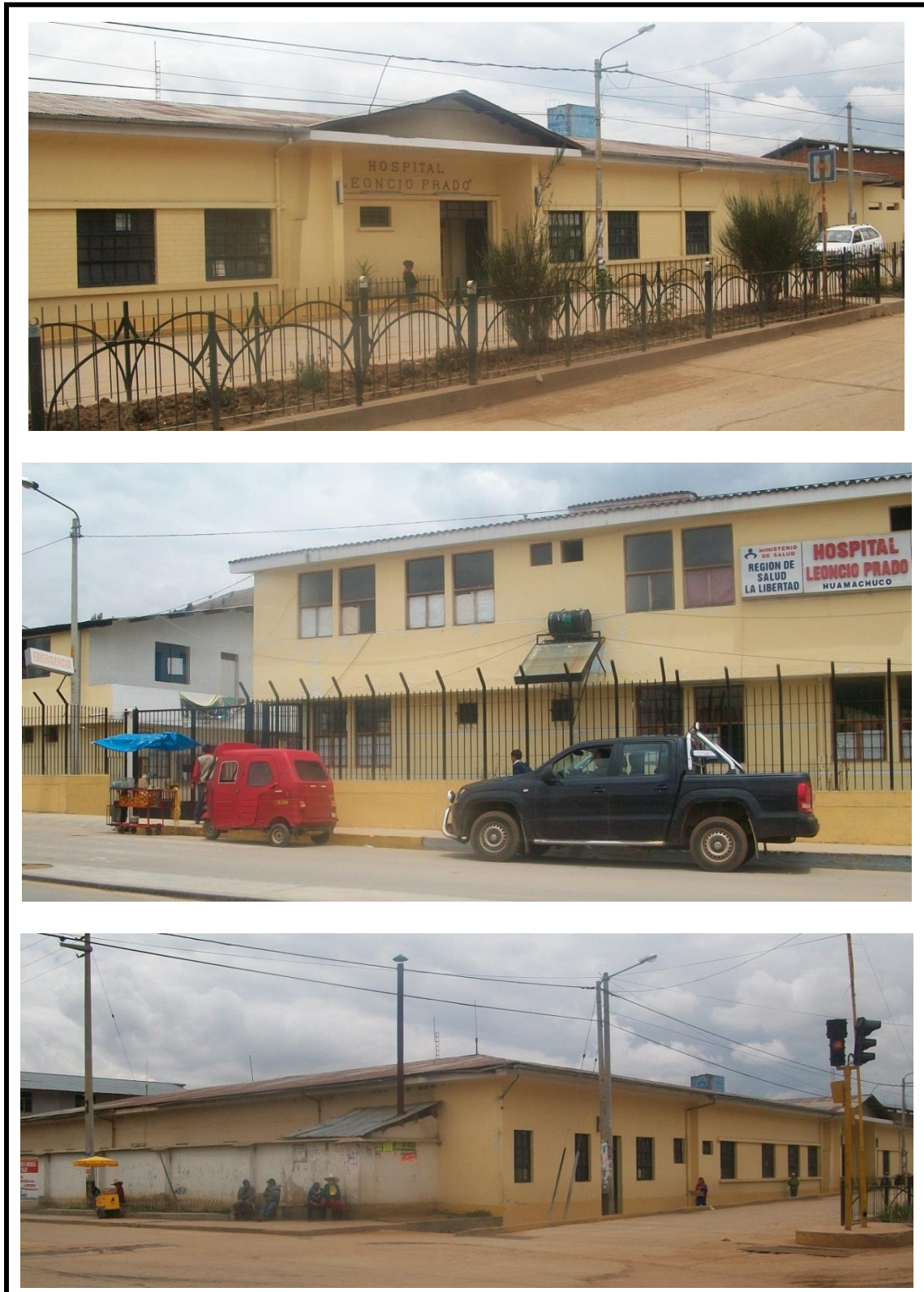
FIGURA 010: “Estado actual del Hospital Leoncio Prado de Huamachuco” FUENTE: Registro fotográfico propio – NOVIEMBRE 2014
