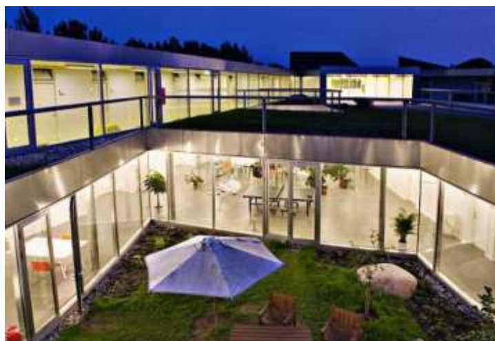
Figura N° 19, CORREDOR EXTERIOR DEL SEGUNDO NIVEL – HOSPITAL HELSENGOR
