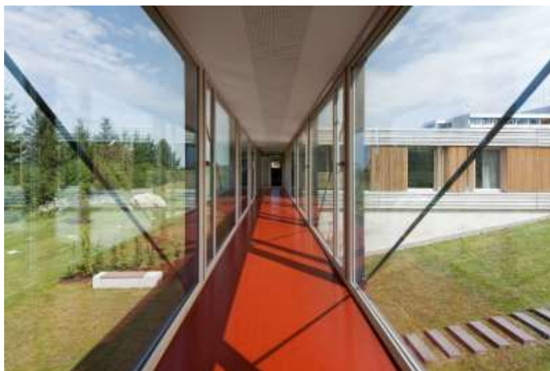
Figura N° 19, CORREDORES – CENTRO PSIQUIATRICO
