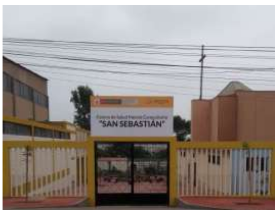
Imagen N° 21: Ingreso del CENTRO COMUNITARIO DE SALUD MENTAL SAN SEBASTIÁN.
