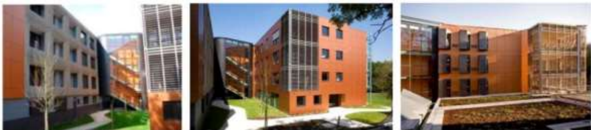
Figura N° 19, FACHADA PRINCIPAL– CENTRO PSIQUIÁTRICO DE BURES-SUR-YVETTE.
