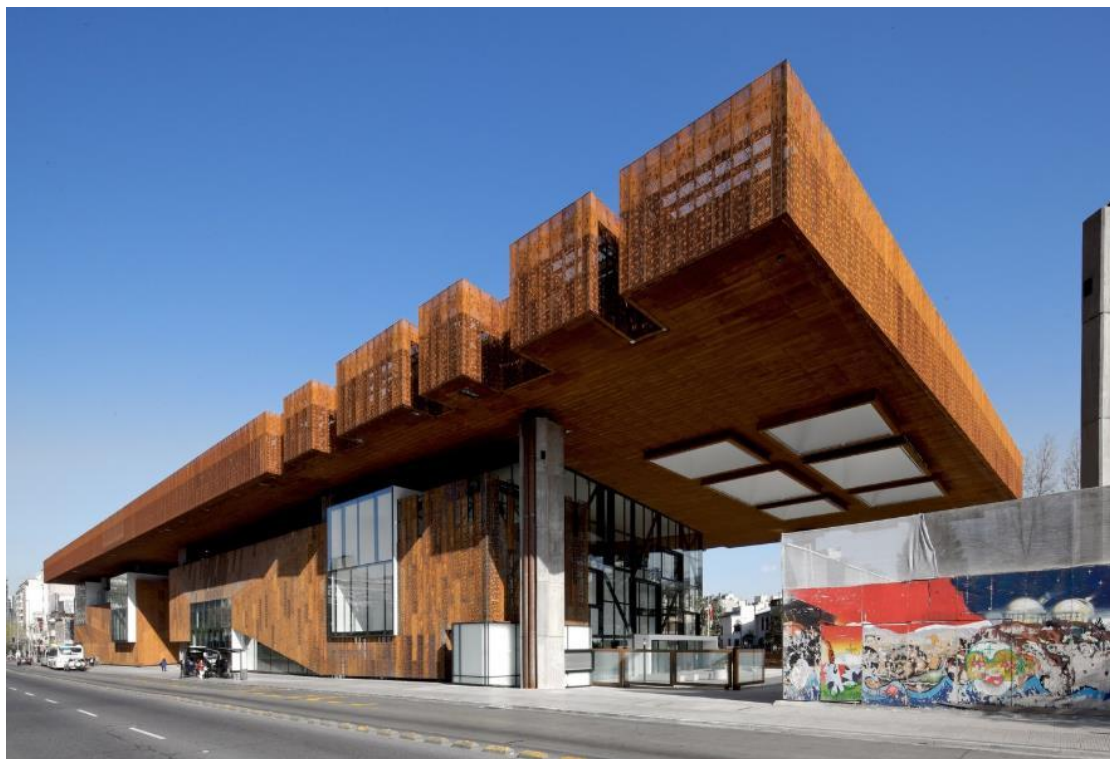
Figura. 72. Ingreso al edificio
