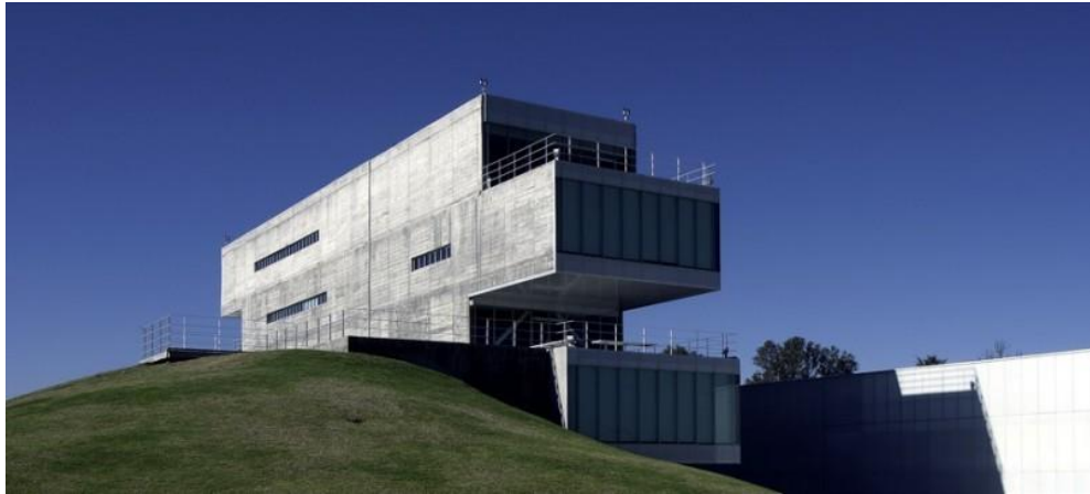
Figura 52. Vistas exteriores del proyecto
