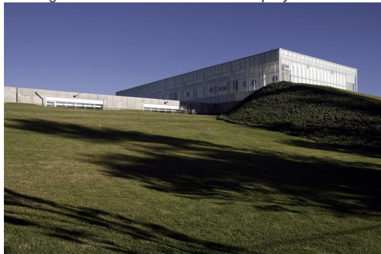
Figura 53. Vistas exteriores del proyecto
